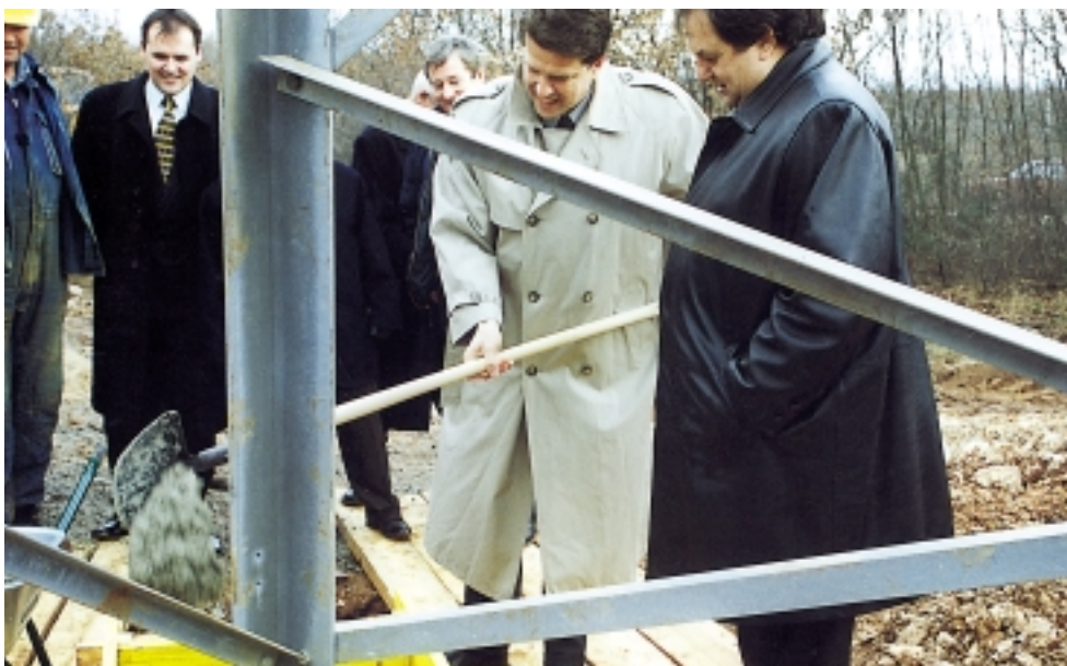
Mr. sc. Ivica Toljan, direktor Direkcije za prijenos HEP-a, simboličnim činom otvorio je radove na izgradnji dalekovoda
