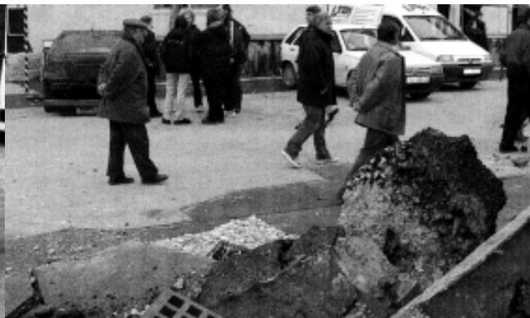
Najveća su oštećenja na Trgu 1. istarske brigade
