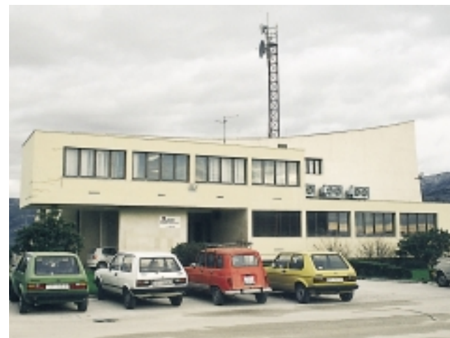
Poslovna zgrada na Vrboranu, gdje su se naši dispečeri priključili CDU i Odjelu vođenja Prijenosnog područja Split
