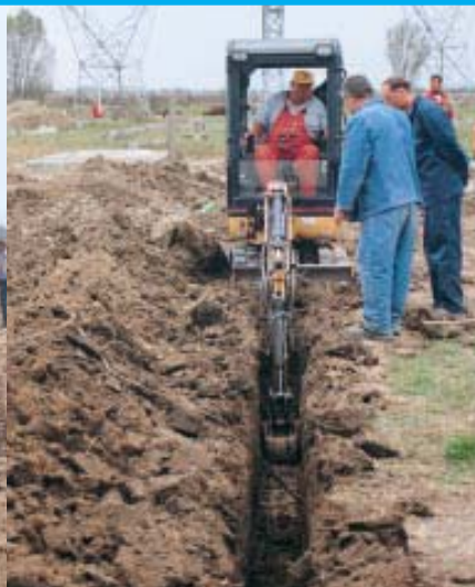
Kopa se kanal za nova uzemljenja
