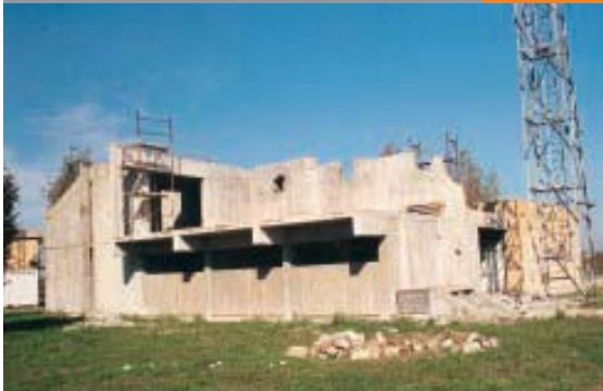
Nakon uklanjanja devastiranih zidova, zgrada upravljanja spremna je za obnovu
