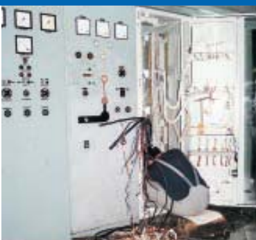
Zamjena zaštite generatora 1
