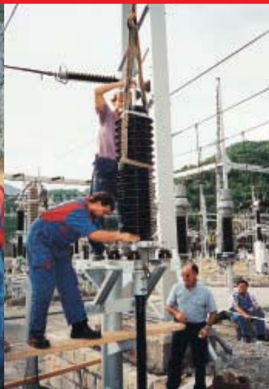
Stručnjak ABB-a Simeon Popov nadzire navlačenje izolatora
