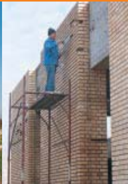
Na zgradi pomoćnog pogona obnavlja se fasada
