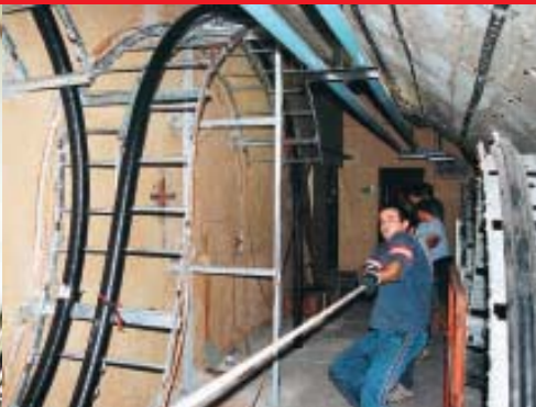
Najteži dio noćnog rada - postavljanje kabela na sinusoidalne nosače
