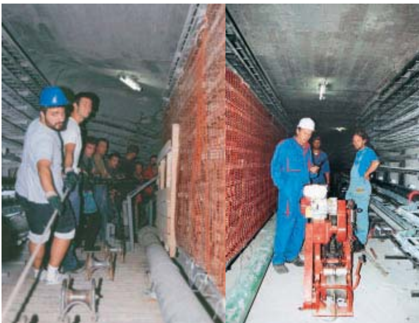
Kabel treba proći kroz 700 metara hodnika Elektrane
