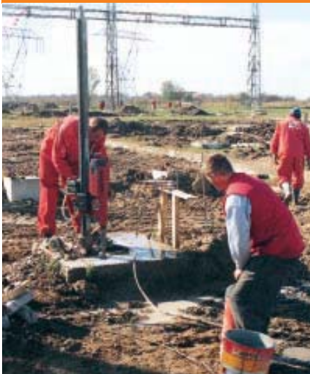
Bušenje rupa za sidrene vijke
