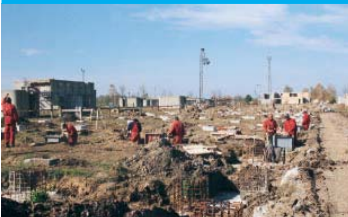
Dovršen je veći broj temelja na 400 kV strani
