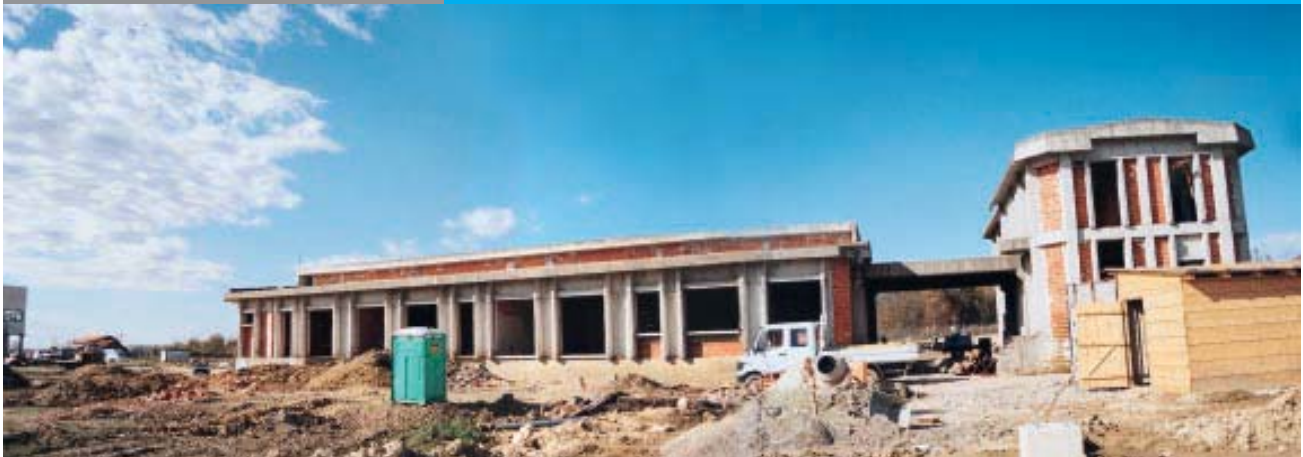
U zgradi 20 kV i zgradama upravljanja i pomoćnih pogona izvode se građevinski radovi, izrađuje bravarija, te obavljaju pripreme za početak izrade elektroinstalacija
