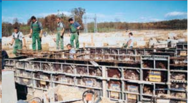
Snimili smo i radove na temelju za dizelski agregat u zgradi 20 kV postrojenja
