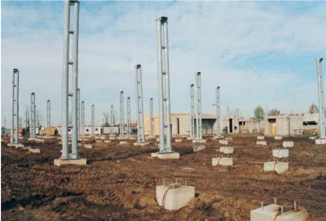
Gradilište TS Ernestinovo poprima novi izgled
