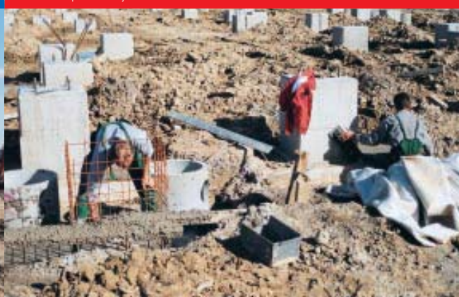
Radovi na stopama temelja na 110 kV
