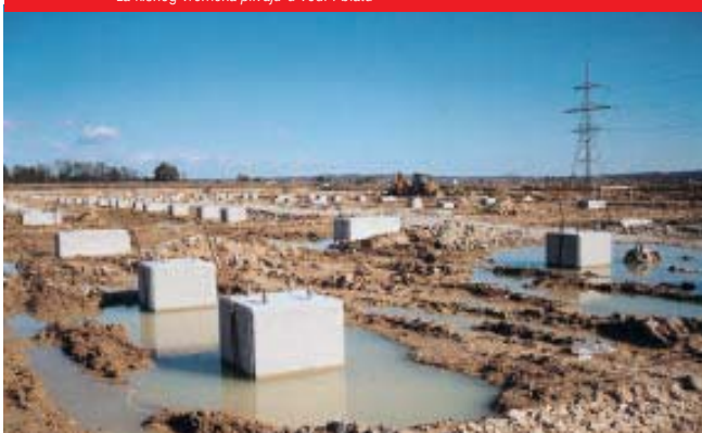
Na 400 kV strani postavljeno je do sada 410 temelja za visokonaponske aparate, koji za kišnog vremena plivaju u vodi i blatu
