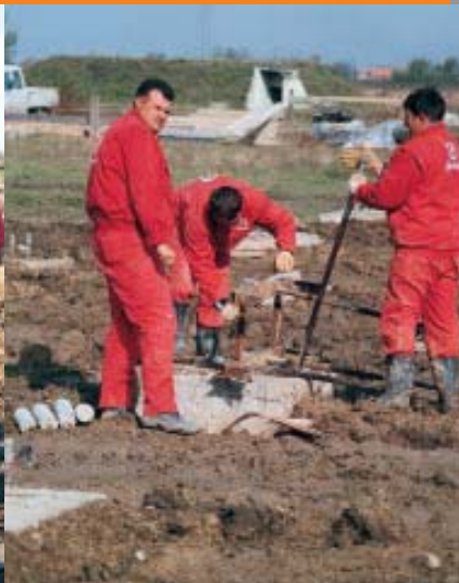
Priprema sidrenja vijaka za ugradnju u temelj
