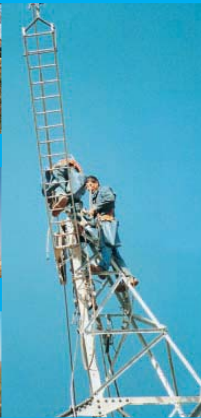
Dalekovodaši na vrhu stupa DV 400 kV Ernestinovo-Ugljevik
