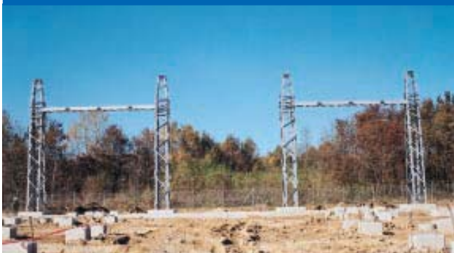
Na 400 kV strani postavljeno je do sada 410 temelja za visokonaponske aparate, koji za kišnog vremena plivaju u vodi i blatu
