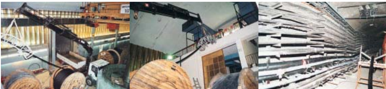
Zamjena 110 kV VN kabela - počelo je iz strojarnice, nastavilo preko galerije i završilo u kabelskom tunelu
