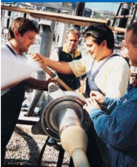
... i montaža vanjske kableske glave
