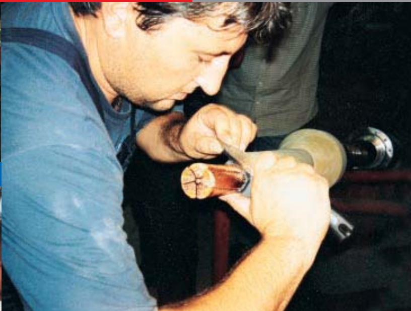
... a potom slijedi izrada unutrašnjih kableskih glava...
