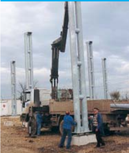
Montaža glavnih sabirnica je pri kraju
