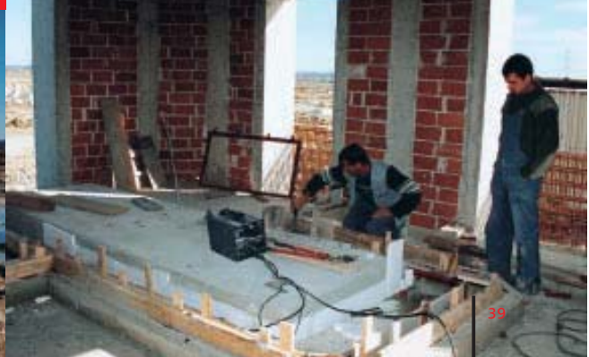
Snimili smo i radove na temelju za dizelski agregat u zgradi 20 kV postrojenja
