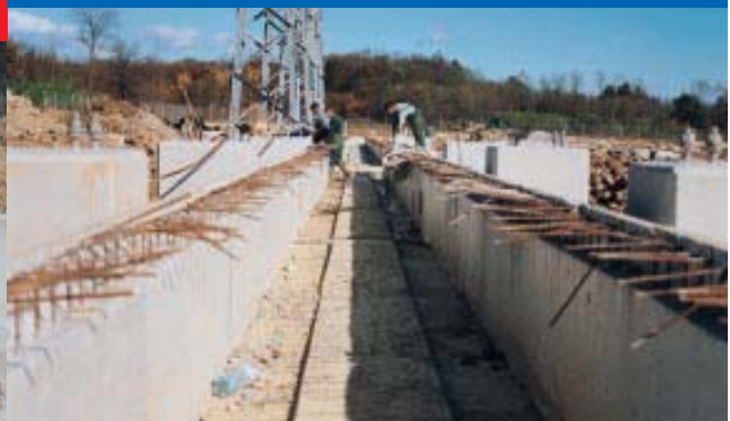
Postavljanje armature za temelje relejne kućice
