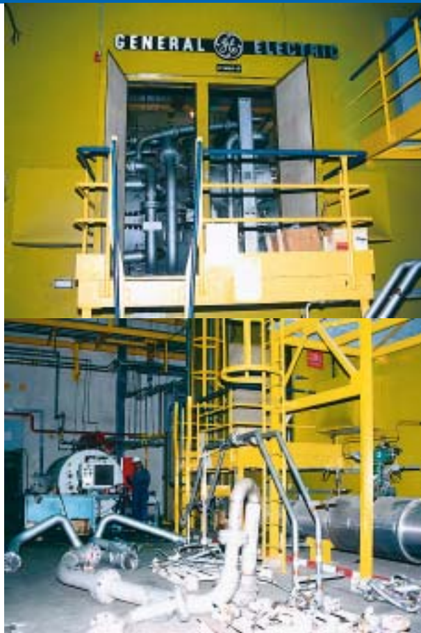
Brusi se obloga kotla-utilizatora (kotla na otpadnu toplinu) i obavlja inspekcija oplate
