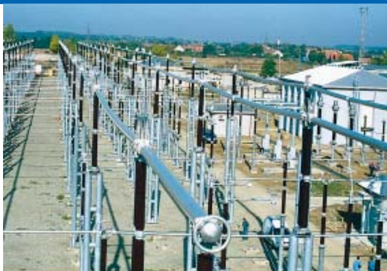
Sabirnice 400 kV (snimljeno sredinom rujna)
