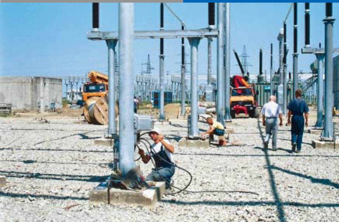
Postavljanje ožičenja za pogon 400 kV rastavljača (snimljeno 5. rujna)
