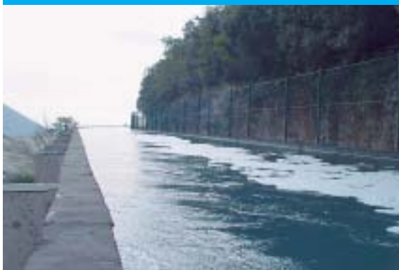
Dovodnim kanalom morske vode dnevno proteče milijun prostornih metara vode za rashlađivanje postrojenja
