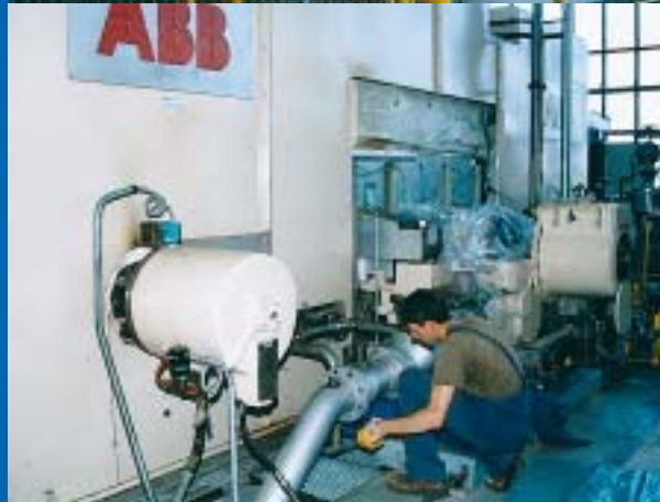
Obavljena je montaža svih cjevovoda veznih za plinske turbine (cjevovodi zraka, plina, demivode, ekstrakta lakog loživog ulja)
