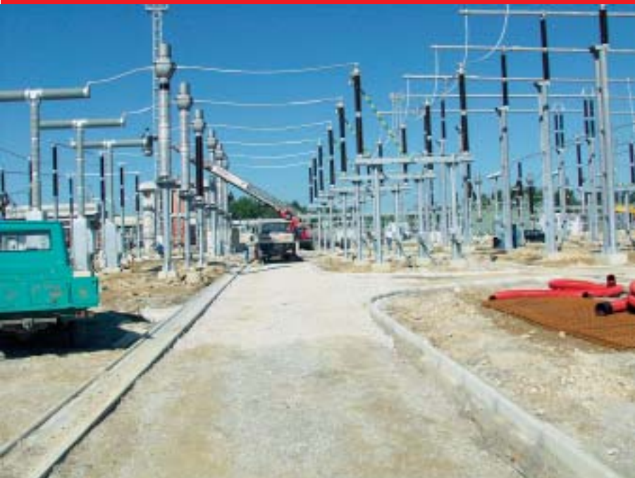
Montaža spojnih vodiča glavnog sabirničkog sustava na prekidaču u spojnim poljima GS 1 i GS 2
