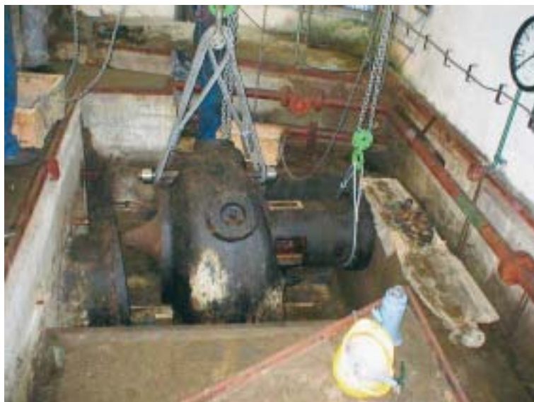
Demontaža regulatora tlaka
