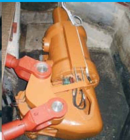
Novi servomotor s upotrijebljenim mehaničkim skopom i kućištem starog servomotora
