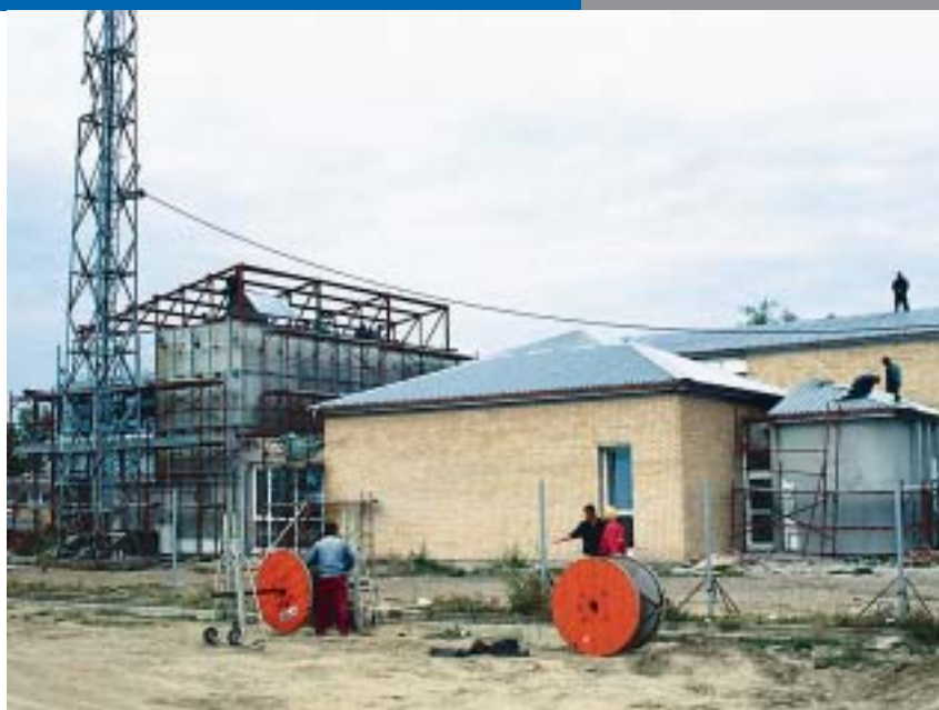
Glavna upravljačka zgrada: dovršava se postavljanje kosog krova...
