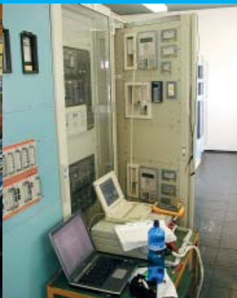
Nove numeričke zaštite blok-transformatora BT1 i BT2 u fazi parametriranja i ispitivanja
