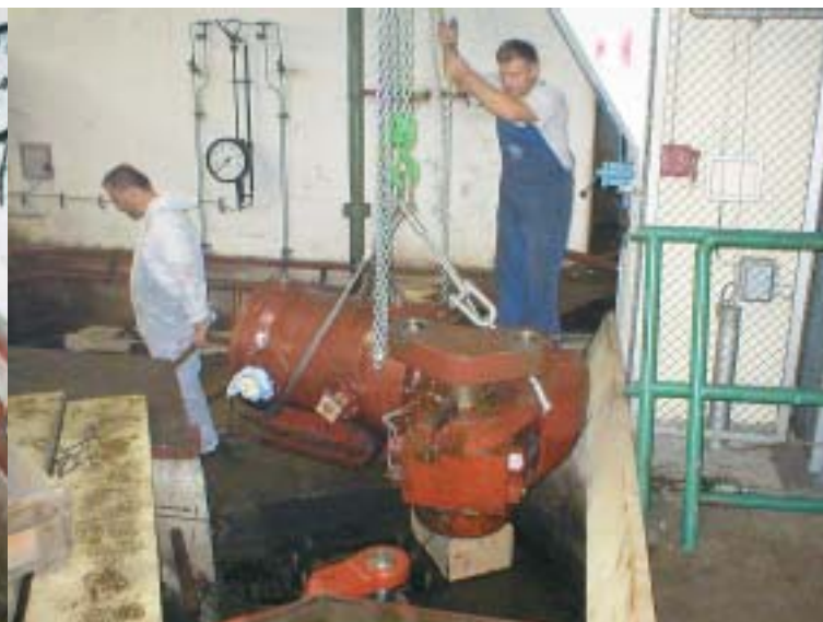
Demontaža starog servo motora privodnog kola ...
