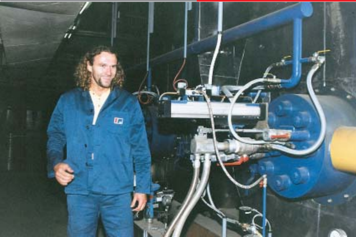
Krešimir Gregurić, pomoćnik strojara kotla uz jedan od osam novih (na oba kotla bloka 1) gorača, koji omogućuju smanjenje emisije NO x , kao i unaprjeđenje postrojenja (istodobno korištenje na jednom kotlu i plina i mazuta)
