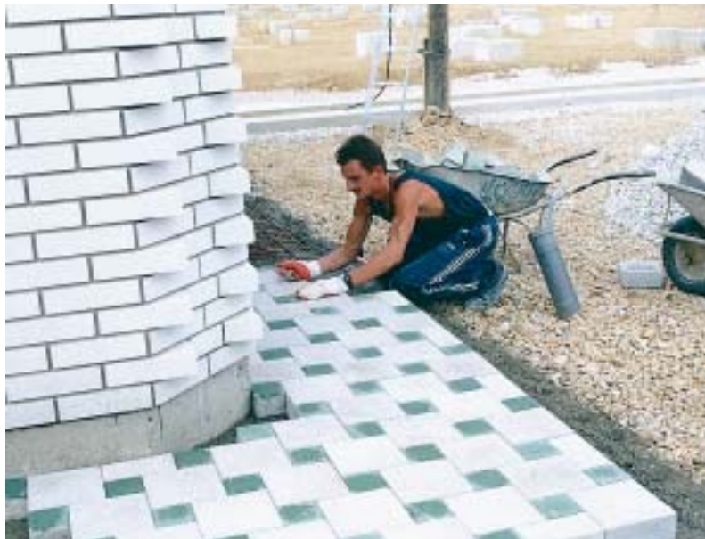
Postavlja se opločnik relejne kućice
