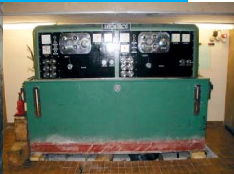
Stari mehaničko-hidraulički akcelorotahometrijski turbinski regulatori Litostroj AT5 u fazi demontaže
