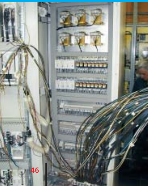
Novi ormar s opremom električkih zaštita blok-transformatora BT1 i BT2 u fazi ugradnje
