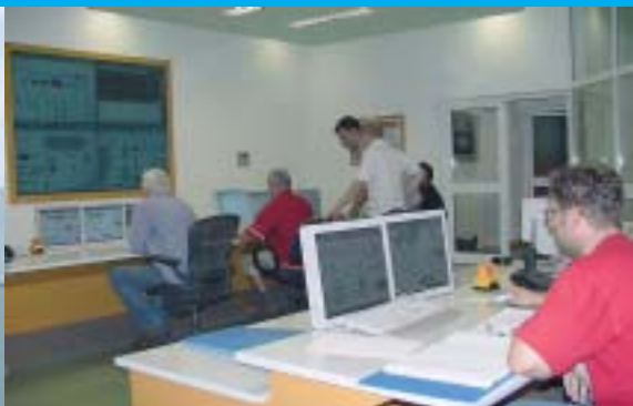
Digitalizirana upravljačka prostorija odnedavno i u Plominu 1 i novi pult s kojega se elektranom upravlja korištenjem miša
