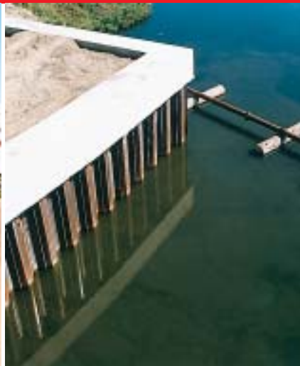
Na crpnoj stanici rashladne vode sanirana je konstrukcija dijafagme
