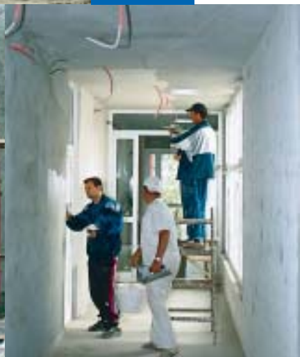
... obrtnički radovi interijera su u završnici
