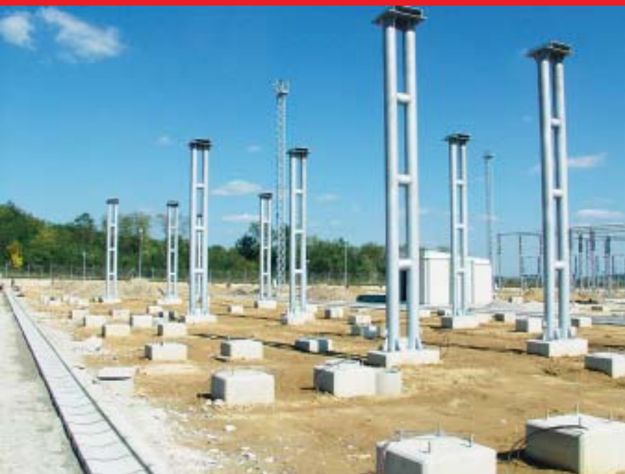
Započela je montaža čelične konstrukcije na postoljima aparata u RP 220 kV
