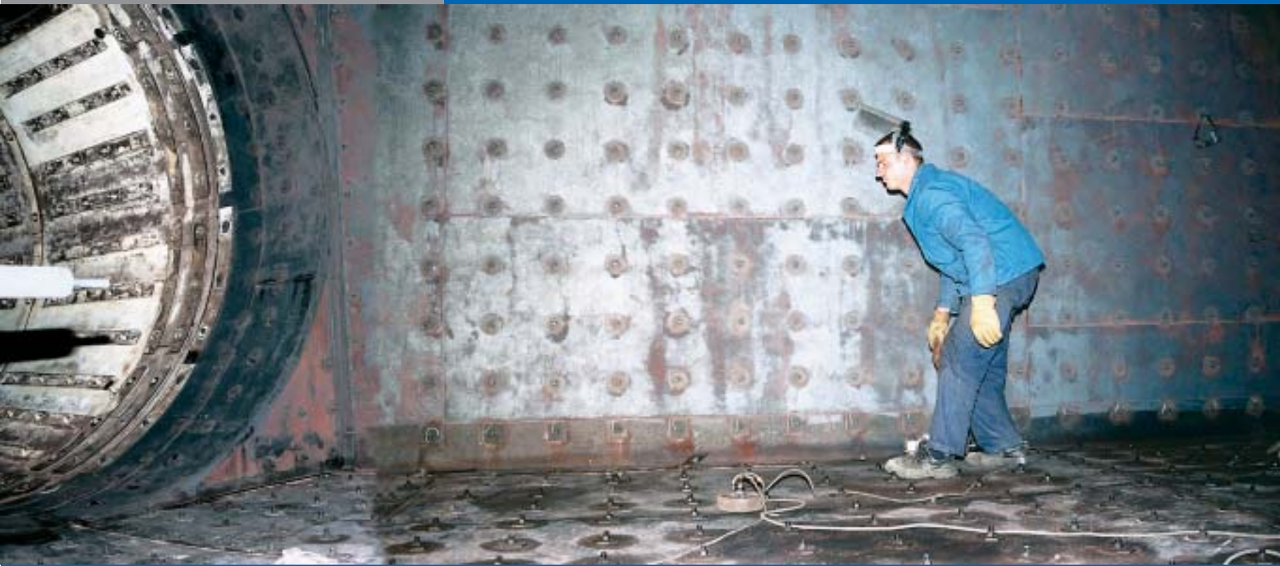
Brusi se obloga kotla-utilizatora (kotla na otpadnu toplinu) i obavlja inspekcija oplate
