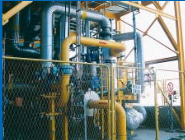
Plinska turbina: vidi se jedna od šest komora izgaranja
