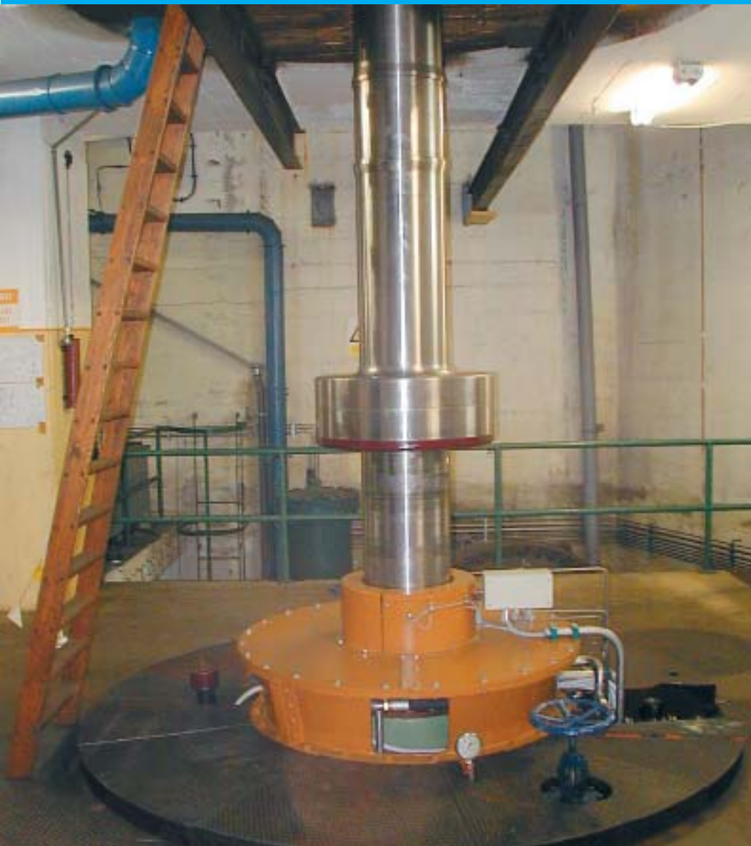
Jedan od agregata u turbinskom prostoru nakon ovogodišnjih zahvata
