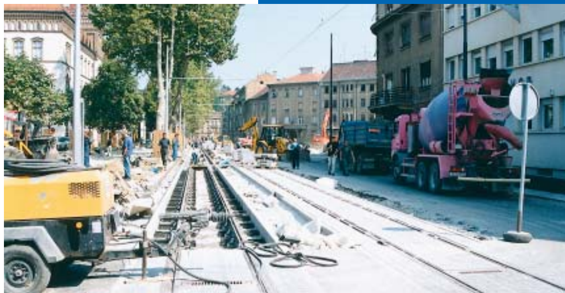
Potkraj kolovoza radovi na Ulici Republike Austrije privode se kraju
