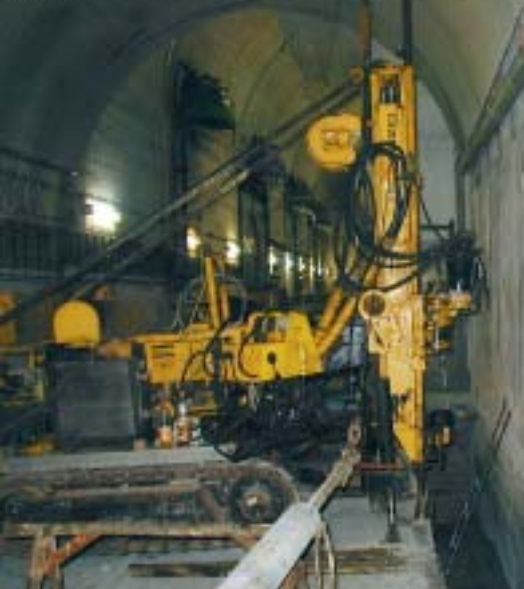
Bušenje okomice za kabele AC zamota
