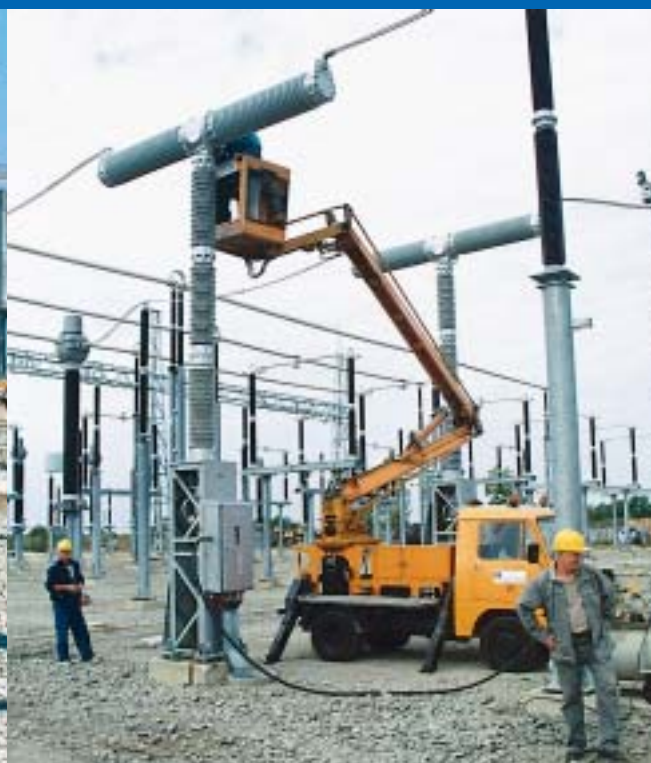
Završna montaža 400 kV prekidača
