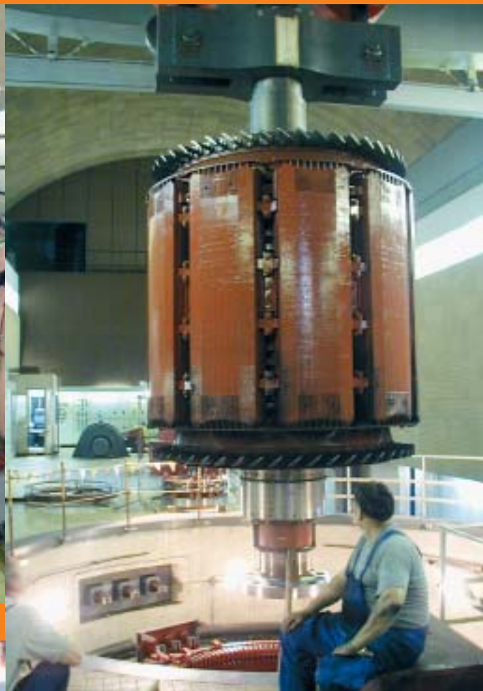
Podizanje rotora generatora
