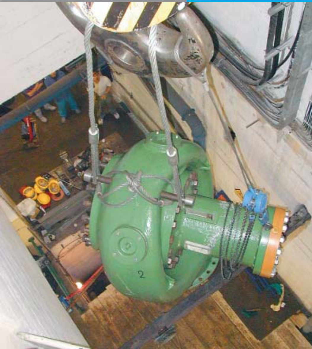
Regulator tlaka revidiran i prilagođen na viši tlak uljnog dijela hidraulike u povratku na montažu
