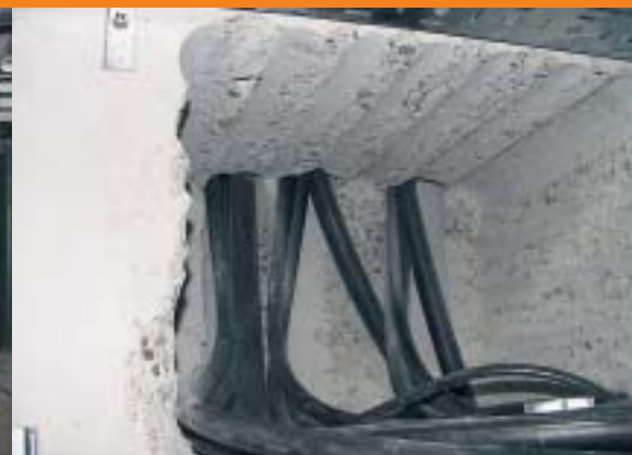
Nije bilo lako izbušiti i izrezati debele betonske blokove da bi bilo mjesta za kabele
