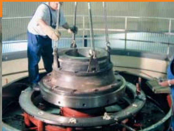
Demontaža zvona nakon zagrijavanja
