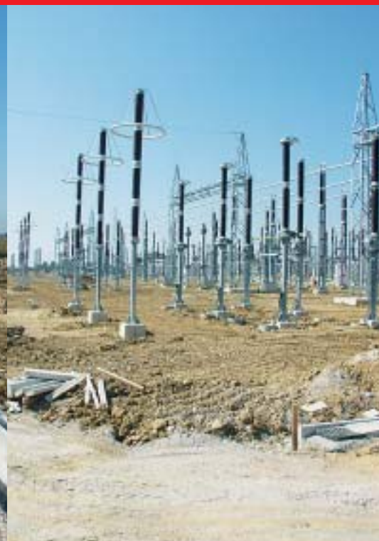
Odvodnici prenapona u 400 kV DV polju Heviz 2
