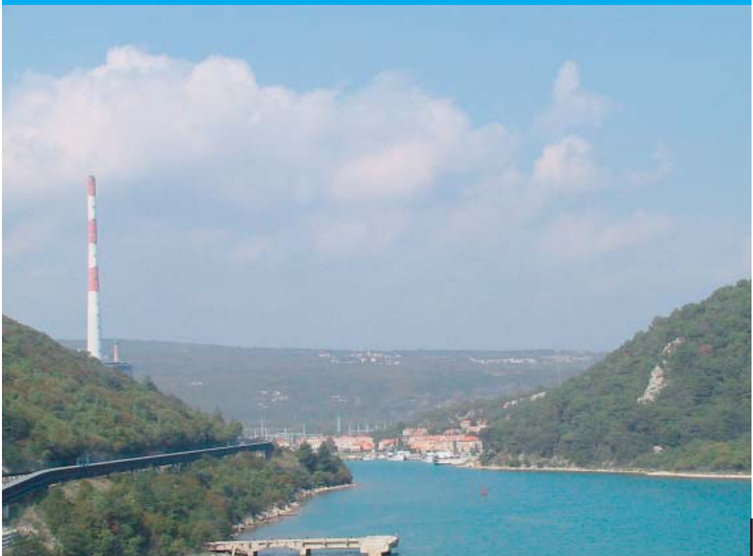
Pogled s broda na Plomin luku i dimnjak elektrane
