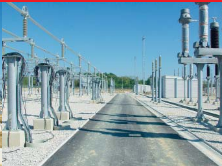
U RP 110 kV još nisu montirani prekidači
