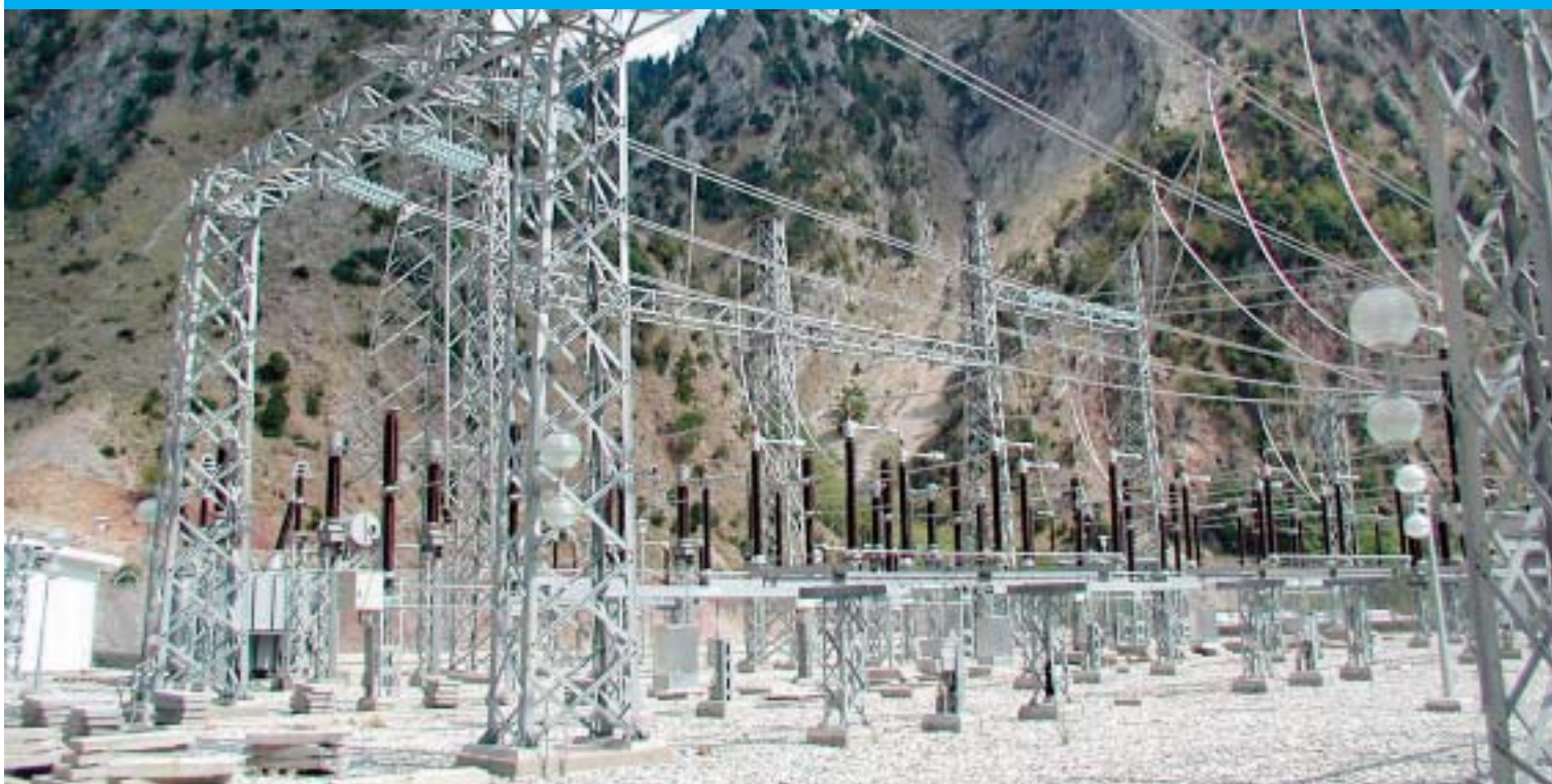
Rasklopno postrojenje HE Messochora gdje je Končar KET primijenio novo rješenje sabirnica, drukčiji nego u objektima HEP-a
