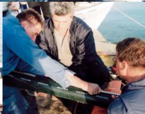
Spojnica je završena! Još samo manžeta sa staklenim vlaknima... i kabel može u more
