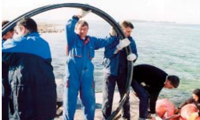
Kabel se odmata i nježno postavlja na jastuke
