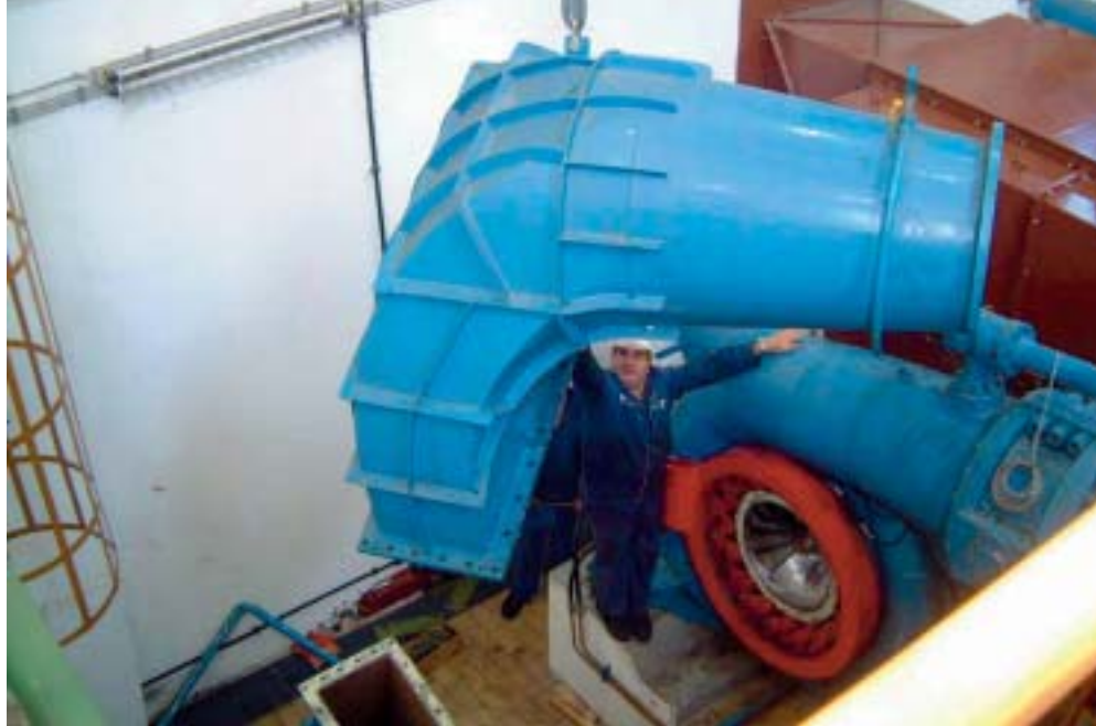
Nakon obavljenog remonta ABM-a, sastavljanje...
