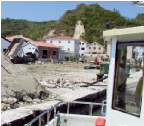
Razrovane ulice Suska svjedoče o velikom gradilištu i oživljavanju otoka
