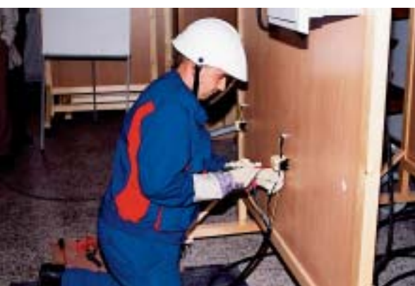
V. Topić je članovima Povjerenstva demonstrirao spajanje i odspajanje PRST stezaljke pod naponom
