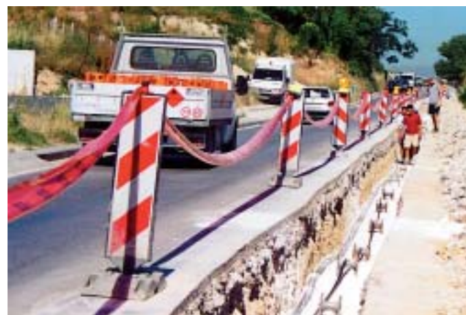
Polaganje i nadzor – radnici Službe za izgradnju i usluge
