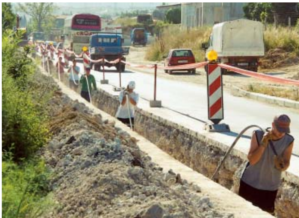
Posljednjih dana lipnja položene su i posljednje dionice kabela
