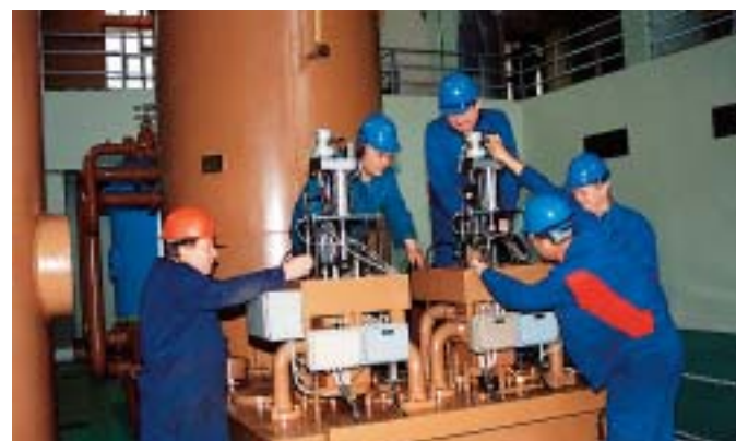
Strojarska služba u akciji
