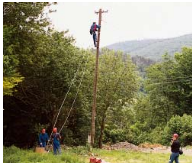
Na sljedećem stupu za rad pod naponom se pripremao Zoran Jogun uz potporu s tla kolega Željka Maravića i Vinka Topića
