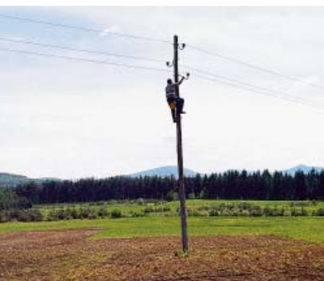
Na DV 10 kV Plaški - Vojnovac na zamjeni vodiča radi VKV monter Željko Capan
