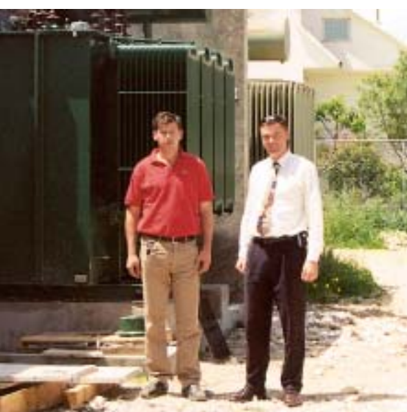
Ivica Katić i Domagoj Milun ispred novog transformatora, svakodnevno prate obnovu TS Trogir
