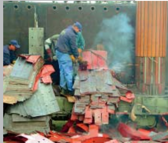
Rezanje transformatora, koji je u službi od 1953. godine
