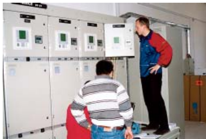
U TS Oštarije upravo se završava ispitivanje, upravljanje i povezivanje s DC u Karlovcu i CUP Ogulin
