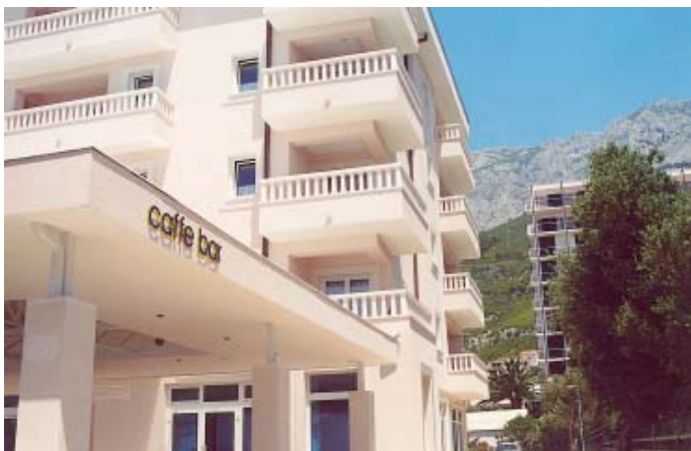
Za novoizgrađene podbiokovske hotele Pogon Makarska izgradio je priključne instalacije – ovo je hotel Tamaris u Tučepima
