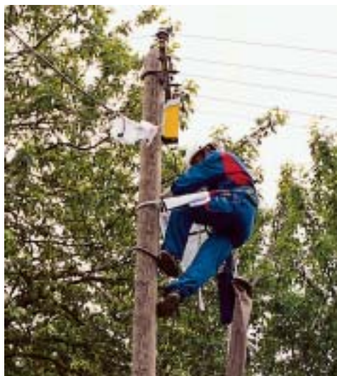
Prije skidanja izolatora, odnosno odvezivanja veznog užeta koje drži vodič uz izolator trebalo je fleksibilnom izolacijskom prekrivkom prekriti sve metalne dijelove i vodiče s obje strane
