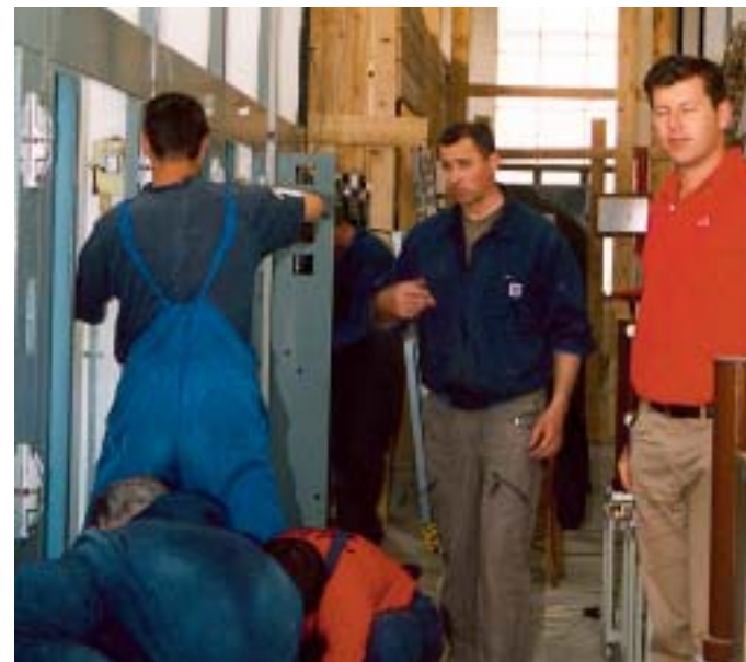
Radnici SIU izvode nove ćelije 10 kV u TS 35/10 kV Trogir
