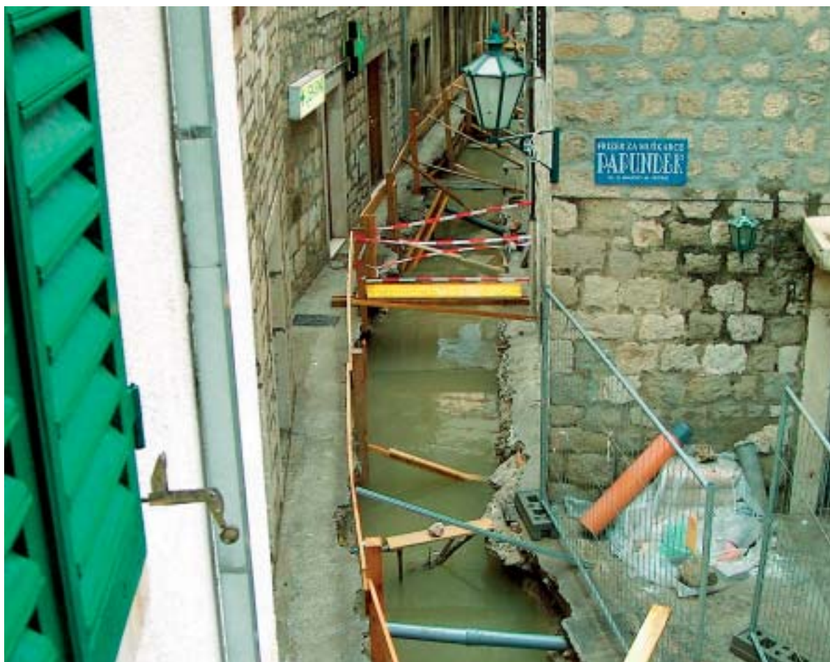
Pri kabliranju zračne mreže u starom dijelu Omiša najveća poteškoća je blizina mora, pa su zbog toga u kanalima neprekidno bile uključene muljne crpke
