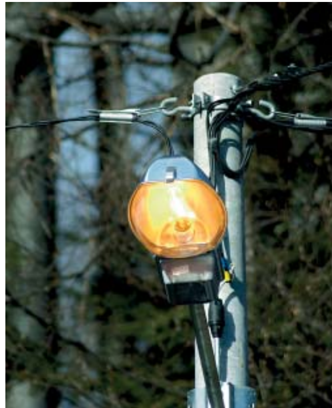
Na dijelu sljemenske ceste obnovljena je javna rasvjeta
