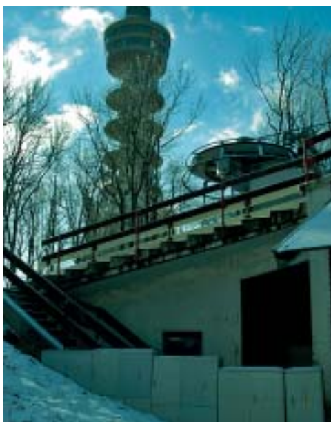
Obnovljena je Trafostanica 10/20/0,4 kV u sklopu gornje stanice žičare
