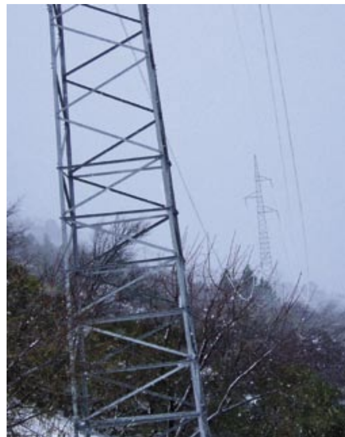
Na području oko Makarske je zbog velike količine snijega i leda na vodičima pojedinih raspona došlo do pojave poznate kao elastična deformacija
