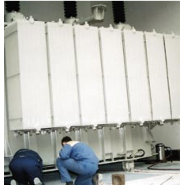
Prvi transformator je na mjestu – radnici Končara DIST-a montiraju opremu
