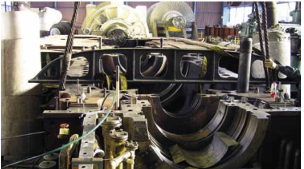
Kučišta visokog tlaka i, u pozadini, rotor niskog tlaka za vrijeme remonta
