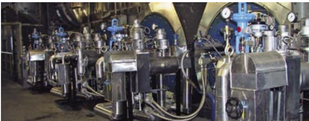
Novi plamenici tvrtke Mehladau & Steinfacht u sustavu potpale s veoma niskim NOx koji će smanjiti emisije štetnih tvari u zrak
