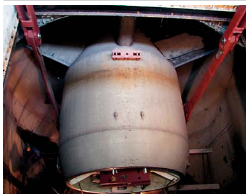
Priprema za odvajanje sklopa generatora od turbine
