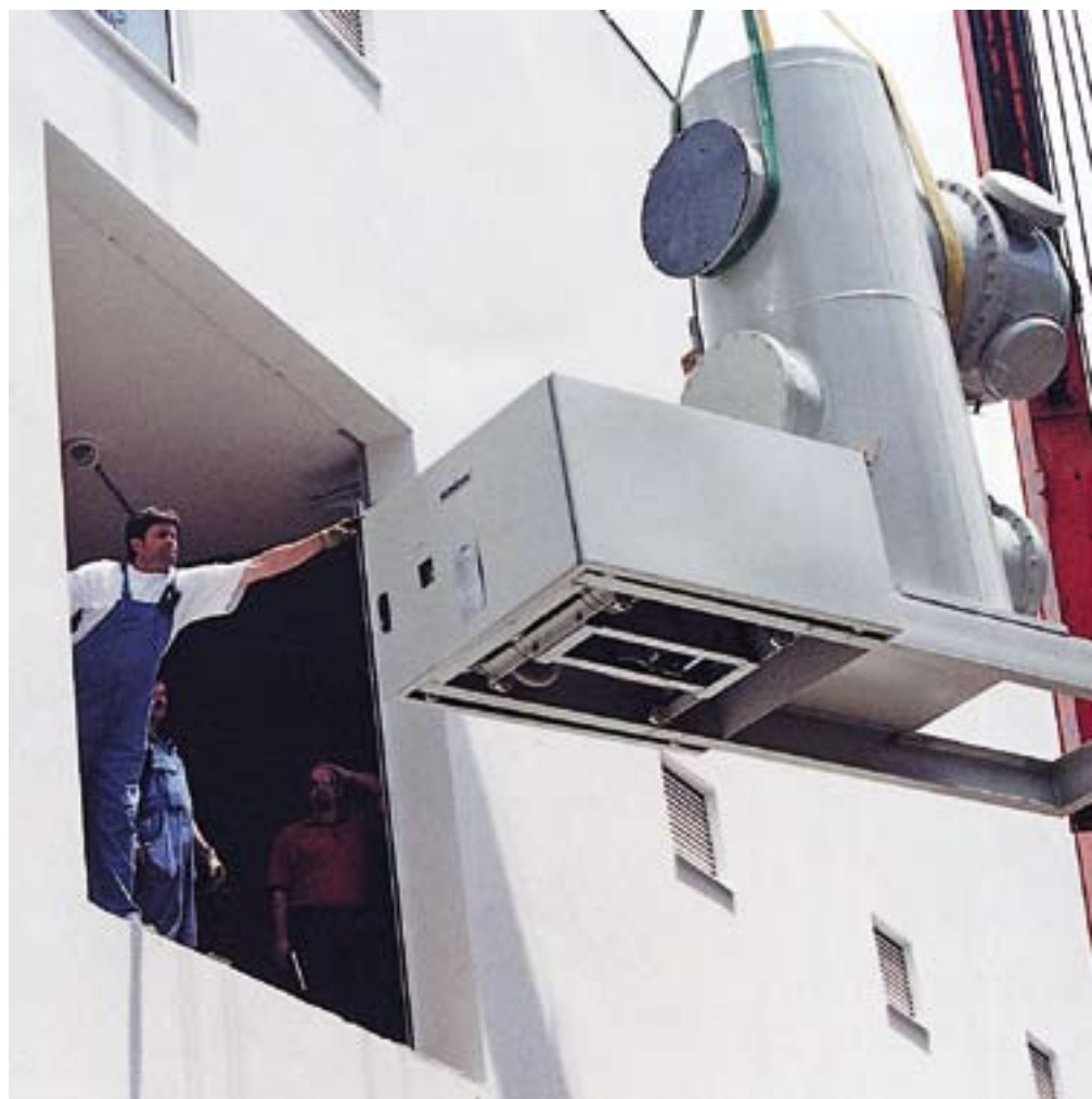
Drugi korak: dio 110 kV postrojenja je u zraku i treba ga provući kroz prozor
