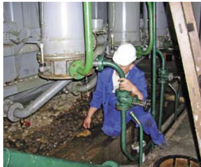
Zamjena dijela cijevi turbinske regulacije
