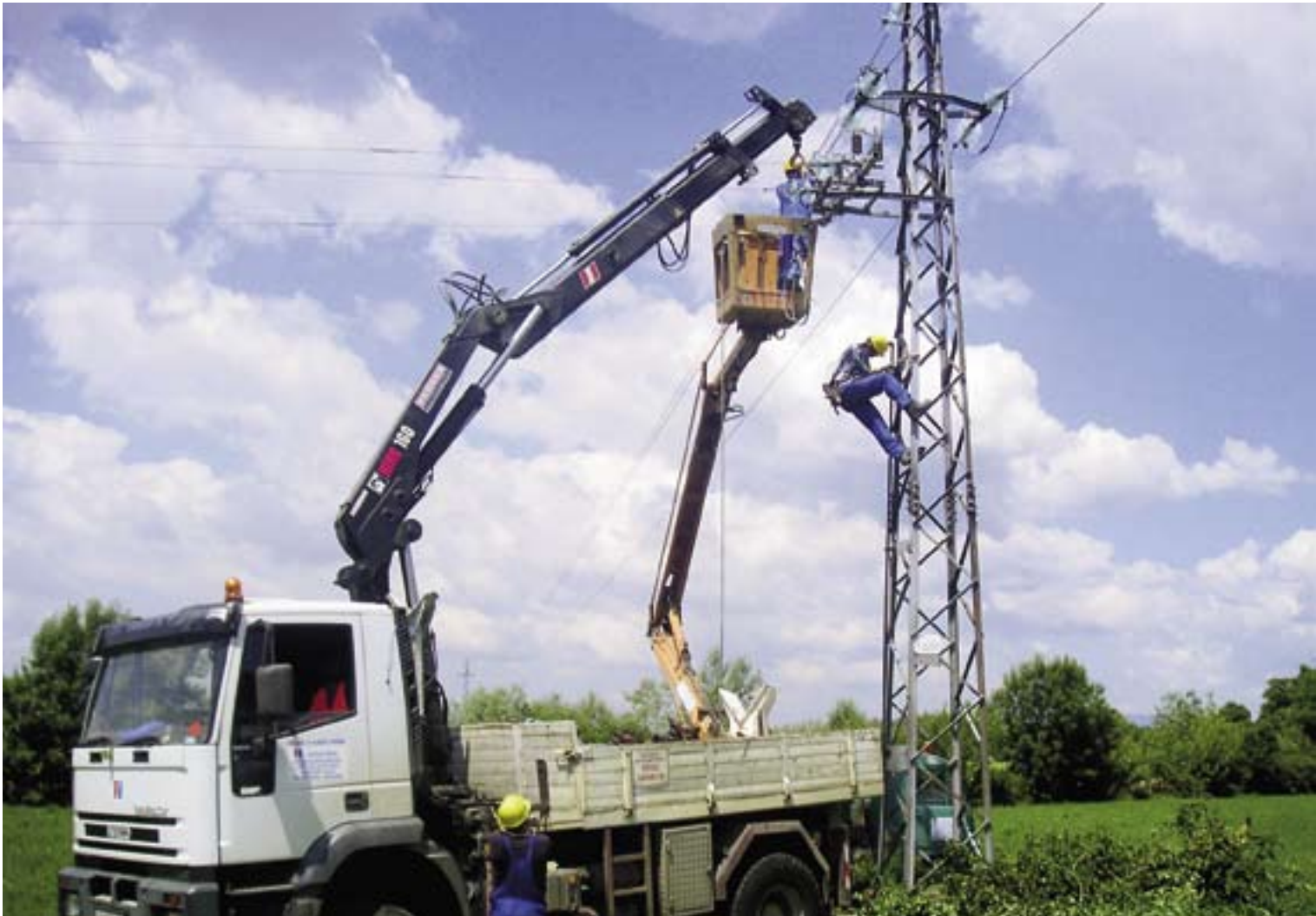
Novogradiški elektraši prigodom zamjene linijskog rastavljača na ZDV 10 kV, odcjep Staro Petrovo Selo
