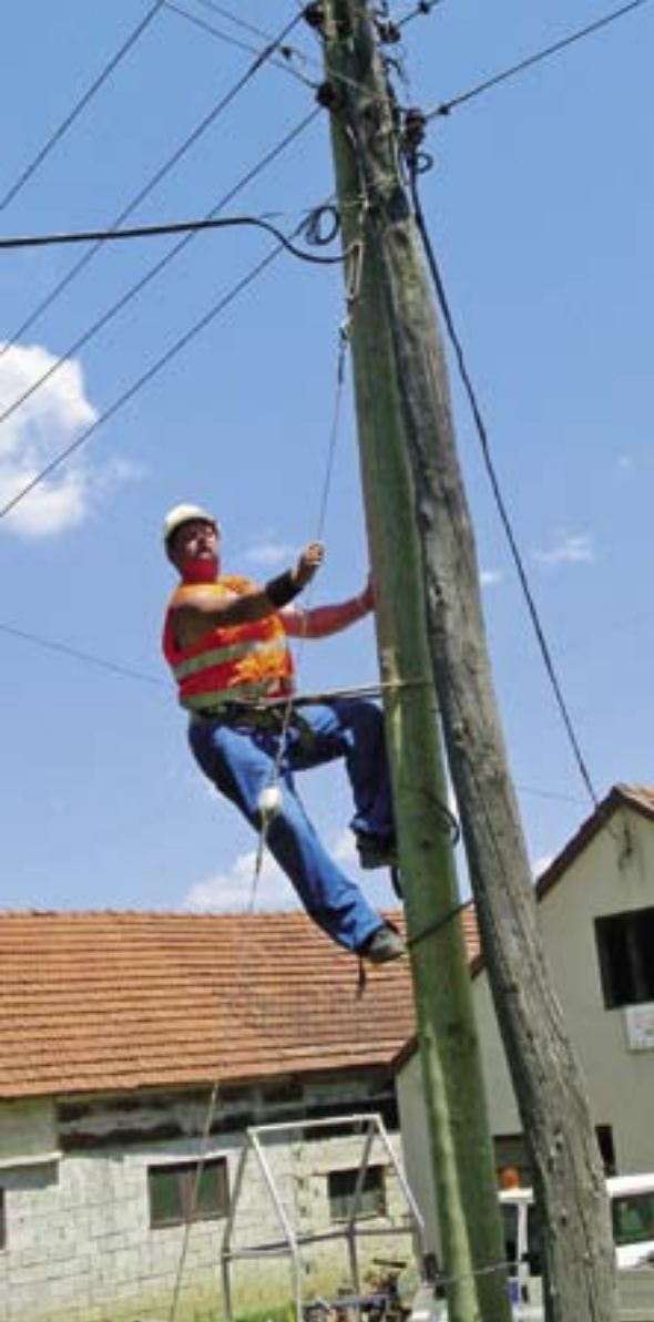
Malo se još elektraša penje na stup ovako kao Marijan Travenščak i njegovi krapinski kolege
