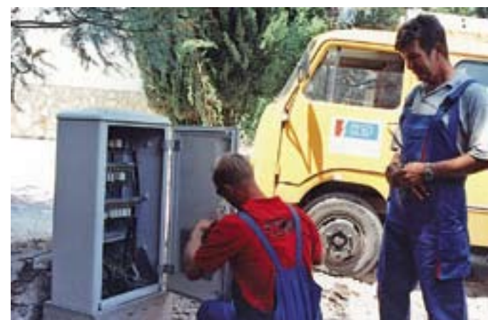
Iznenadni kvar u Rogoznici trebalo je žurno otkloniti
