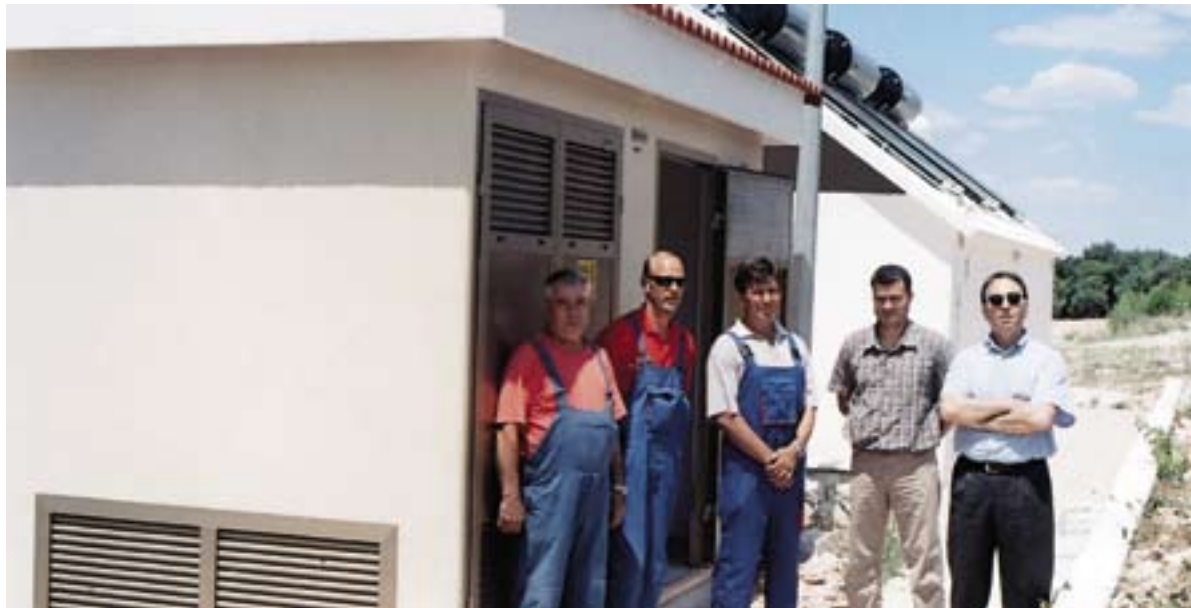
TS 10/0,4 kV Punta Maslina, koju je Grupa Primošten u cijelosti izgradila – elektromonteri Goran Perkov, Ante Markoč i poslovođa Jakov Matošić, a uz njih su koordinator iz Pogona Šibenik Jakov Erceg i rukovoditelj Pogona Veljko Floigl
