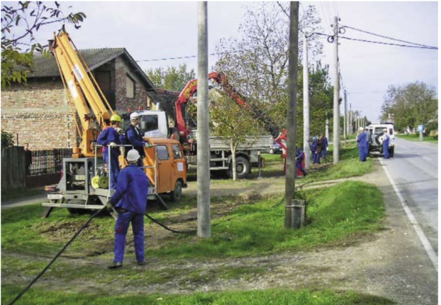
Zaposlenici Odsjeka za održavanje tijekom rada na niskonaponskoj mreži Godinjak
