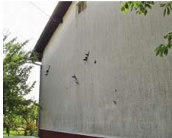
Zamislite da se na putu dijelova pokrova koji se duboko zabio u vanjski zid kuće našao – čovjek?!
