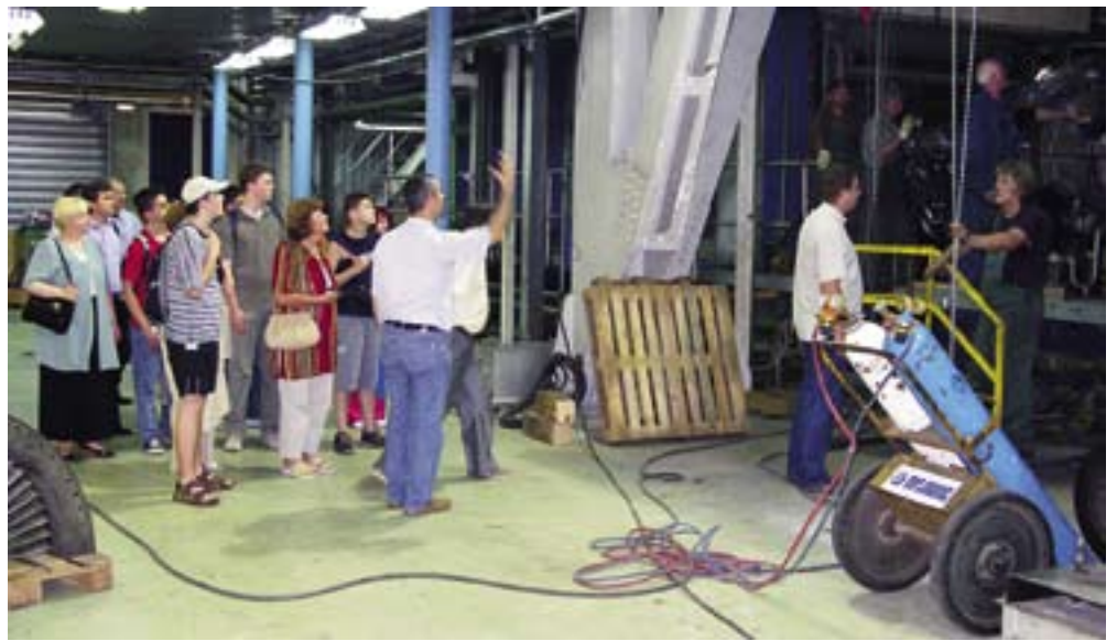
Postrojenje plinske elektrane je u remontu, što je prigoda da se pogleda u njenu utrobu
