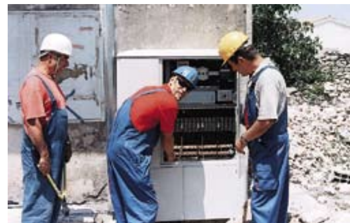
U Zečevu su montirali i nove ormariće
