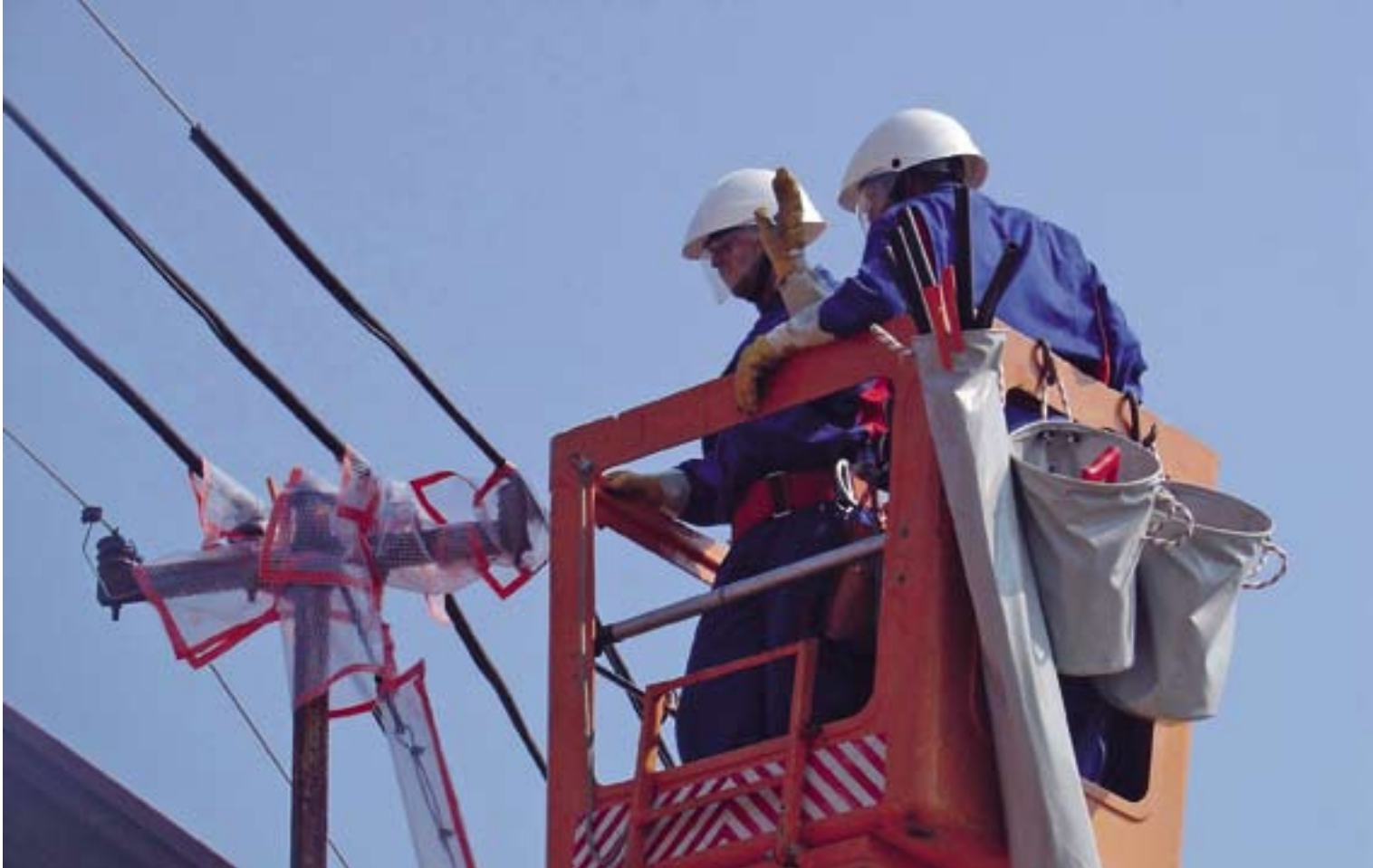
Povijesni trenutak za HEP: u DP Elektra Požega započeo je rad pod naponom
