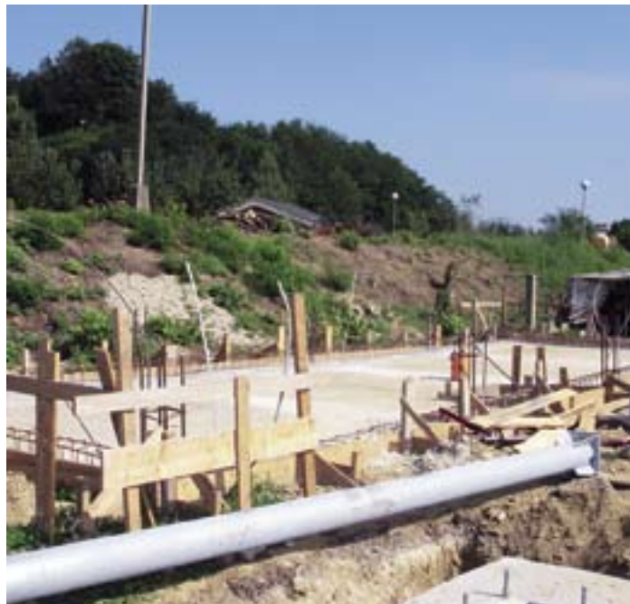
Temelji buduće zgrade sekundarne opreme
