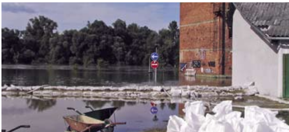
Vreće s pijeskom zapriječile su vodi put od Mure prema TS
