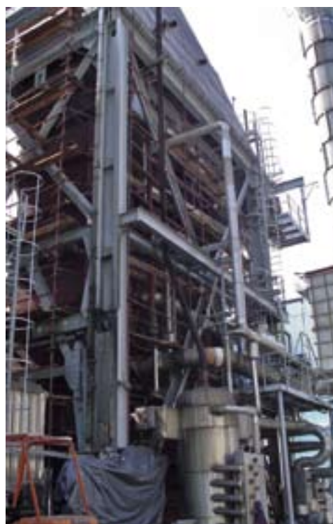
Zamjenit će se i termoizolacija i popraviti oplata kotla KU 1
