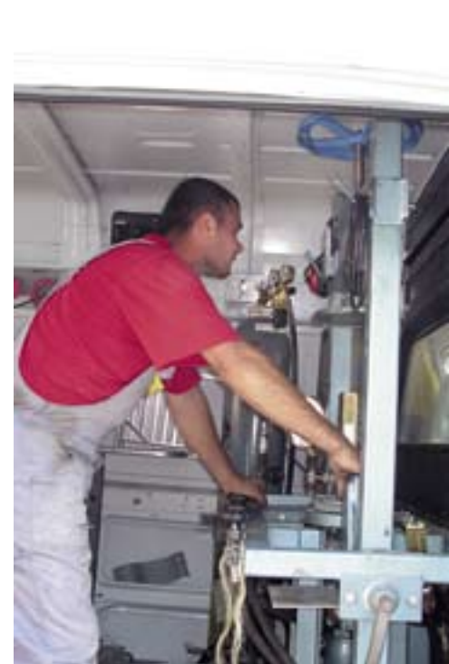
Željko Leljak iz Macel plina Zagreb baždari sigurnosni plinski ventil za regulacijsko-upravljačku stanicu plinske turbine
