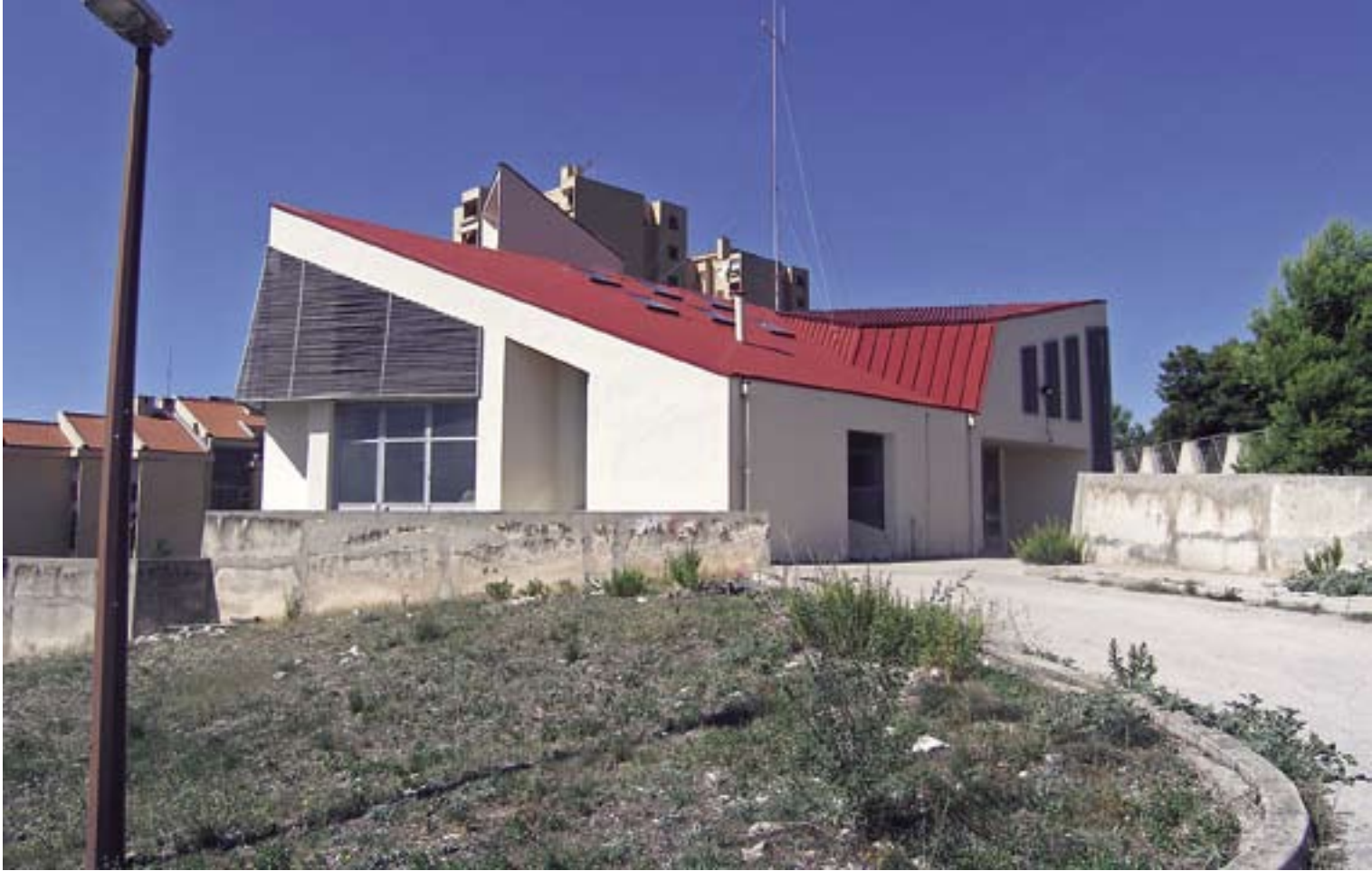
Posebna kao i stanovnici ovog grada - dvadesetak godina stara TS 35/10 kV "Šibenik 3"
