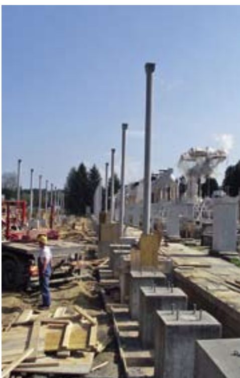
Zamjena konstrukcija nosača sabirnica i izlaznih DV portala
