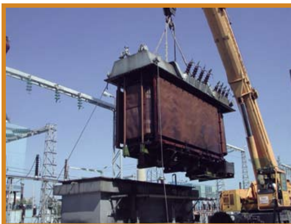
Kvar je bio unutar VN namota i transformator je bio na putu
