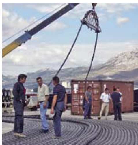
Radovi pod budnim okom voditelja poslova
