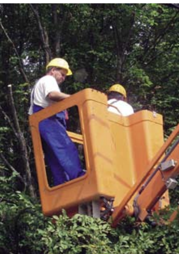
Milan Capan, KV monter i Tomo Kuterovac, PKV, pri sječi raslinja koje smeta mreži
