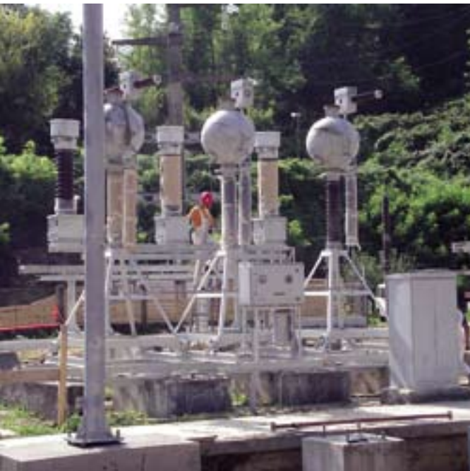
Radovi na antikorozijskoj zaštiti
