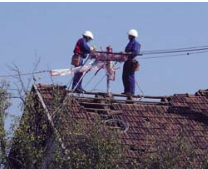
Gradec pokraj Pleternice: monter na mreži s izoliranim vodičima...
