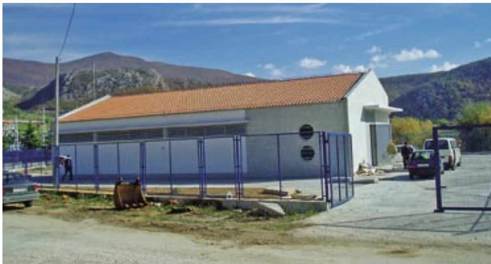
TS 35/10(20) kV Ruda - još uvijek bez transformatora
