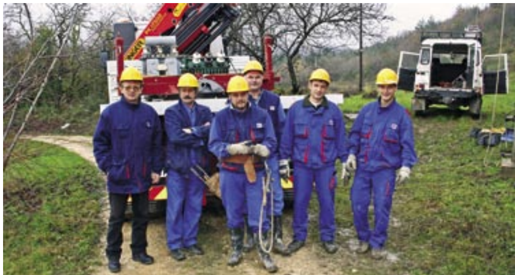
Ekipa koju predvodi poslovođa Mauricio Tominić, a u kojoj su bili i Čedomil Šuran, Milano Mijandrušić, Vilim Valenta, Džoni Ferlin i Livio Jugovac, u naselju Petrovići zamjenjuje trafostanicu radi prelaska na 20 kV napon
