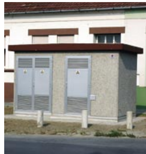
... i postavljanje nove trafostanice sa zaštitnim betonskim stupićima
