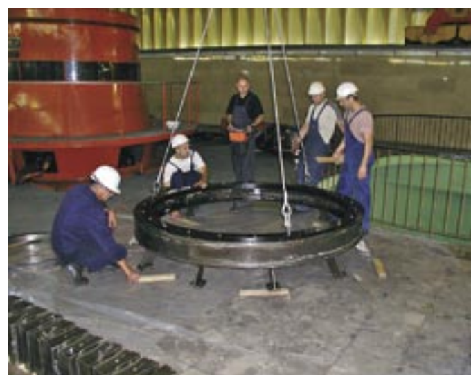
Remontni radovi na agregatu
