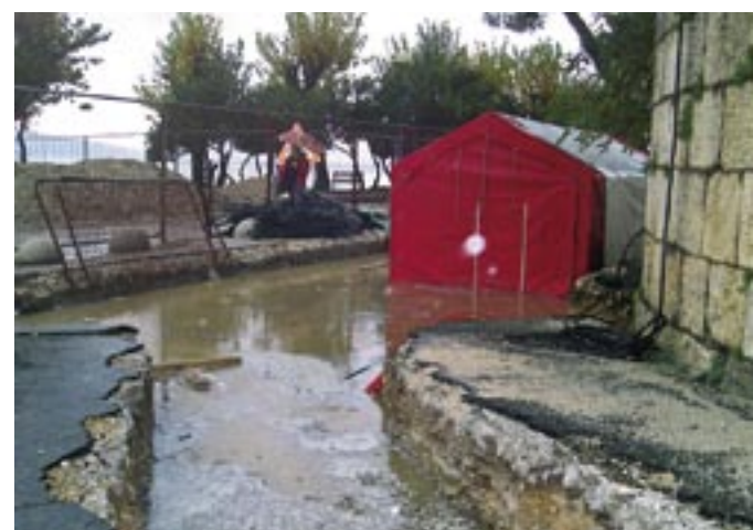
Šator kao zaštita mjesta gdje su se izradivale spojnice
