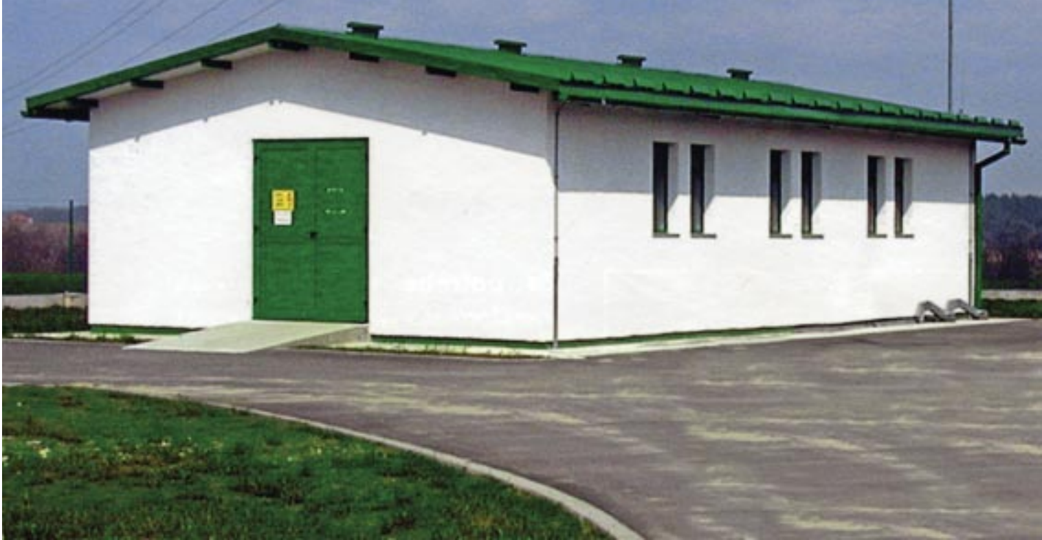
TS 35/10 (20) kV Predavac izgrađena je za samo 5,8 milijuna kuna
