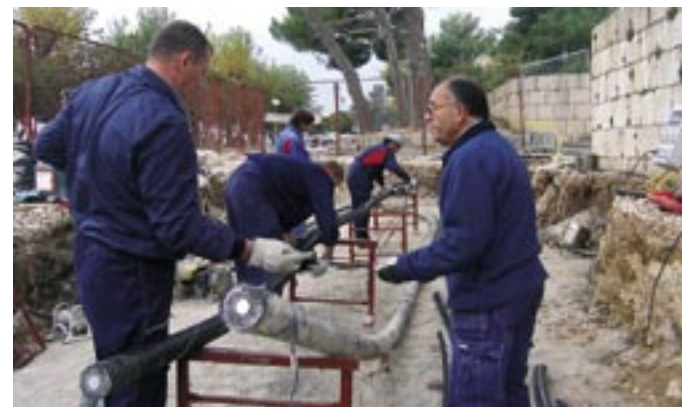
Obrada armature podmorskog kabela (prije kiše)
