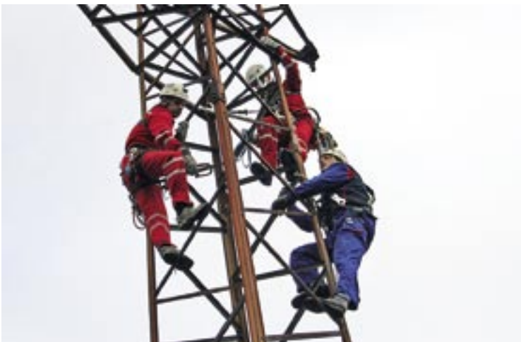
Spasitelji su stigli iznad unesrećenog , osiguravaju sebe i ozlijeđenog te pripremaju koloturu, konopce i ostalu opremu nužnu za sigurno prizemljenje ozlijeđenoga
