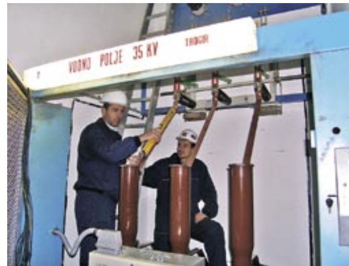
Joko Ercegovac i Vlado Milardović pri montaži spojeva 35 kV polja
