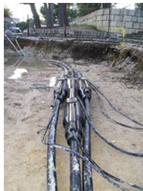
Zahtjevan posao spajanja podmorskog kabela s kopnenim je završen i kabeli i njihove spojnice spremni su za zemlju
