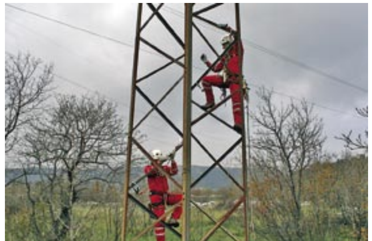
Član Gorske službe spašavanja pokazuje penjanje na siguran način - u svakom trenutku, na svim visinama, kada je jedan od dva sigurnosna konopca pričvršćen za stup
