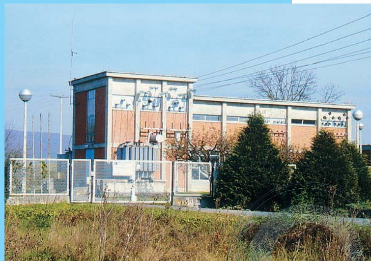
Nakon 30 godina rada, TS 35/10 kV Ferovac je potpuno rekonstruirana
