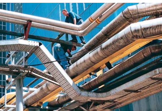
U tijeku je prespajanje mazutnog cjevovoda za kotao Bloka L
