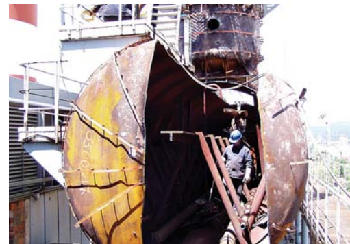
...spremnik napojne vode kotla
