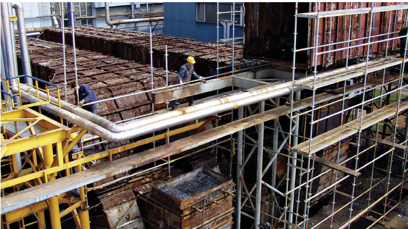
Ruše se i uklanjaju dimovodni kanali...
