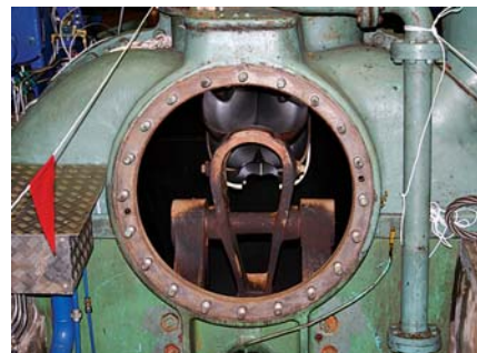
Jedan od većih poslova tijekom remonta jest i revizija predturbinskih zatvarača
