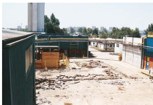
Najprije je trebalo izmjestiti infrastrukturu, koja služi za pogon ostalom dijelu postrojenja TE-TO
