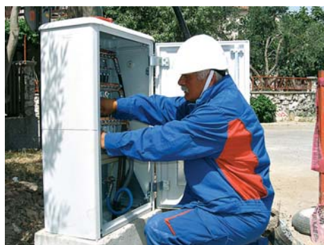
Mate Labor pri montaži ormarića
