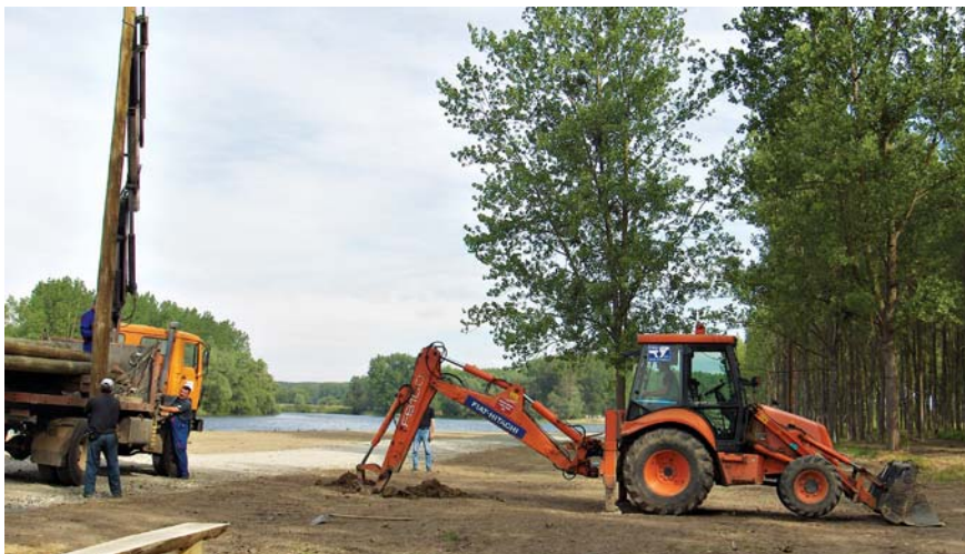
Postavljanje stupova u Bilju
