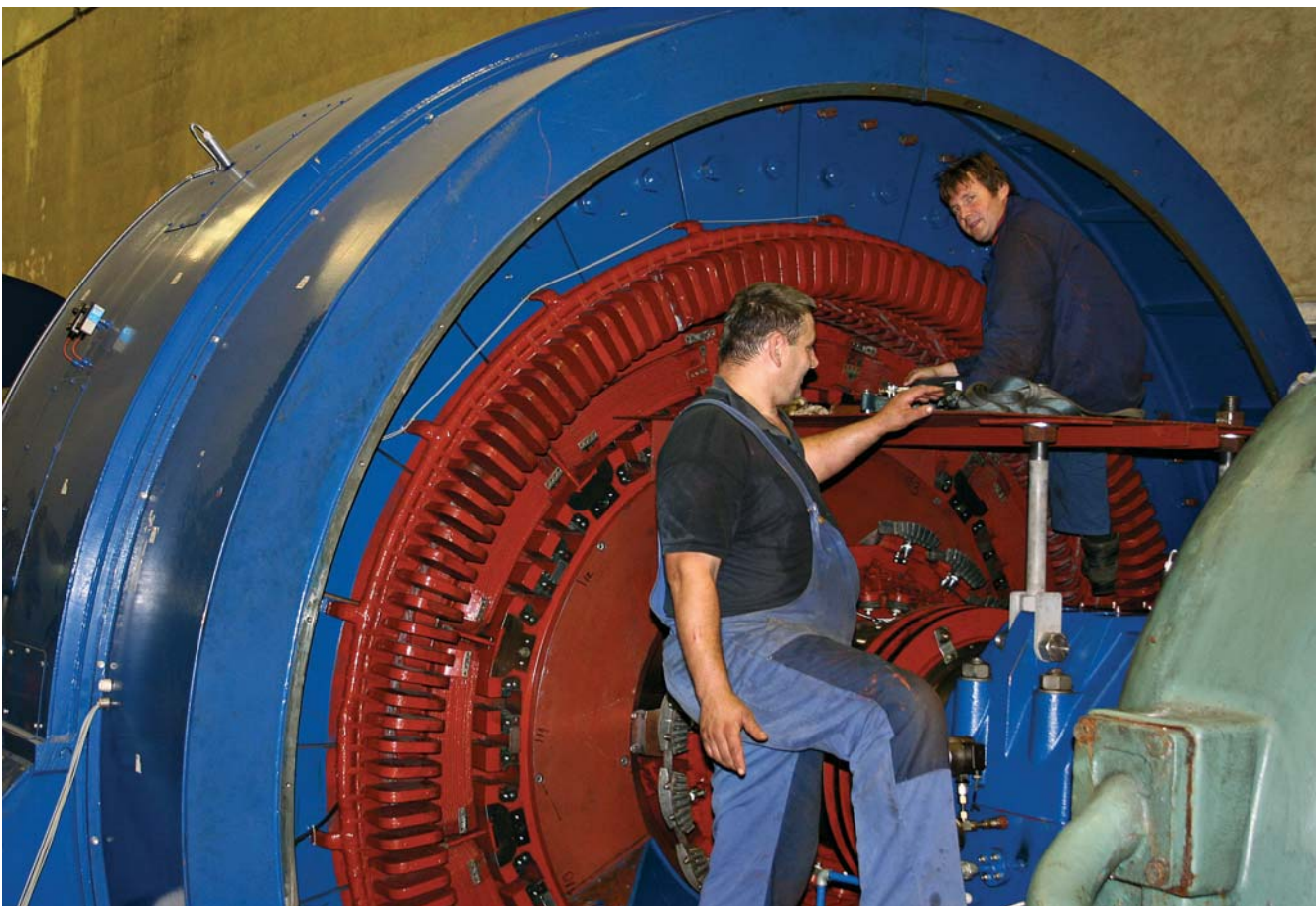
Jedan od otvorenih generatora na kojima se izvodi rekonstrukcija magnetnog kruga
