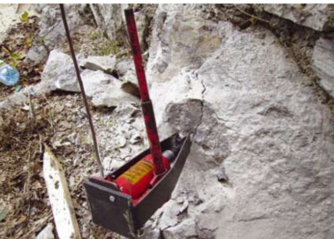
Sprava za razbijanje kamena još nije patentirana ali je, kao što se vidi, vrlo učinkovita
