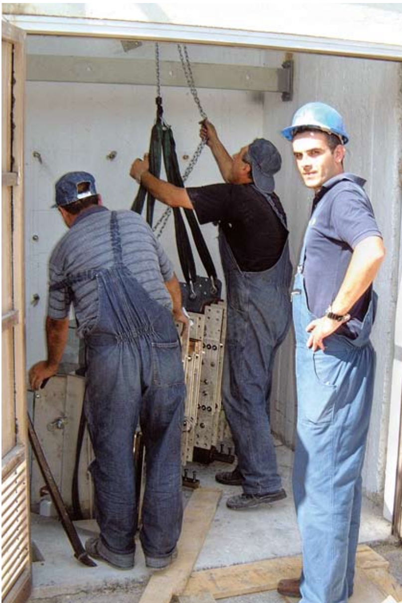
Novi rastavljač kočenja smješten je u prostoriji gdje je bio i stari
