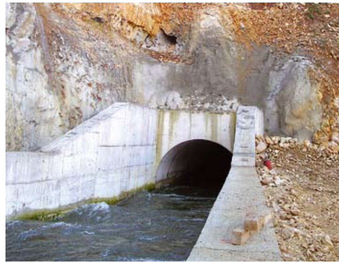
Obilazni tunel, kroz koji je privremeno skrenut tok Dobre
