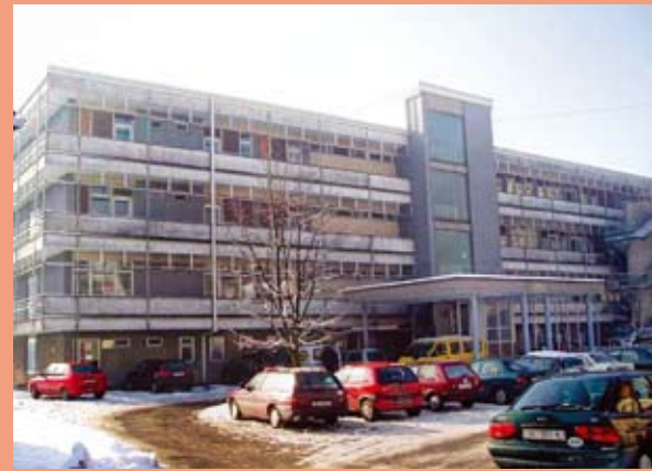
Modernizacija sustava grijanja Opće bolnice "Ivo Pedišić" iz Siska obuhvaća priključivanje na centralni toplinski sustav grada Siska i potrebnu rekonstrukciju toplinskog sustava Bolnice, uključujući izgradnju rezervnog sustava
