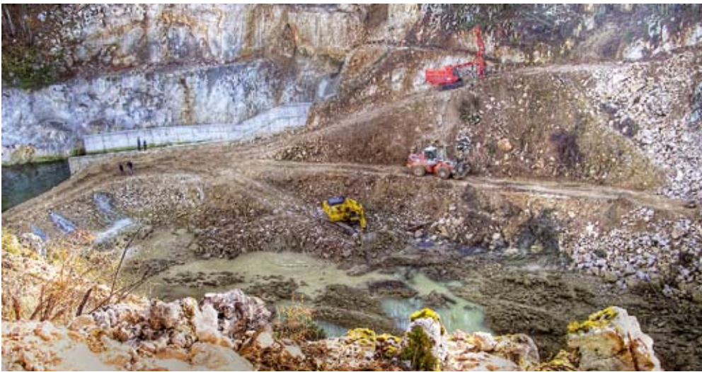
Kanjon Dobre - gradilište
