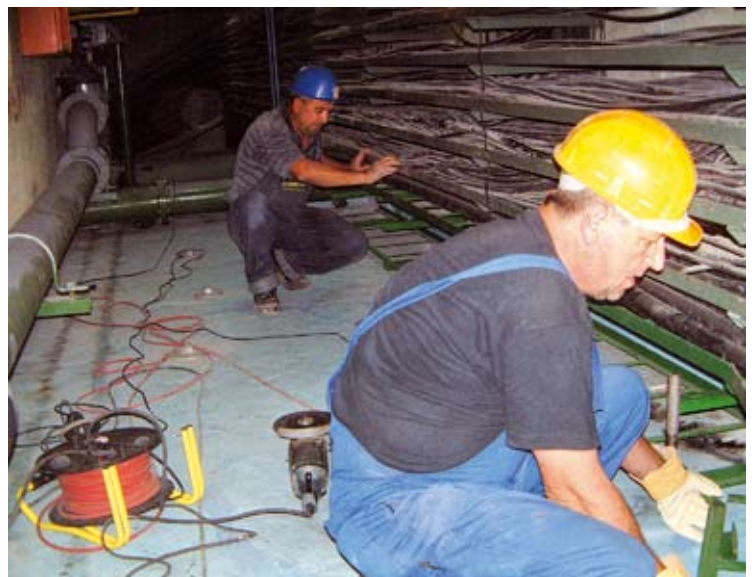
Nove uzbude traže nove kabele i – nove police
