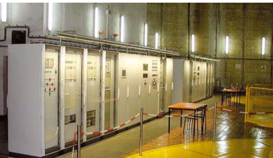
Nova oprema turbinskih regulatora, sustava upravljanja i električkih zaštita agregata 1 i 2 u RHE Velebit
