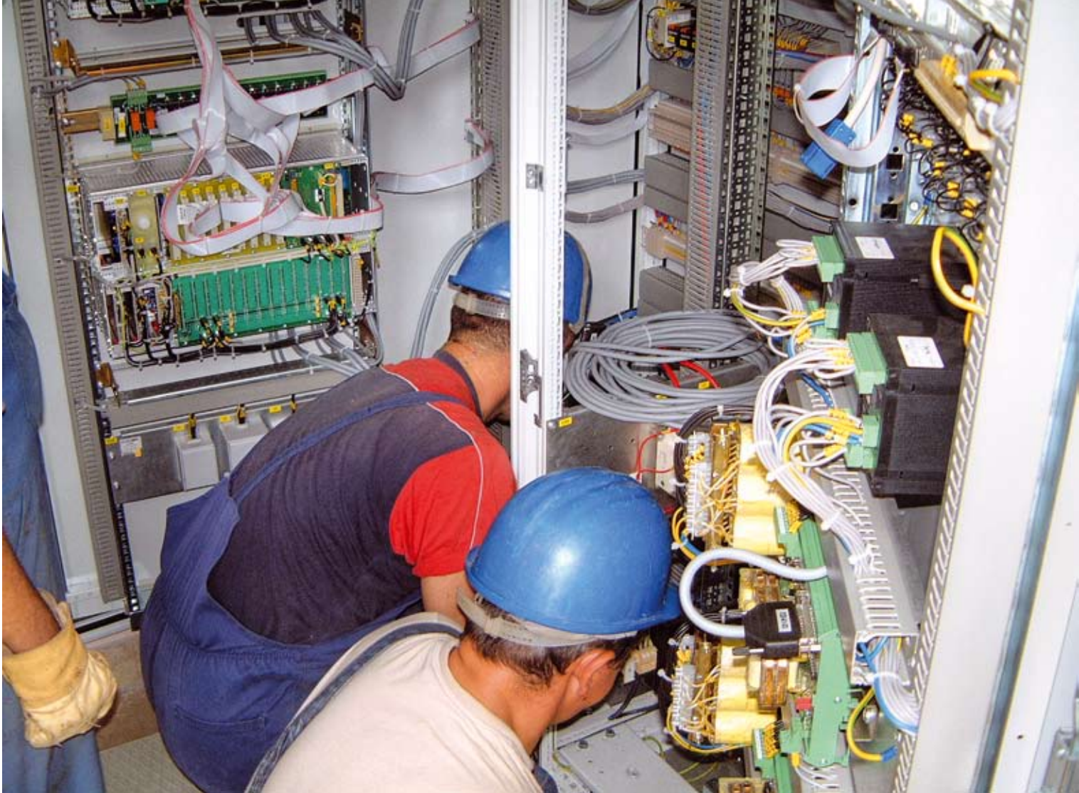
Ožičavanje nove opreme
