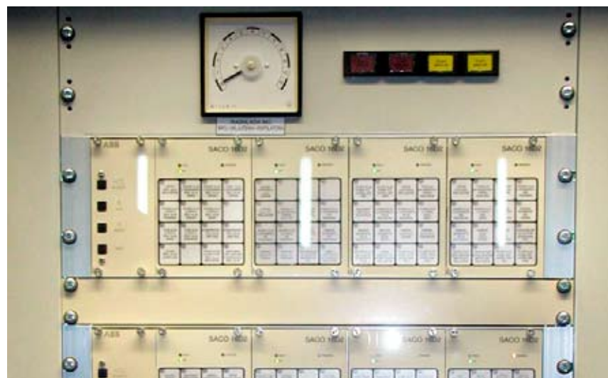
Nova oprema turbinskih regulatora, sustava upravljanja i električkih zaštita agregata 1 i 2 u RHE Velebit
