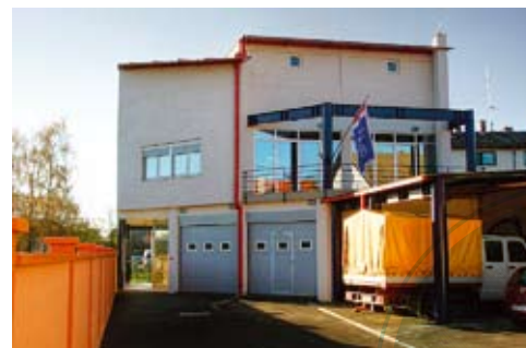
Nakon kontejnera kao poslovnog prostora u kojem su zaposlenici radili 15 godina, 2005. godine izgrađena je pogonsko-poslovna zgrada Pogona HEP Plina u Donjem Miholjcu
