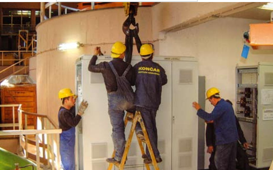
Montaža novih ormara uzbude
