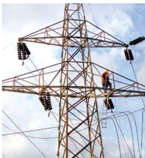
Započinju radovi na čelično-rešetkastom stupu...
