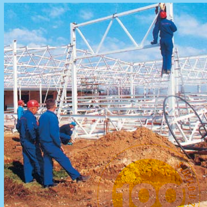
Postavljeni su sidreni stupovi sa krovnom konstrukcijom
