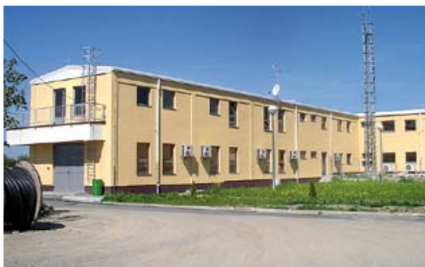
Pogonsko poslovna zgrada TS Siscia
