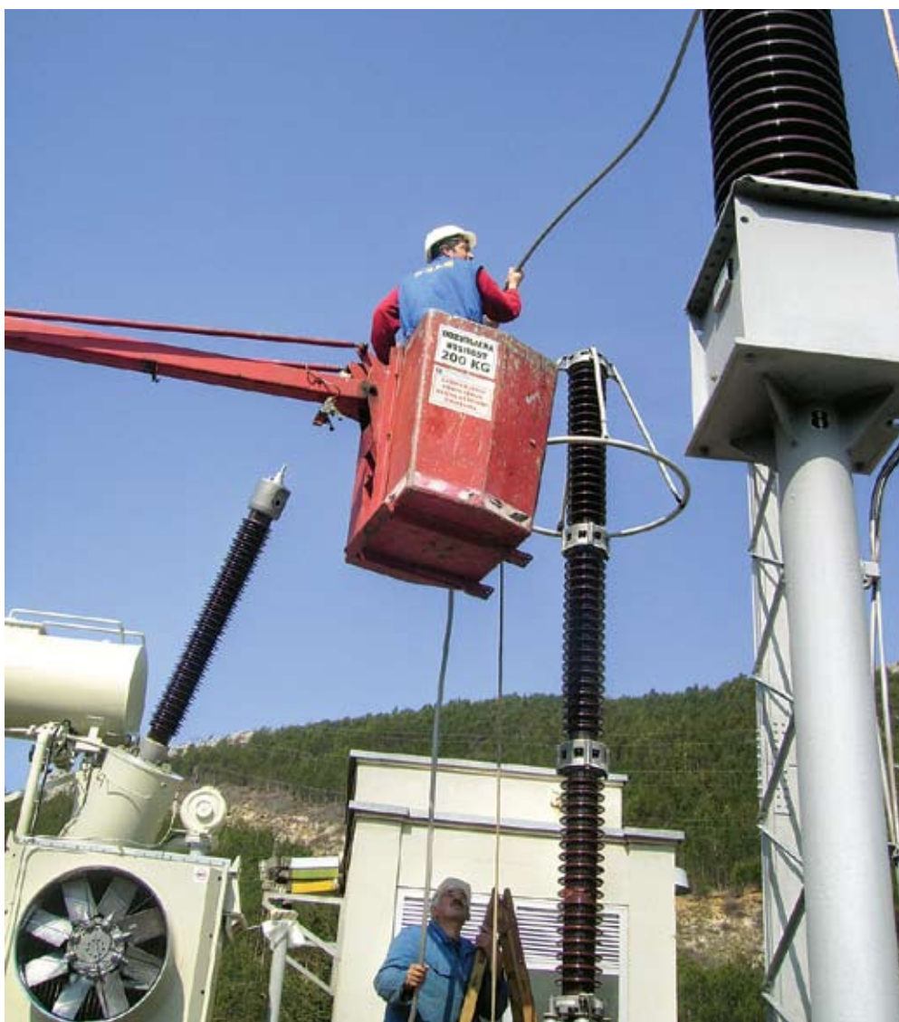
Montira se spojna oprema
