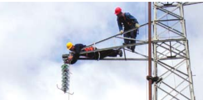
Pod budnim okom brigadira, mladi monter postavlja izolatorski lanac
