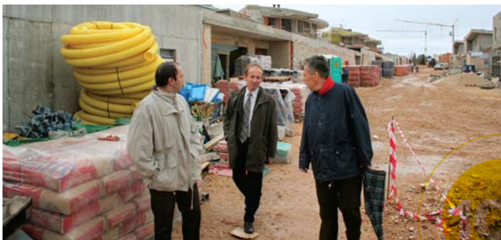
Stručna ekipa Elektroistre u obilasku gradilišta na Crvenom vrhu
