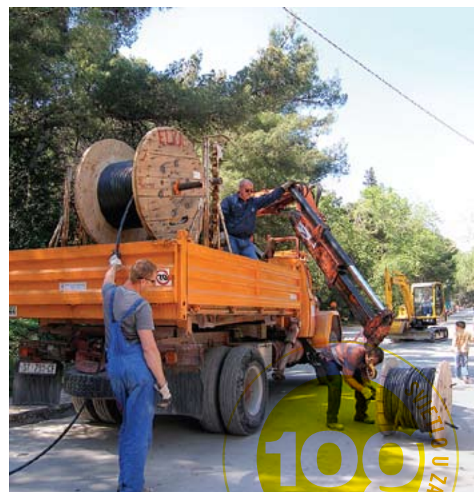
Utovar kabela za sljedeću dionicu
