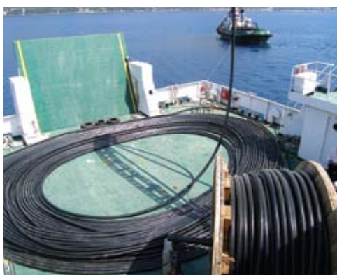
Kabel strpljivo čeka da se spusti na morsko dno
