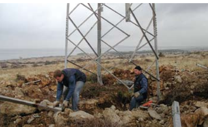
Pripreme za zamjenu dijela pojasnika na ulazu u temeljnu stopu
