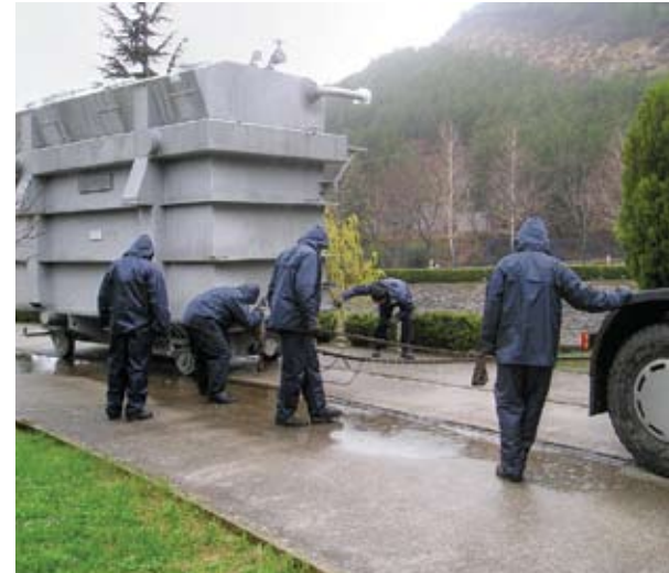
Postrojenje koje je godinama služilo Elektrani odlazi iz njenog kruga, uz ispraćaj kišnih kapi
