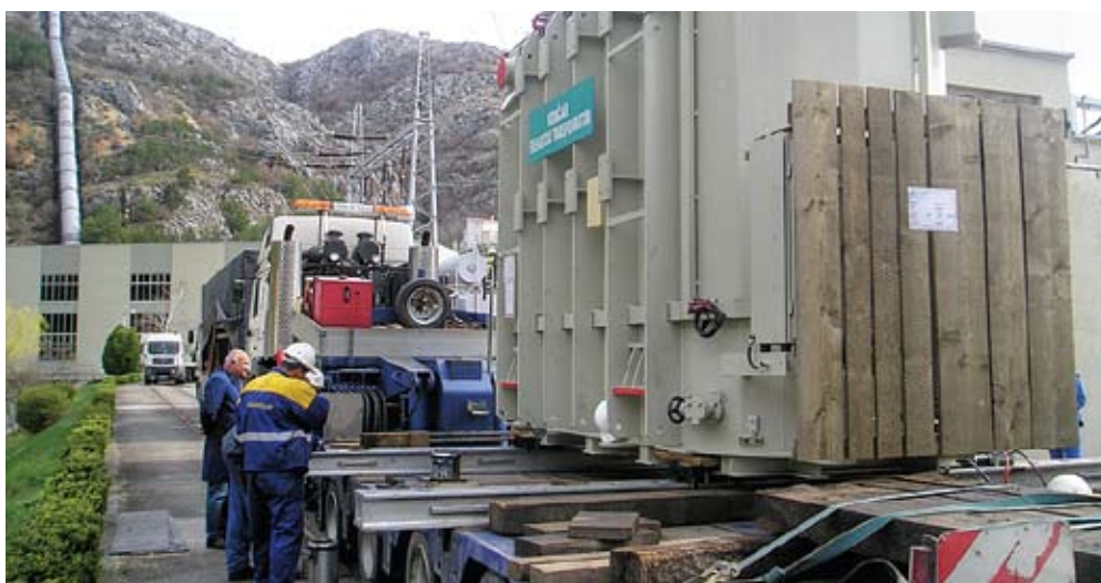
Priprema se istovar novog transformatora
