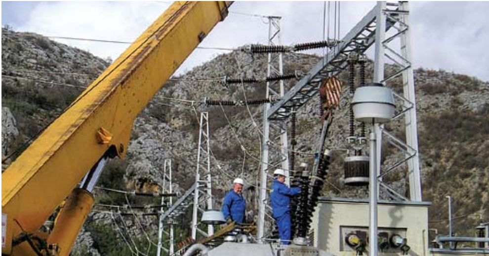
U tijeku je demontaža blok-transformatora A
