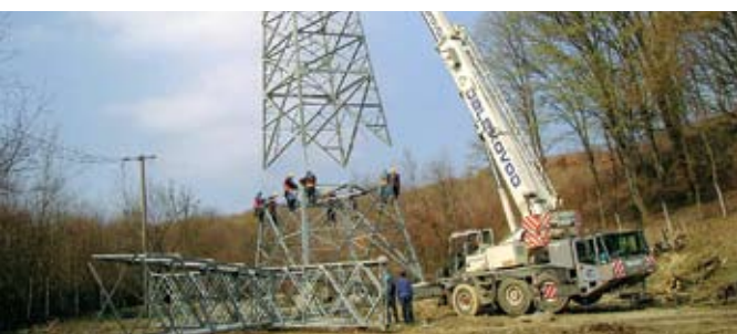
Podizanje srednje sekcije stupa – na svakom uglu su po jedan iskusni i po jedan mladi monter
