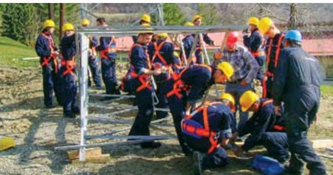
Sastavljanje sekcije stupa na zemlji, prema radioničkim nacrtima
