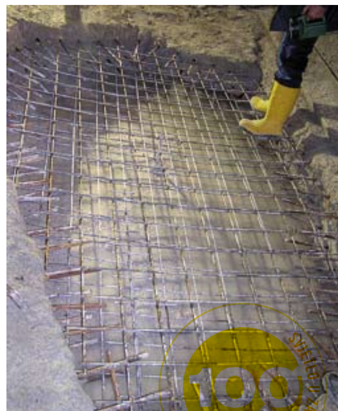
Sanacija urušenja u dnu desnog dovodnog tunela
