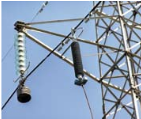
Tijekom šest dana montirano je 110 LOP-ova na DV 110 kV Ston – Komolac
