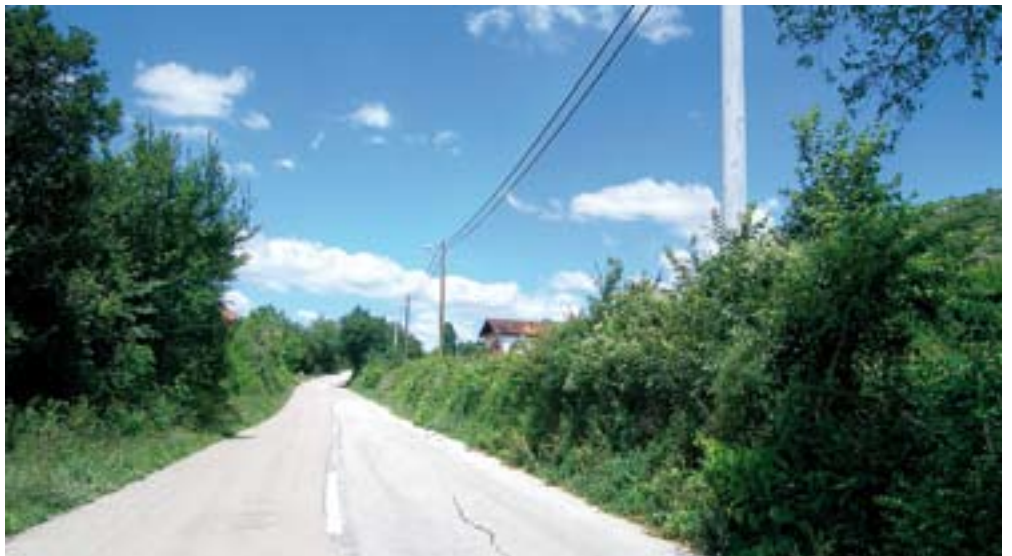
Novoizgrađena mreža u Orliću
