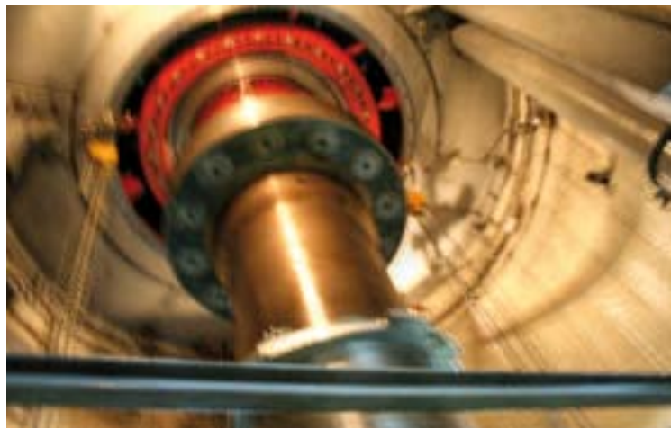
Spoj osovine generatora u remontu i turbine u HE Senj
