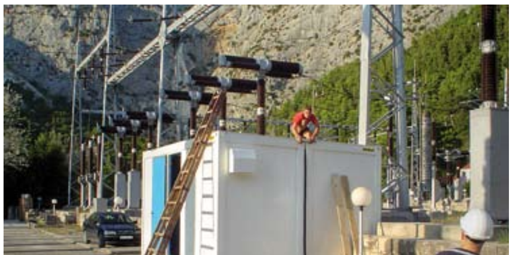
... postavljena je i zadnja kućica za smještaj opreme novog decentraliziranog sustava USZMR-a i PROCIS-a za upravljanje 220kV i 110 kV rasklopnim postrojenjima
