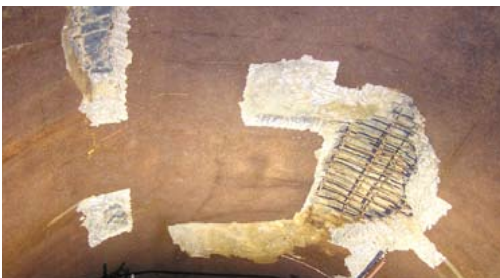
Sanacija betonske obloge u lijevom dovodnom tunelu
