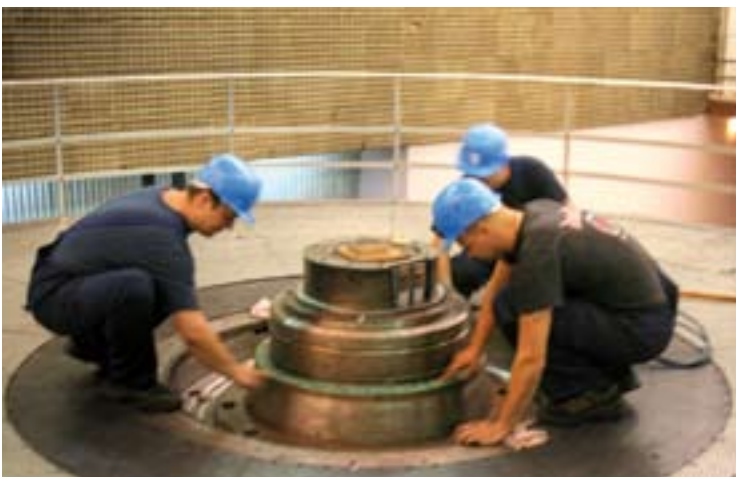
Pripreme za montažu kliznih prstenova na generatoru
