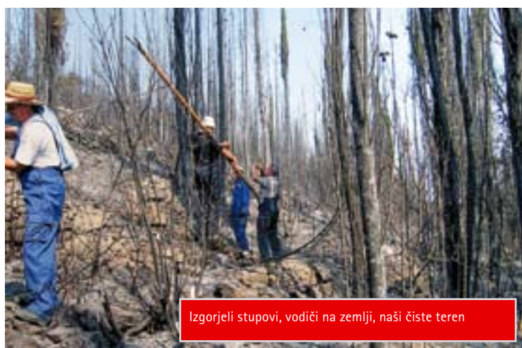
Novi stup priprema se za podizanje u zrak
