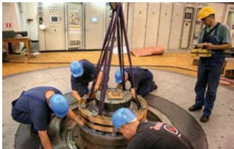
Spuštanje kliznog prstena i montaža
