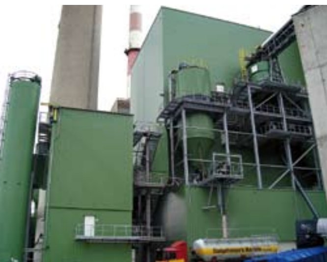
Elektrana na drvenu biomasu Simmering najveća je takva elektrana u Europi, instalirane električne snage 24,5 MW i toplinske 37 MW - toplina se koristi za grijanje okolnih područja
