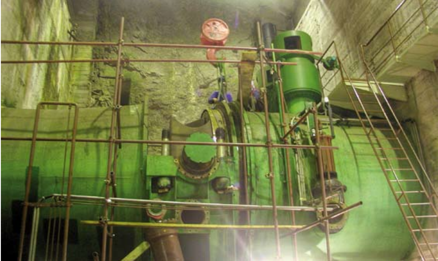
Remont leptirastog zatvarača na agregatu
