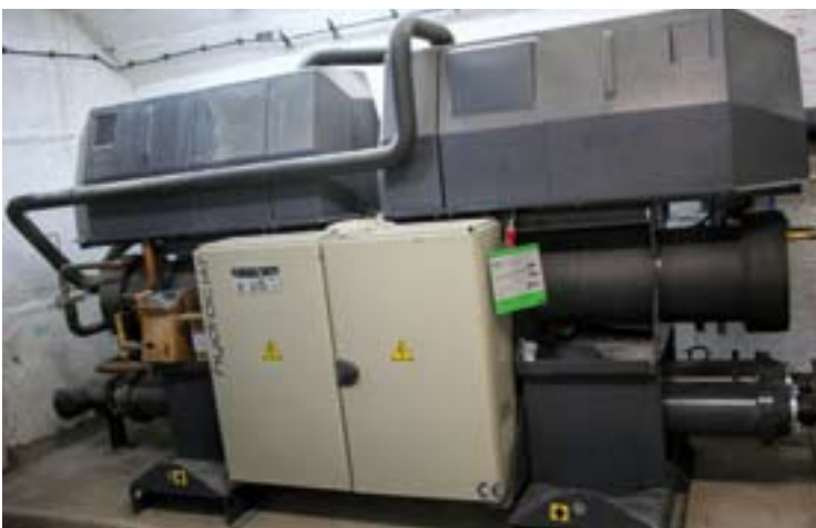
Zamjena klimatizacije strojarnice i...
