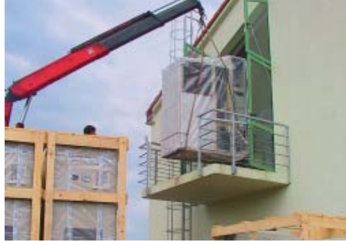
Postrojenje je stiglo i uz pomoć dizalice ulazi u zgradu
