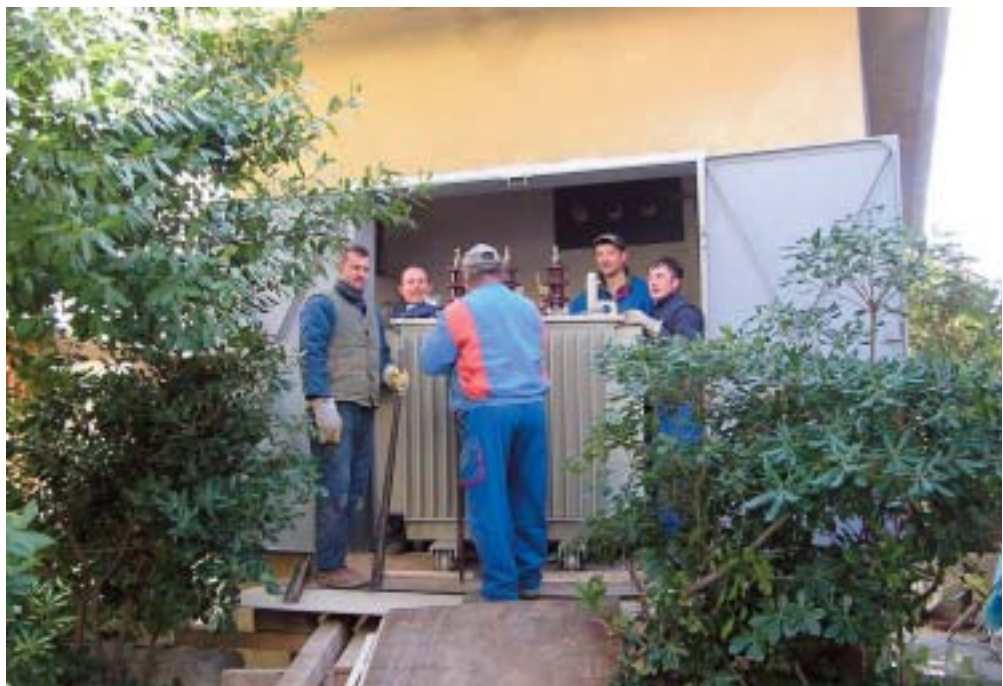
Zamjena starog 10 kV transformatora novim 20 kV, 630 kVA u TS Krk 1 – Mihailo Dujmović, Mladen Fugošić, Božidar Polonio, Nadan Kosić i Ermin Burnić
