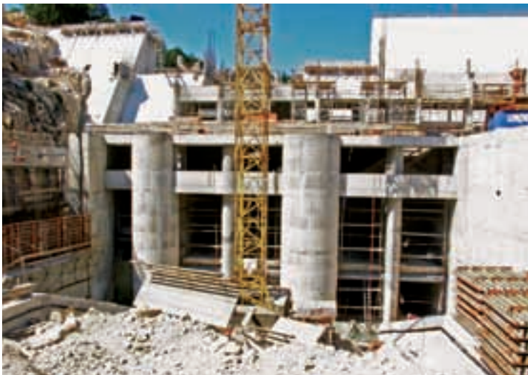
Tri difuzora za tri agregata – dva glavna i agregat biološkog minimuma
