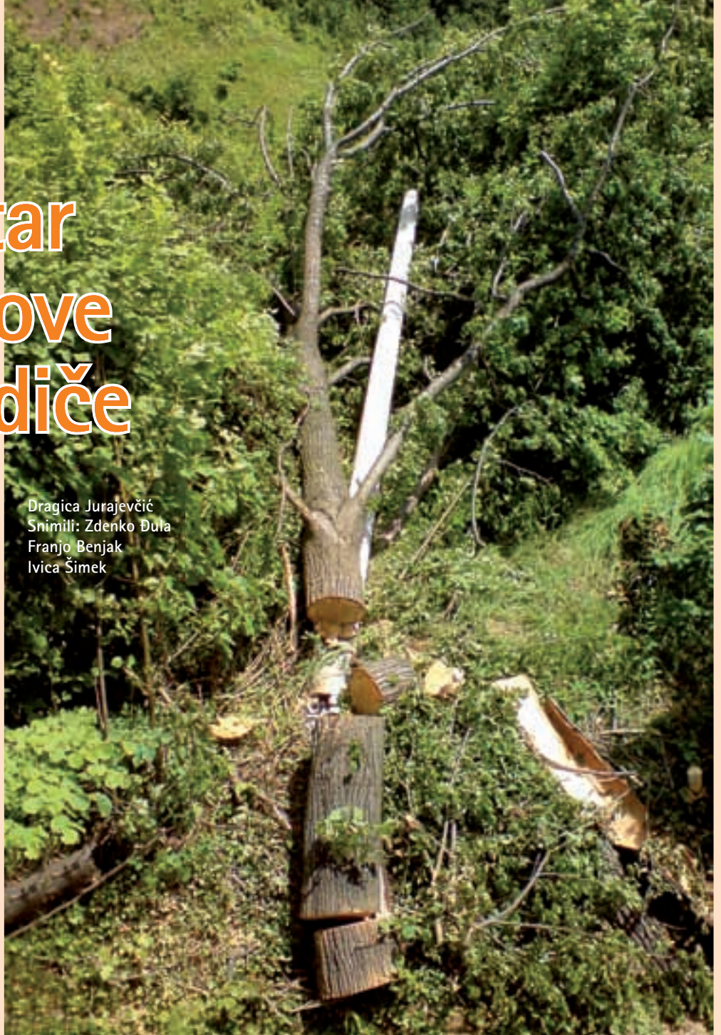
Betonski stup u Gornjoj Voći nije mogao preživjeti pod teretom teškoga stabla
