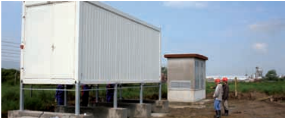
Rasklopište i kabela TS 10(20)/0,4 kV postavljene su na svoje mjesto
