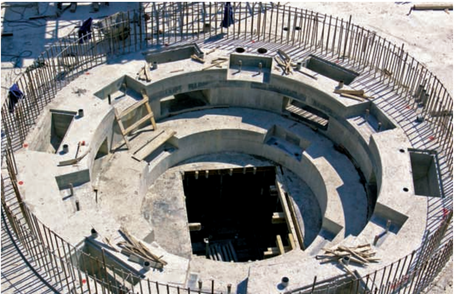
Dovršavaju se pripreme za montažu agregata B
