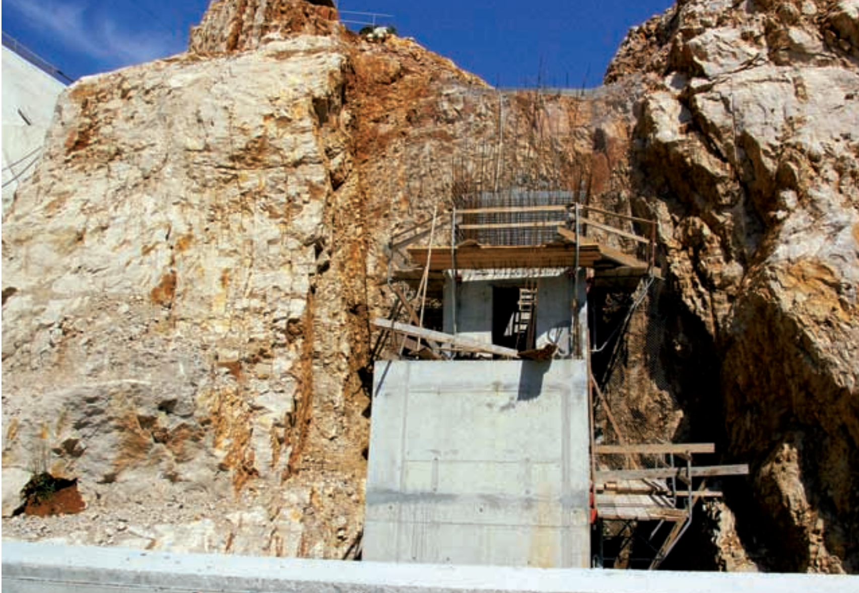
Energetski tunel koji spaja strojarnicu i rasklopno postrojenje – izvana
