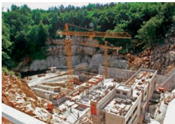
Elektrana se svakim našim posjetom sve više diže i poprima svoj konačni izgled
