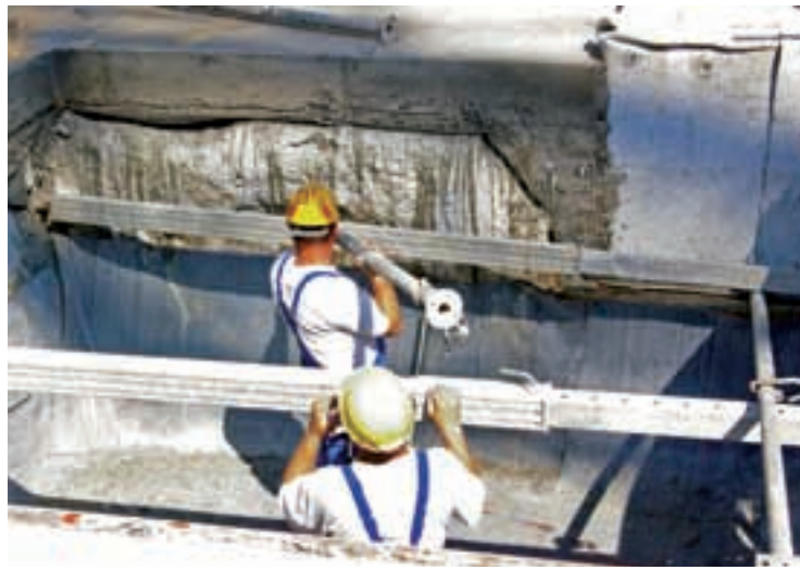
Izrada temelja za stupove kranске staze na generatorskoj ploči
