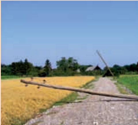
Žice su spasile drvene stupove u Radovec Polju od potpunog prizemljenja
