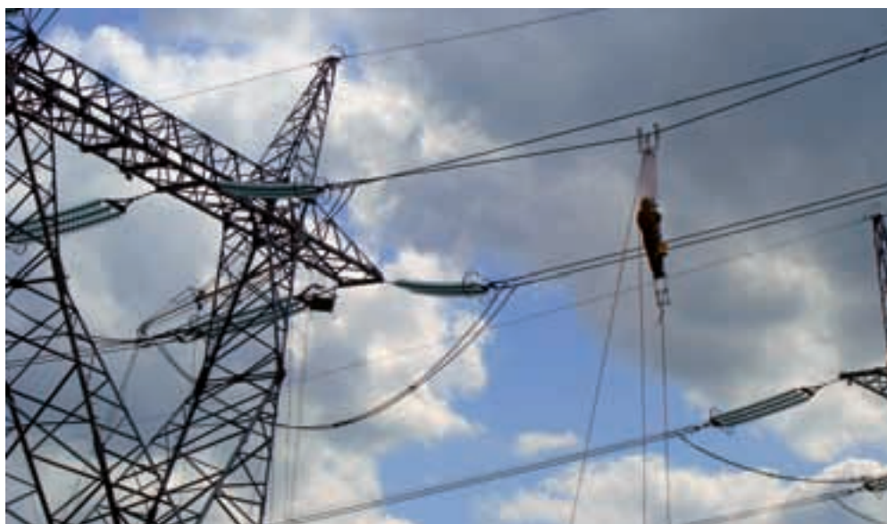
...postavljanje sustava za nadzor temperature vodiča – SC Smart, Rumunjska...
