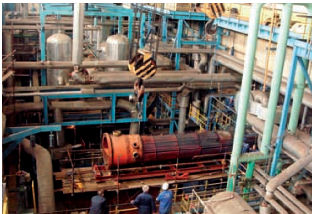
Zamjena cijevnog snopa zagrijača NTZ1
