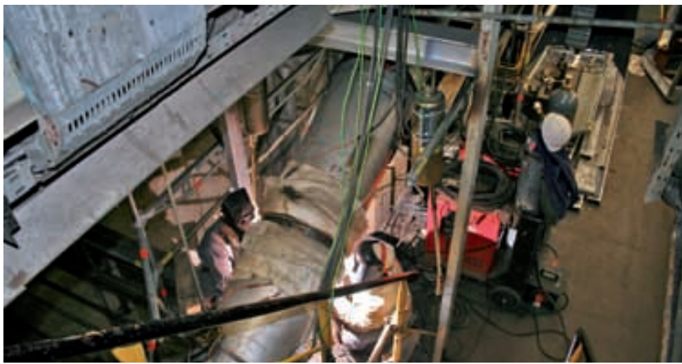
Radovi na novom parovodu vruće međupregrijane pare, čija je montaža izvedena s prednapinjanjem cjevovoda, a zamijenjena je i kompletna toplinska izolacija na pozicijama na kojima su se provodile aktivnosti
