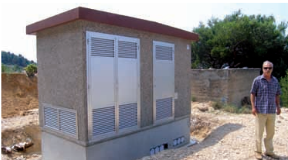
Rukovoditelj Pogona Miro Radić uz novoizgrađenu TS Bilaje, koja će pod napon sredinom srpnja
