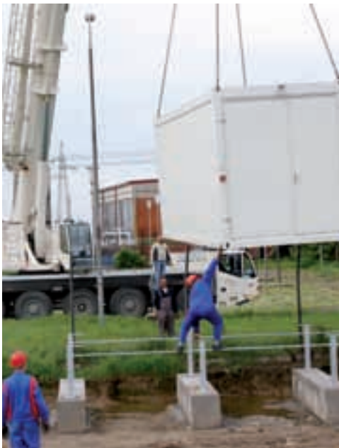
Radovi na postavljanju mobilnog rasklopišta 20 kV
