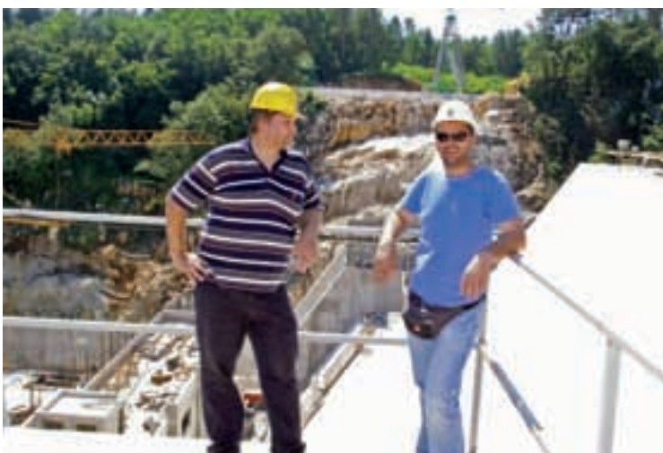
Damir Balažić, nadzorni inženjer za branu i Marinko Bravić, inženjer gradilišta – na izvidnici s koje puca pogled na čitavo gradilište
