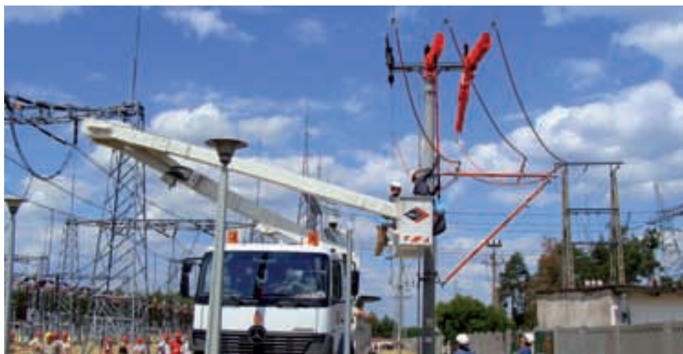
...održavanje SN linijskog rastavljača pod naponom – ENION, Poljska...
