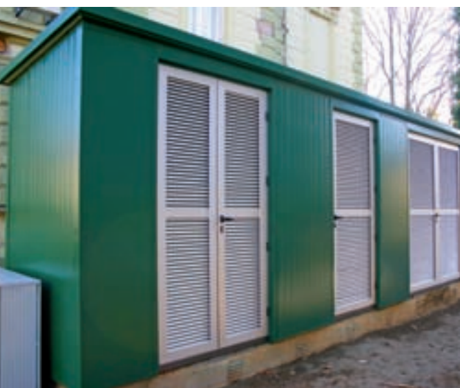
Trafostanica BKTS 3 Osijek u studenom o.g. nakon završenih svih radova revitalizacije
