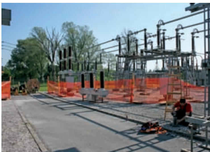
TS 110/20(10)/35 kV Dubovec tijekom radova
