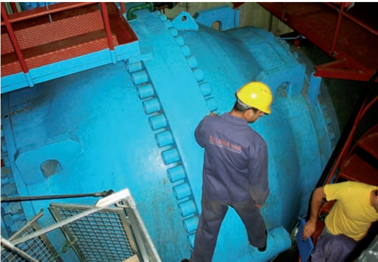
Revizijski radovi na agregatu 3
