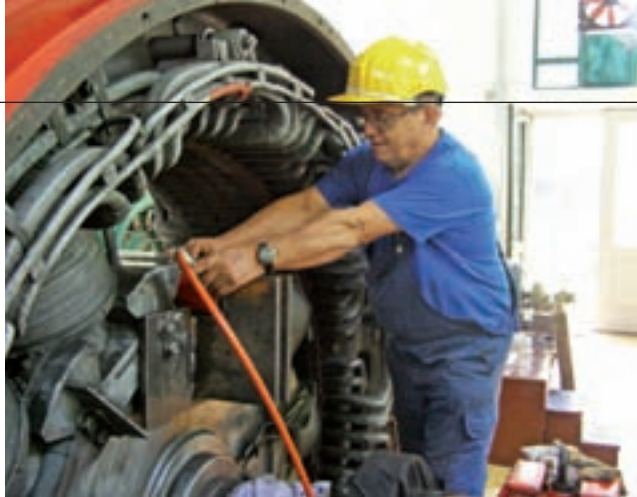
U 88 godina radnog vijeka HE Zeleni Vir, prvi put se demontiraju polovi generatora A1, što uz pomoć hidrauličke pripreme obavlja poslovođa Josip Lisac
