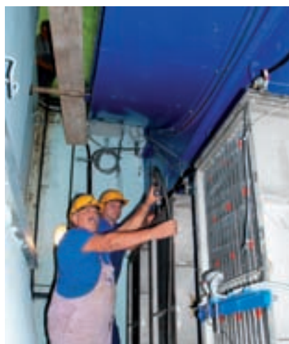
Nikola Pešun i Tomislav Gobac pri pregledu i čišćenju hladnjaka generatora
