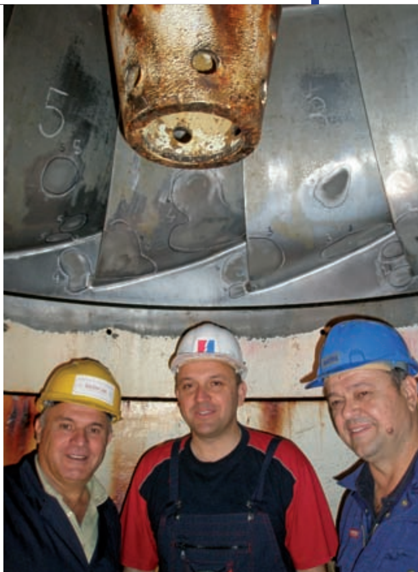
Tijekom radova obnove na agregatu 3, direktor HE Zakučac Ivan Krnić u turbinskom rotoru pridružio se stručnjacima iz tvrtki Salona var i Marting
