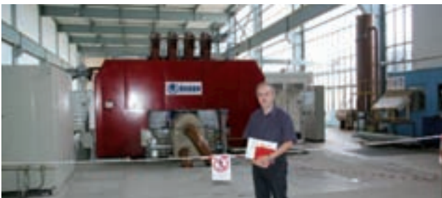
Damir Božičević, voditelj Tima za izgradnju Bloka L ispred parne turbine (proizvođača Škoda) koja je uspješno sinkronizirana s mrežom
