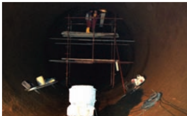
Sanacija oštećenja u kaloti desnog dovodnog tunela
