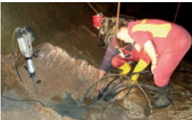
Sanacija oštećenja u podu tunelske obloge desnog dovodnog tunela
