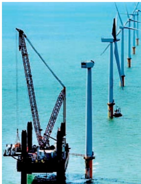
Offshore vjetroenergetski park u izgradnji
