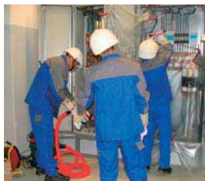
Čišćenje metalnog razvodnog ormara pod naponom
