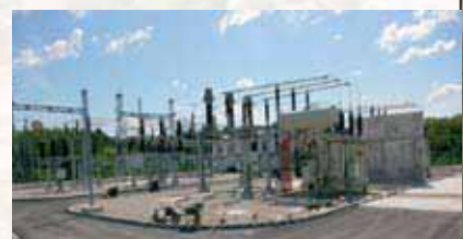
Rasklopno postrojenje je završeno, preostali su još manji građevinski radovi
