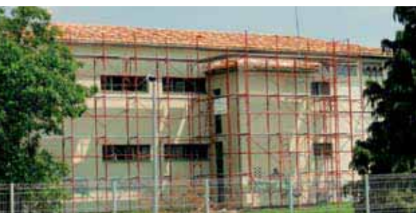
Zamjena ravnog kosim krovom nužna je kako bi se spriječilo prokišnjanje
