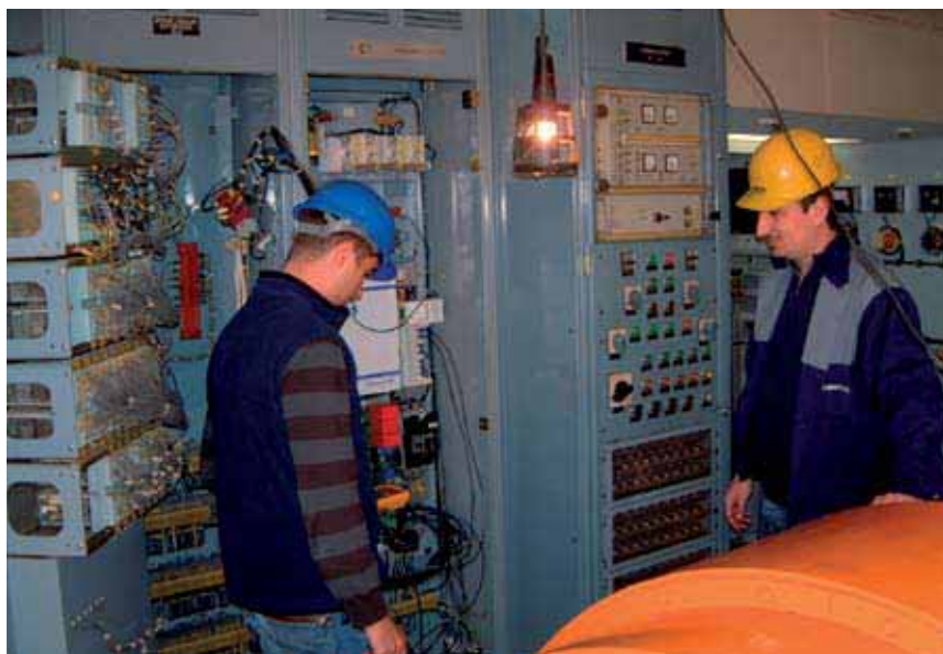
Prilagodba uzbudnih sustava agregata te novog sustava uzbuđivanja i sinkronizacije kućnog agregata
