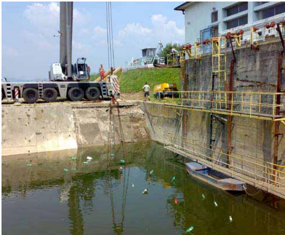
Crpna stanica za rashladnu vodu, prije ugradnje opreme za pročišćavanje i...
