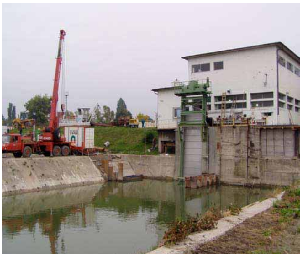
... nakon ugradnje dijela opreme za grubo pročišćavanje
