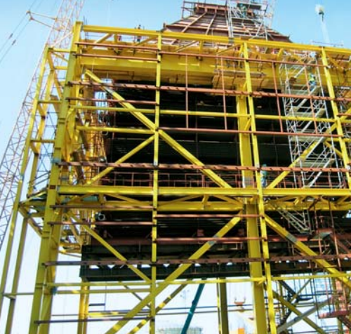
Završena montaža kotlovskih modula (ožujak 2011.)
