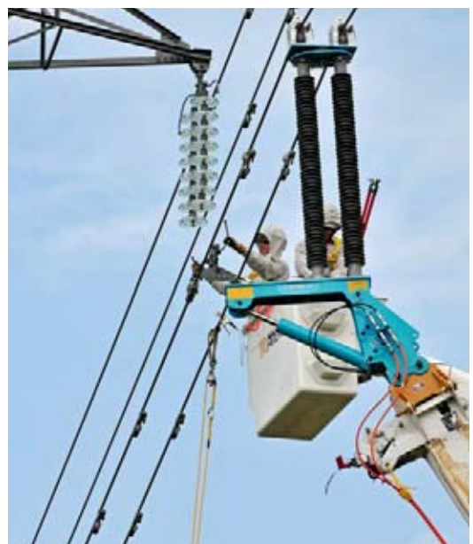
Vraćanje vodiča na zamijenjeni izolator - završetak rada
