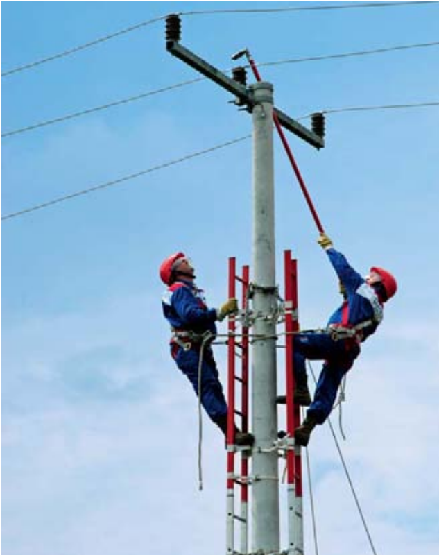
Zamjena zateznog izolatorskog lanca, jedna od vježbi zaposlenika HEP NOC-a na 20 kV naponu, koji su demonstrirali i postavljanje zaštite od ptica
