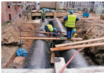
Spajanje izlaznog rashladnog cjevovoda (prosinac 2010.)
