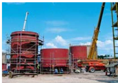
Predmontaža dimnjaka kotla utilizatora (svibanj 2011.)
