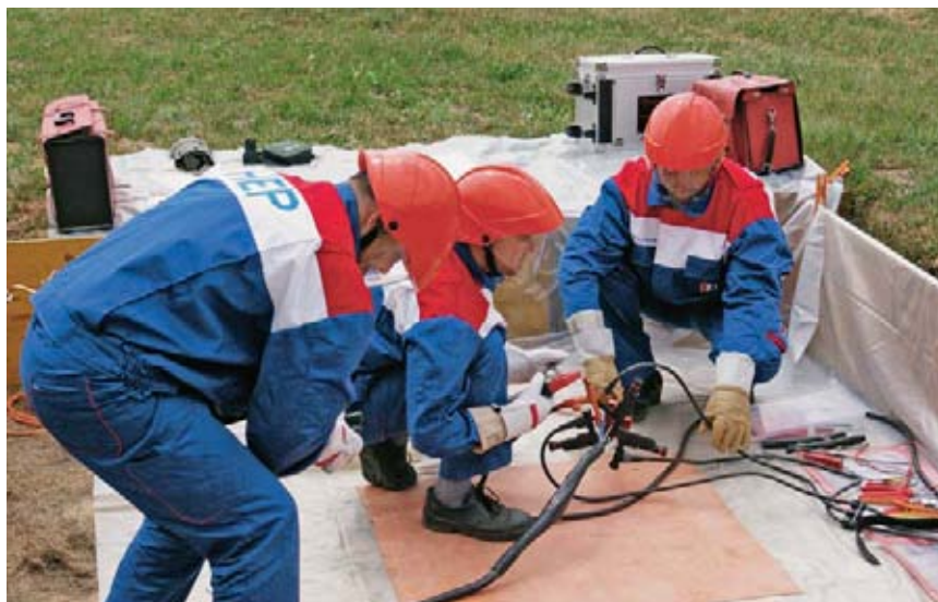
Elektromonteri Elektre Žadar demonstriraju popravak podzemnog kabela termoskupljajućom spojnicom, metodom "u dodiru" na 0,4 kV naponu
