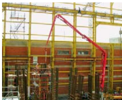
Betoniranje stupova temelja parne turbine (svibanj 2011.)
