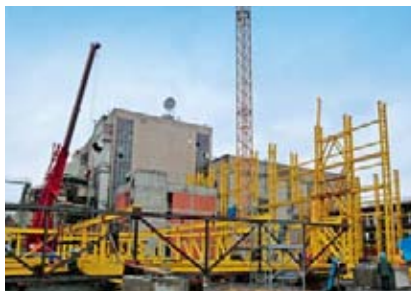
Početak montaže čelične konstrukcije kotovskog postrojenja (rujan 2010.)
