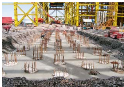
Podložni beton na temeljima plinske turbine (travanj 2010.)
