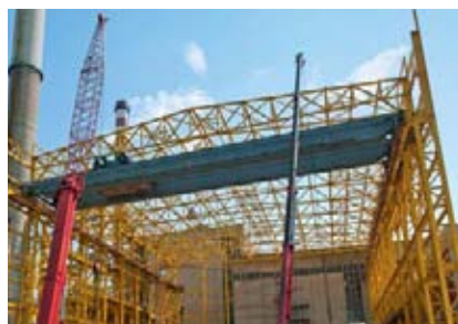
Montaža glavnog pogonskog kрана (travanj 2011.)
