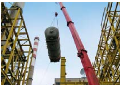
Postavljanje dearatora na poziciju (veljača 2011.)
