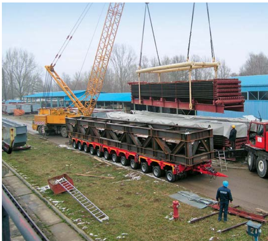
Priprema za podizanje i montažu kotlovskih modula (veljača 2010.)
