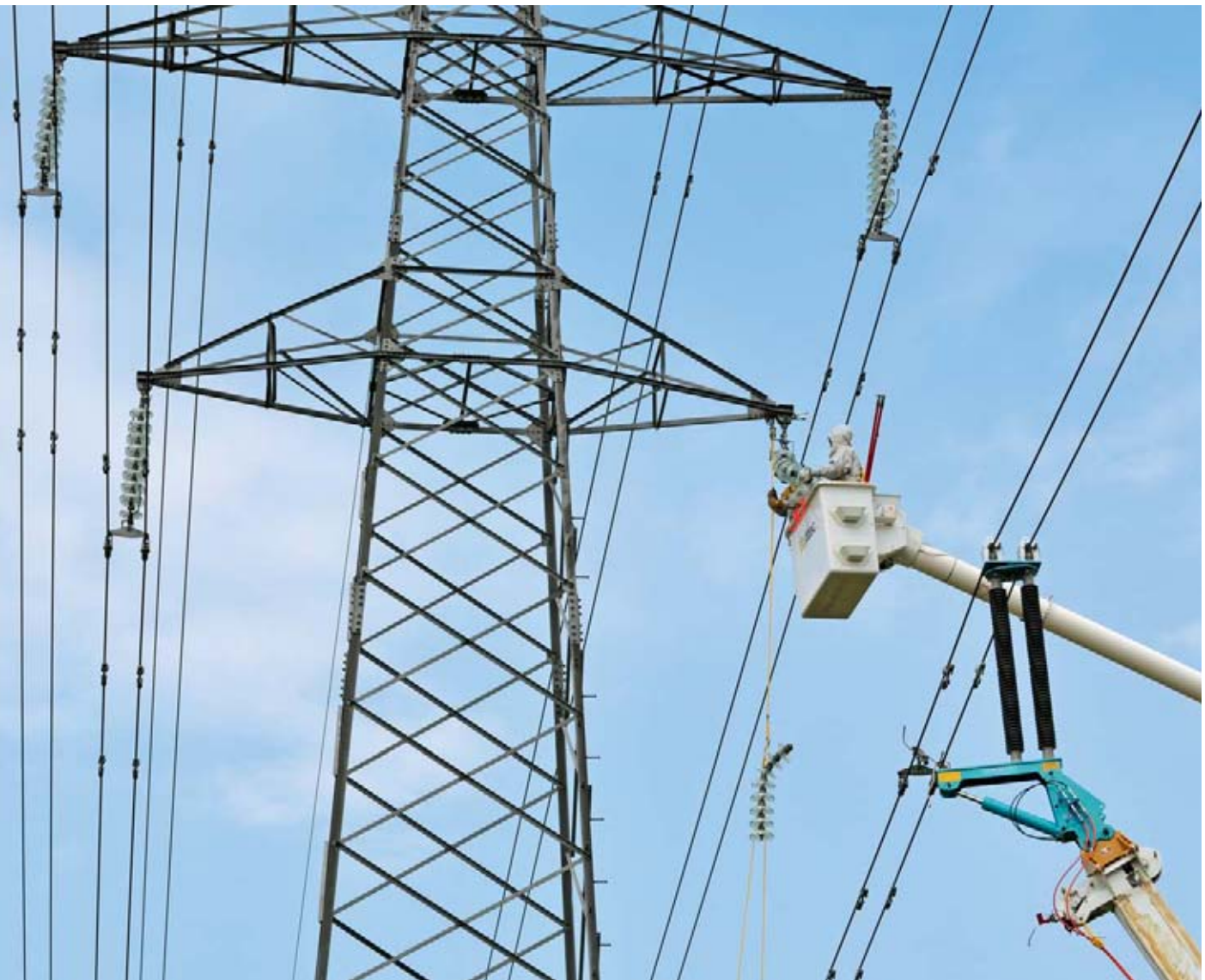
Zamjena nosivih izolatorskih lanaca - robotska ruka pridržava vodič
