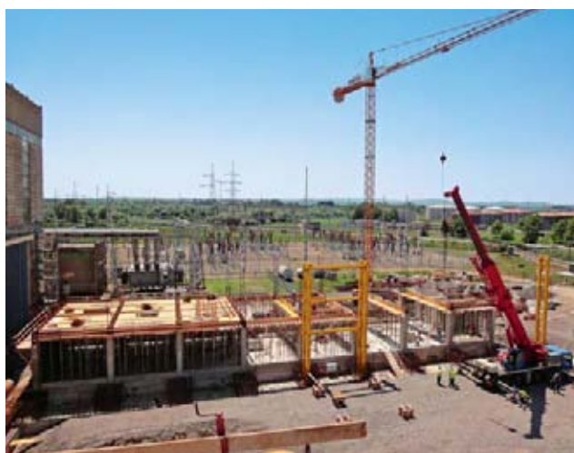
Početak montaže čelične konstrukcije glavnog pogonskog objekta (srpanj 2010.)
