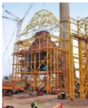
Montaža čelične konstrukcije dimnjaka kotla (travanj 2011.)
