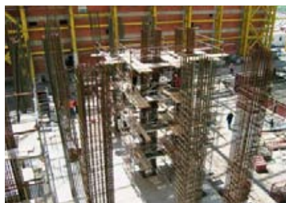
Izrada armature stupova temelja parne turbine (svibanj 2011.)
