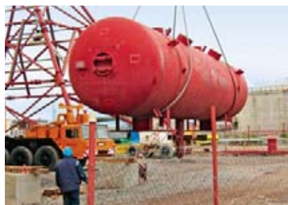
Podizanje niskotlačnog bubnja na kotlovsku konstrukciju (ožujak 2011.)
