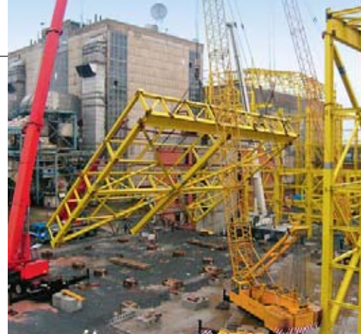
Podizanje čelične konstrukcije kotla (studeni 2010.)
