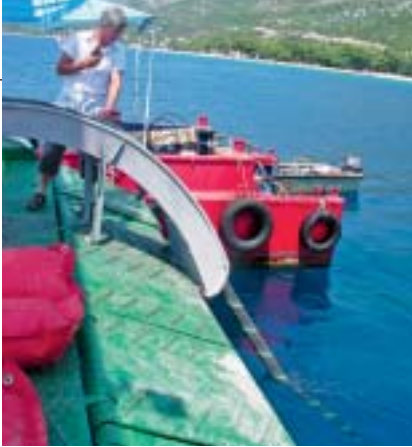
Naš kolega Mato Mijić iz Odjela za građenje budno je nadgledao kako kabel klizi u more
