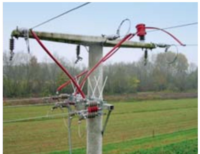
Izolacijski šiljci na stupu sprječavaju slijetanje ptica na kritično mjesto
