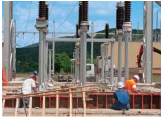
Ekipa podizvođača (Inero) betonira postolja prekidača
