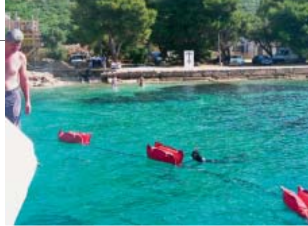
Ronilačka ekipa izvlači kabel prema obali, uz pomoć mekanog jastuka
