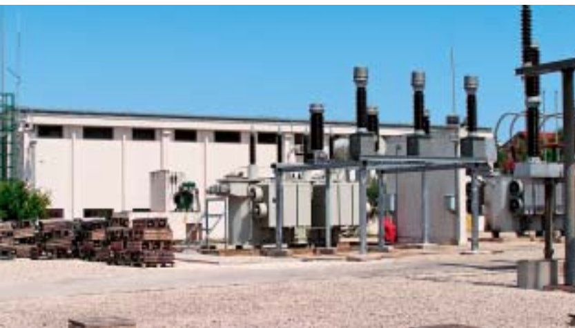
Rekonstrukcijom 10(20) kV postrojenja u TS 110/10 kV Benkovac, izgrađenom 1988. godine, bit će obuhvaćeni vanjski i...
