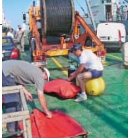
Istodobno je s podmorskim energetskim kabelom položen i svjetlovodni kabel T-Coma
