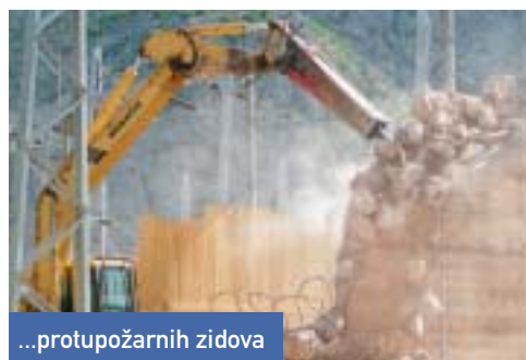
...rušenje temelja starog mrežnog transformatora i...
