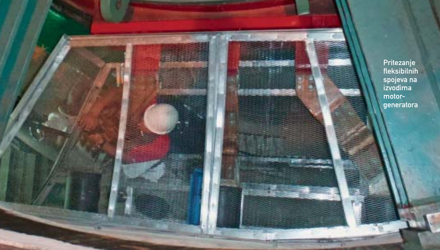
Posada RHE Velebit obavlja montažu gornjeg pokrova motor-generatora agregata A
