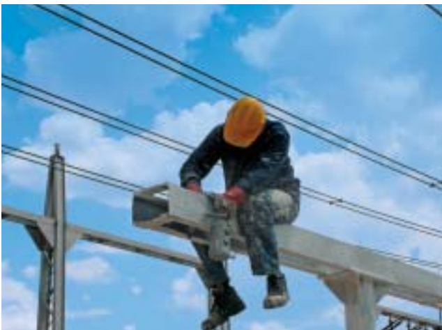
Nanosi se antikorozijska zaštita postolja
