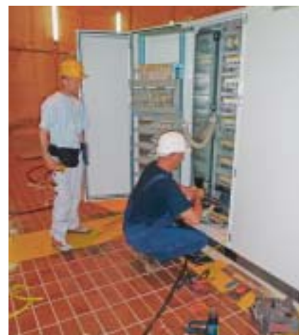
Zaposlenici Končar-INEM-a u ormaru upravljanja agregata A obavljaju doradu za potrebe pouzdanog napajanja istosmjernim naponom
