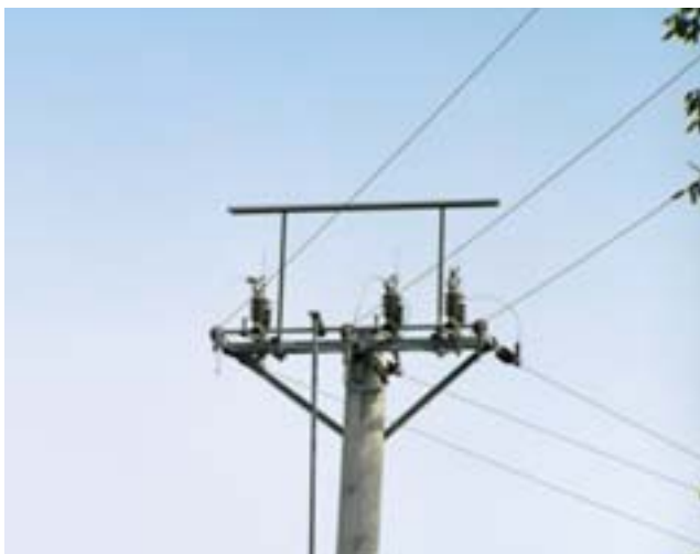
Ugrađena izolacijska prečka štiti ptice od strujnog udara na linijskom rastavljaču
