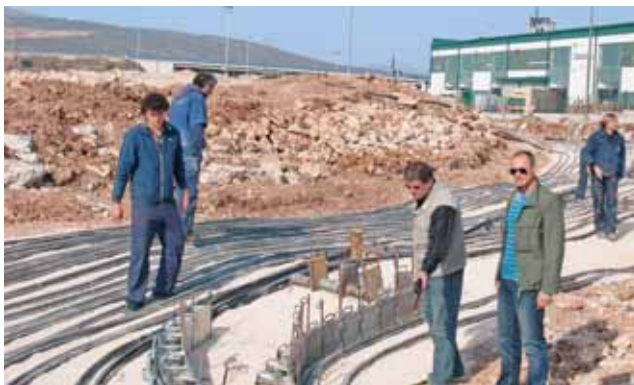
Zadnje kabelske trojke su ubrzo u kanalu, a tijekom posla zaposlenika Odjela građenja na trasi nadziru voditelji gradilišta A. Batarelo i T. Mladinić
