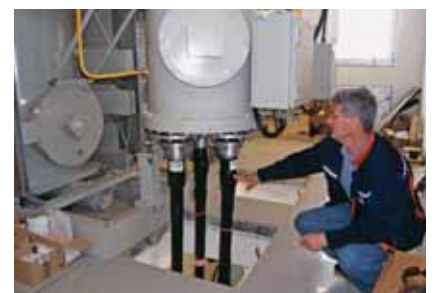
M. Mijić pokazuje upravo izrađene kabelske glave u TS Dugopolje
