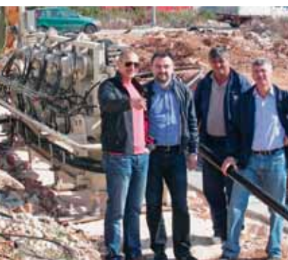
Pri polaganju 110 kV kabela (s lijeva na desno) A. Batarelo - glavni inženjer gradilišta, Robert Raguž - nadzorni inženjer u TS Dugopolje, Jure Bilan - elektromonter i Mato Mijić - voditelj poslova kabliranja
