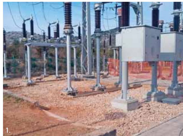
1. U okviru nastavka prošle godine započete rekonstrukcije 110 kV postrojenja, zamijenjena je primarna oprema i provedena antikorozijska zaštita postolja u 110 kV polju DV Ražine 1 2. U spojnom polju montiran je novi prekidač 7E1
