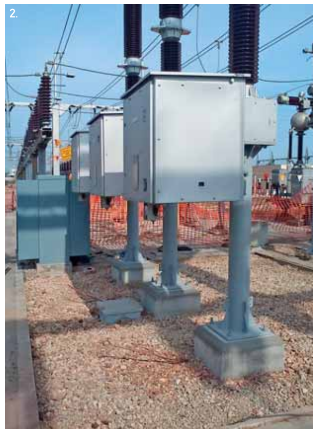
1. U okviru nastavka prošle godine započete rekonstrukcije 110 kV postrojenja, zamijenjena je primarna oprema i provedena antikorozijska zaštita postolja u 110 kV polju DV Ražine 1 2. U spojnom polju montiran je novi prekidač 7E1
