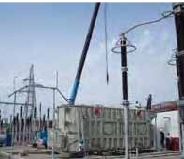
Montaža novog mjernog autotransformatora nakon sretnog dolaska na odredište
