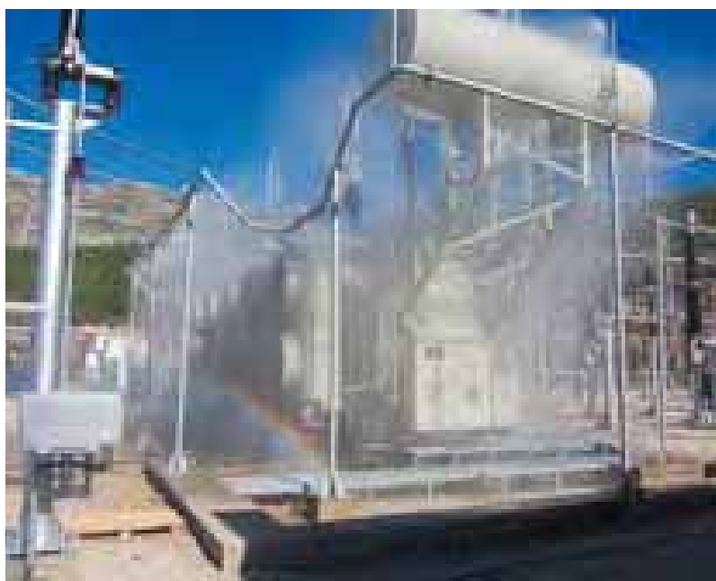
Ispitivanje prilagođene protupožarne zaštite
