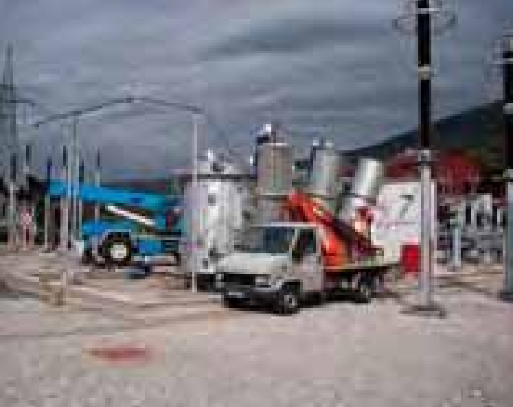
Demontaža starog mrežnog autotransformatora, proizvedenog 1983., koji (više) nije bio pouzdan i...
