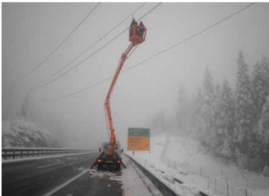
Gorani su prvi put morali intervenirati na autocesti Rijeka-Zagreb gdje je snježni teret previše prizemljio vodiče
