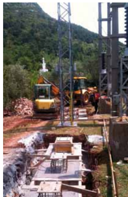
Radovi na temeljima odvodnika prenapona
