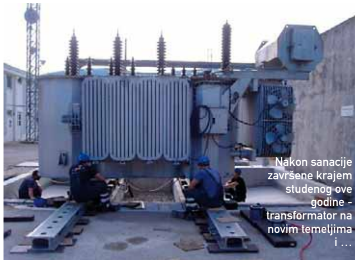
Ovakvo stanje kade i temelja za drugi transformator odredilo ga je kao hladnu rezervu na čekanju za priključak
