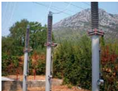
Novi odvodnici s brojačima
