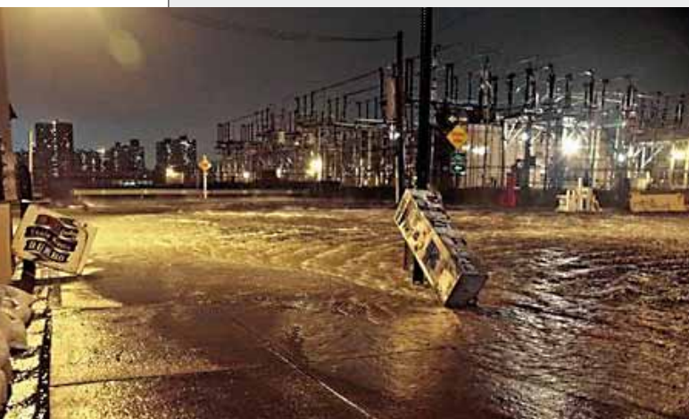
Poplavljeni ulice oko jedne Con Edisonove trafostanice u Brooklynu, nakon izlivanja East Rivera
