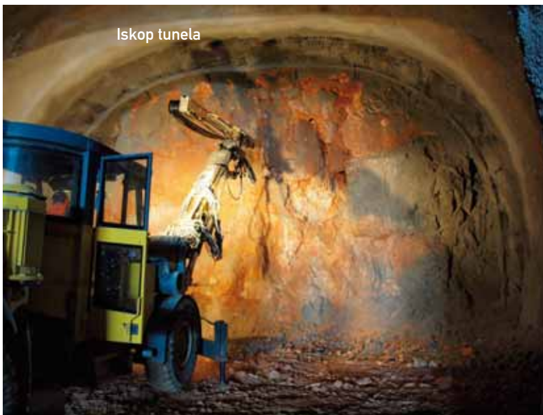
Primjenjuju se najstroži sustavi podgrađivanja, odnosno cjelokupan iskop je podgrađen primarnom podgrađom za IV. i V. kategoriju, uz ugradnju čeličnih lučnih nosača
