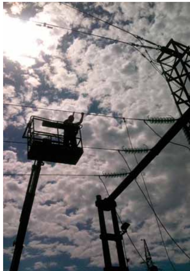
Montaža odvodnika u polju DV Komolac
