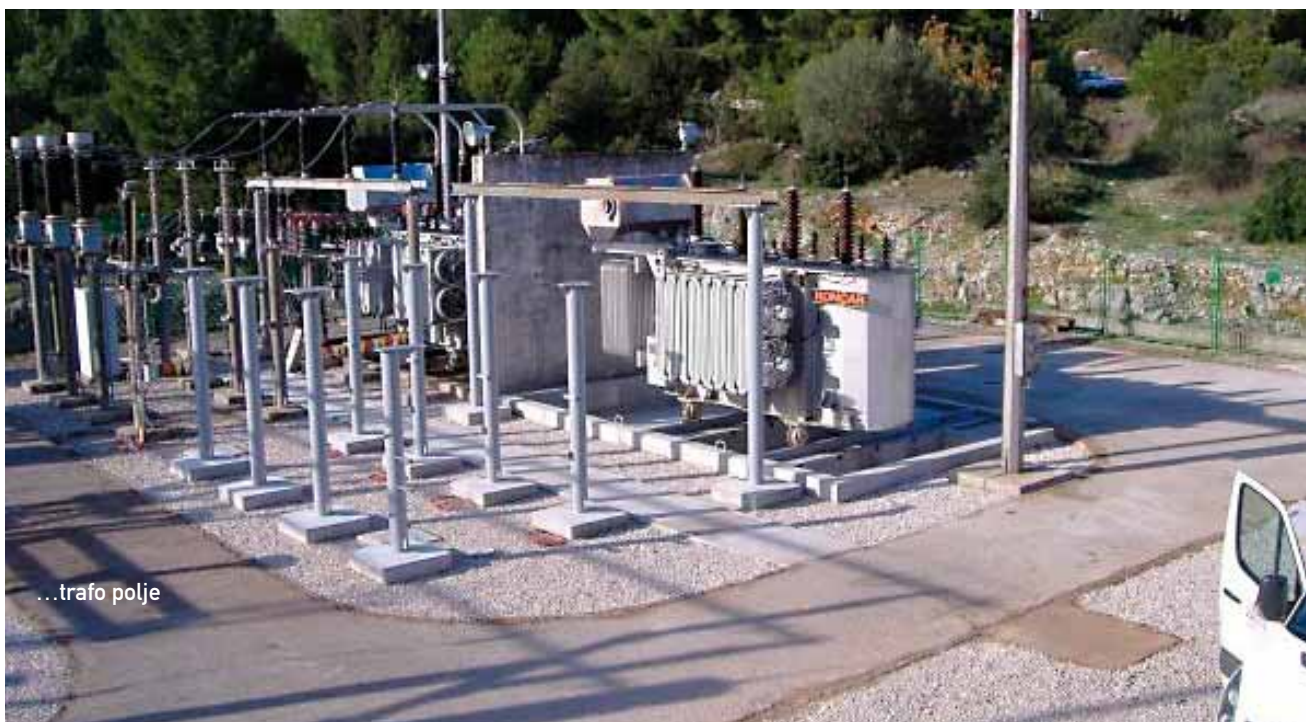
Nakon sanacije završene krajem studenog ove godine - transformator na novim temeljima i ...
