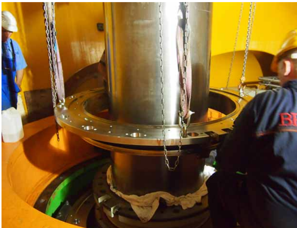
Pripremanje nosača turbinske brtve za ugradnju
