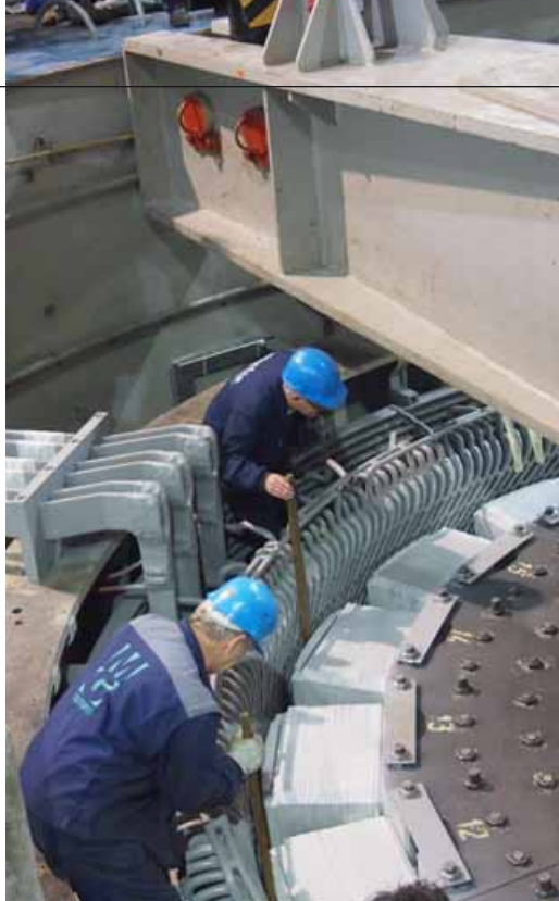
Centriranje rotora generatora pri spuštanju u stator
