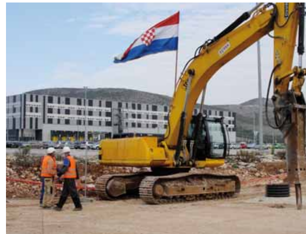
Nakon Konferencije, kao svojevrsnog uvoda, u industrijskoj zoni Dugopolje započela je izgradnja sekundarne plinske mreže
