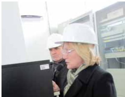
Trafo stanicu je u pogon pustila Ljiljana Čule - direktorica HEP Operatora distribucijskog sustava
