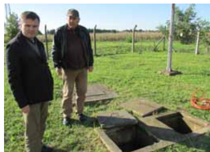
Mario Pisačić i Damir Mur: u Elektroslavoniji se vodi briga o zaštiti okoliša i stoga je iznimno važno provjeravati vodonepropusnost uljnih jama
