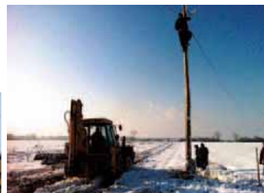
Osim uništenih vodiča, na dalekovodu 10 kV Vrbovečka Luka slomljeno je šest stupova...dovlačenje, podizanje stupova
