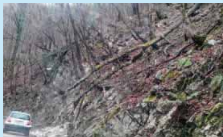
Velika bukva visi na dijelu korijena iznad ceste kojom zaposlenici dolaze na posao - bez opasnosti dok bukva miruje. a pitanje je kada će se odvojiti od korijena i strovaliti na nju
