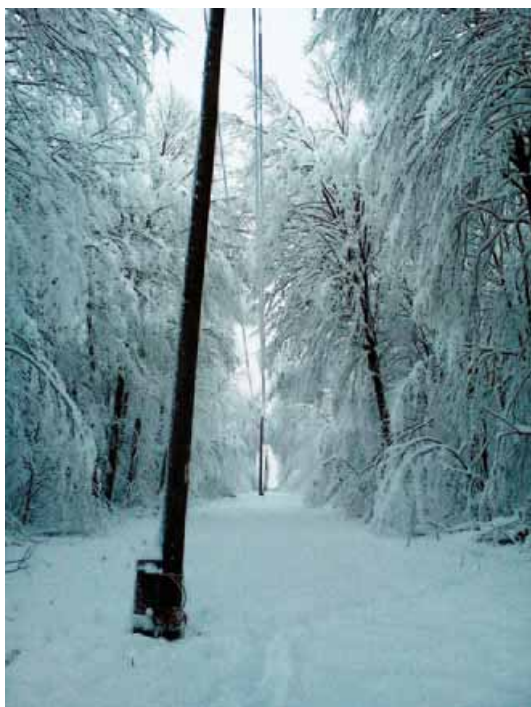
Gusti i mokri snijeg savijao je i lomio grane koje su dodirivale i trgale 20 kV i 0,4 kV mrežu, a najviše su stradali južni dijelovi Pogona - bilo je ukupno 38 ispada izlaznih vodova iz trafostanice Brezovica
