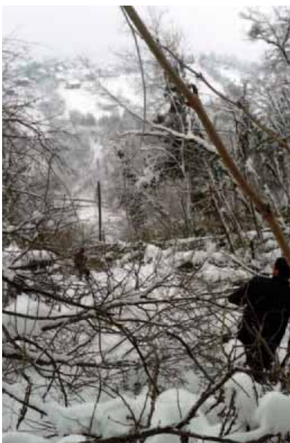
Prtiti snijeg, ukloniti šumu grana, osloboditi vodiče
