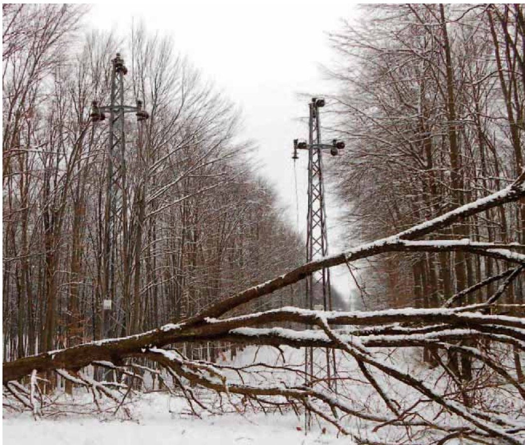
Na trasi dalekovoda 20 kV Kupljenovo, stablo u šumi Veliki vrh oštetilo je i stup 19. jedan od srušenih čeličnorešetkastih stupova, monter na stupu i potpora s tla
