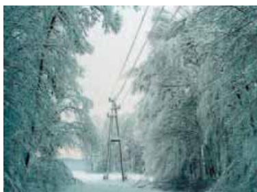
Gusti i mokri snijeg savijao je i lomio grane koje su dodirivale i trgale 20 kV i 0,4 kV mrežu, a najviše su stradali južni dijelovi Pogona - bilo je ukupno 38 ispada izlaznih vodova iz trafostanice Brezovica
