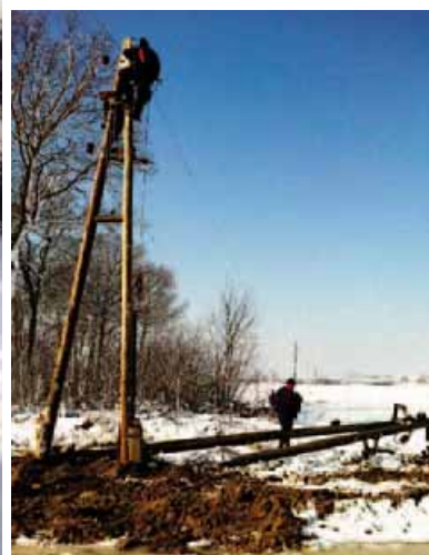
Osim uništenih vodiča, na dalekovodu 10 kV Vrbovečka Luka slomljeno je šest stupova...dovlačenje, podizanje stupova
