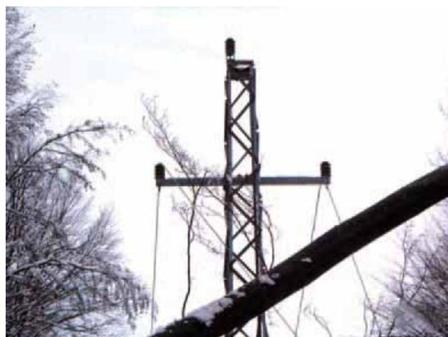
Na trasi dalekovoda 20 kV Kupljenovo, stablo u šumi Veliki vrh oštetilo je i stup 19. jedan od srušenih čeličnorešetkastih stupova, monter na stupu i potpora s tla
