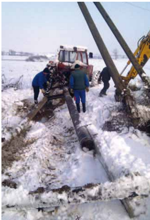
Osim uništenih vodiča, na dalekovodu 10 kV Vrbovečka Luka slomljeno je šest stupova...dovlačenje, podizanje stupova
