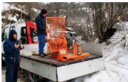
Žica s kamioneta razvlači se na predjelu Fužine-Vrata
