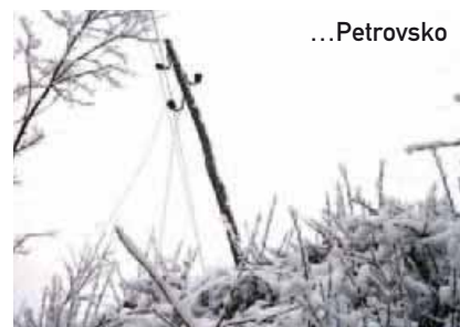
Oštećeni vod 10 kV Jesenje-Hromec Pogonskog ureda Krapina i ...
