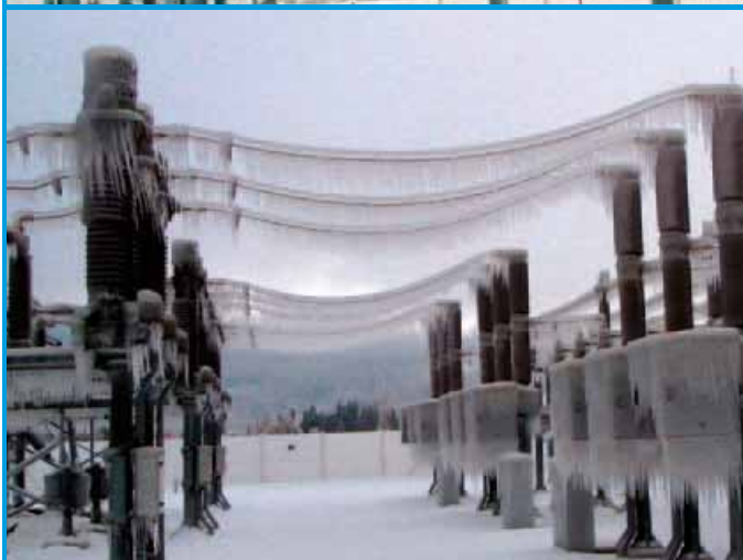
Prizori iz Elektrovrčne postaje Vrata, čija je postrojenja led doslovce okovao
