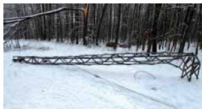
Na trasi dalekovoda 20 kV Kupljenovo, stablo u šumi Veliki vrh oštetilo je i stup 19. jedan od srušenih čeličnorešetkastih stupova, monter na stupu i potpora s tla
