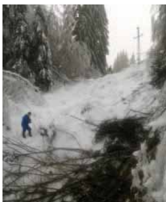
Monteri Pogona Ogulin podići će vodiče dalekovoda Radojčići (Drežnica)
