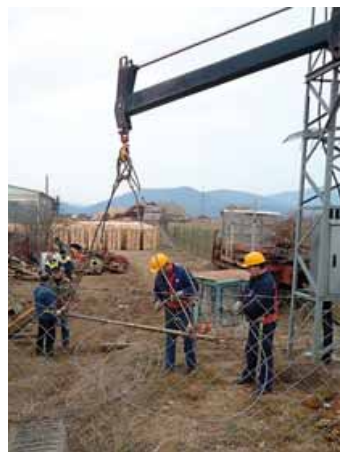
Pripreme čvrstog hvatača teškog rodnog gnijezda na stupnoj trafostanici, na tlu
