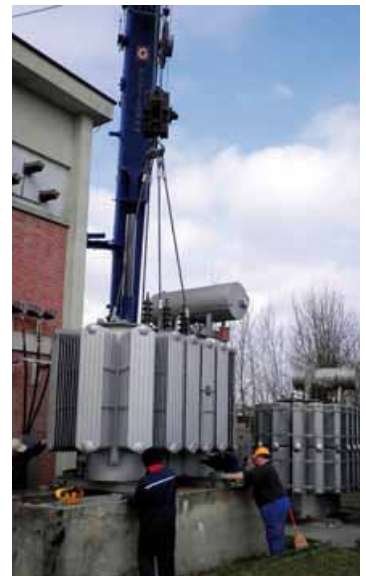
Novi jači transformator na svom je mjestu
