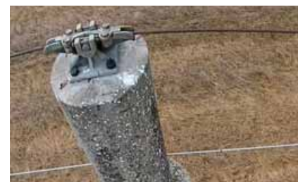
Osim izgleda izolatora, može se provjeriti i izgled krune stupa, gdje je spojeno zemno uže... - sve bez isključenja napona i bez penjanja na stup
