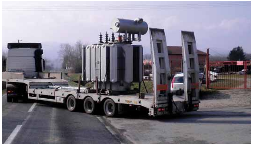
Novi transformator težine 16,5 tona doprema se u krug TS 35/10 kV Orahovica
