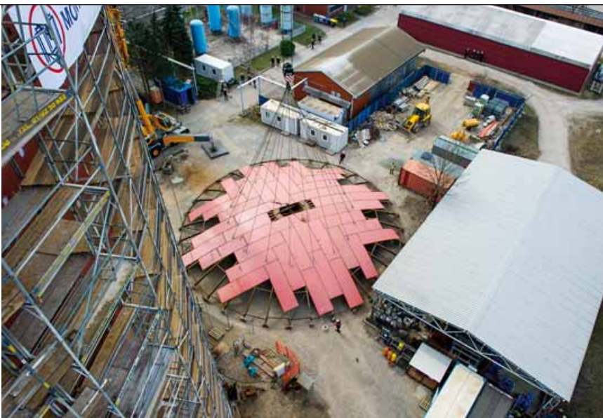
Krovná konstrukcija na tlu spremno čeka početak zahvata
