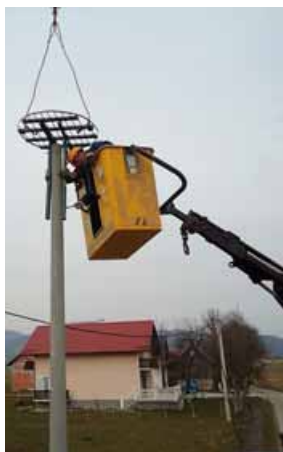
Na u blizini postavljeni AB stup, zaposlenici Pogonskog ureda Brinje spuštaju odgovarajuću platformu za rodino gnijezdo
