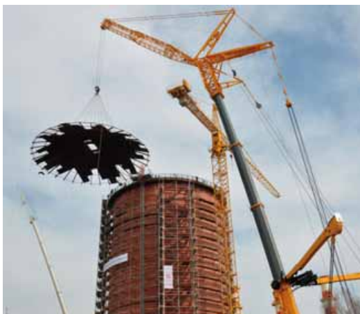
Divovska dizalica bez pogreške Može započeti spuštanje postupno podiže krov
