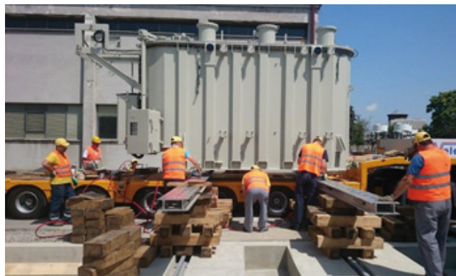
Radovi na ugradnji novog transformatora u TS Osijek 3
