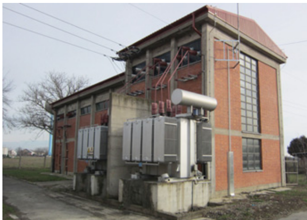
Rekonstruirana Trafostanica 35/10(20) kV Čepin
