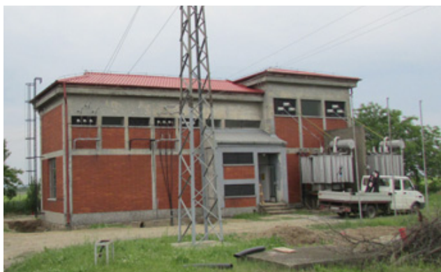
Preuređenje Trafostanice 35/10kV Dalj započelo je proljeće
