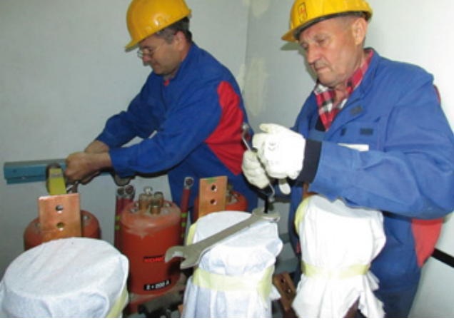
Dobro uigran tim Odjela za izgradnju: dok su Vlado Eling i Stjepan Vuk u TS 35/10 kV Dalj demontirali strujne mjerne transformatore...
