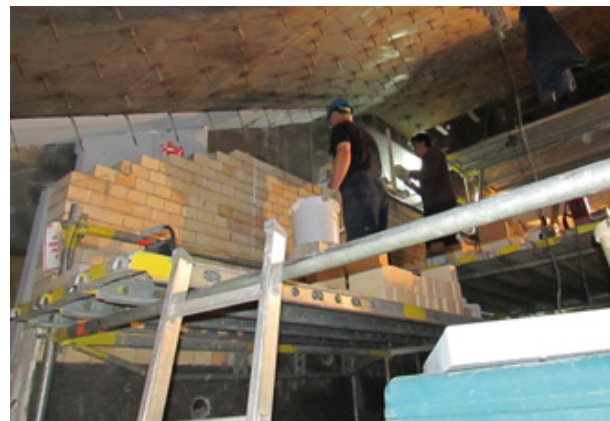
Pogled unutar ložišta: postavljanje vatrootalnih obloga, odnosno "šamotiranje"
