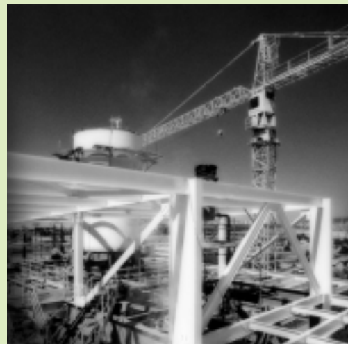
TE-TO Zagreb - novo kombi-kogeneracijsko postrojenje u izgradnji
