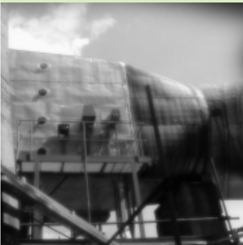
TE Sisak - sustav za kontinuirano mjerenje emisije onečišćujućih tvari u zrak
