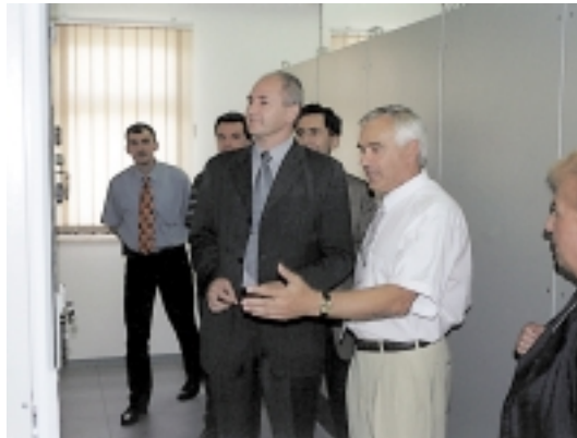
Predsjednik Uprave HEP-a Ivo Čović i drugi uzvanici razgledavaju unutrašnjost trafostanice Katoro
