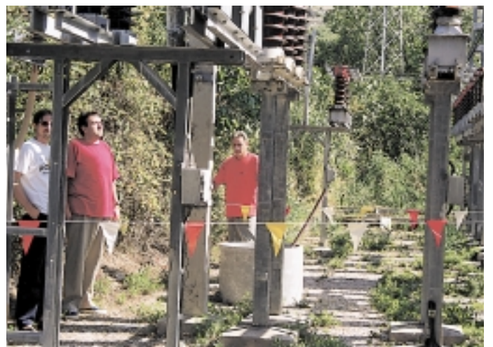
Tihomir Mimica, uklopničar, zaštitnim zastavicama ogradio je mjesto rada
