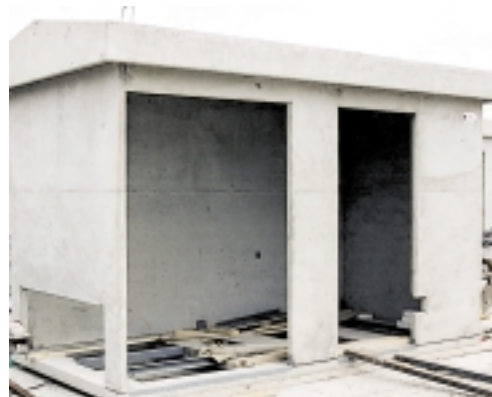
KTS s kosim krovom, težina pojedinih kućišta kreće se između šest i osam tona
