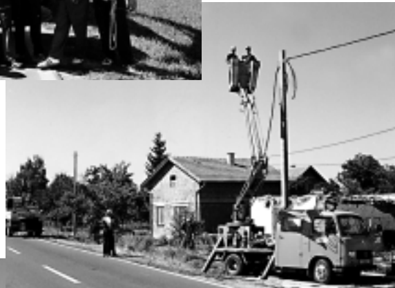
Razvlačenje kabela za niskonaponsku mrežu Čemince na temperaturi od 37°C
