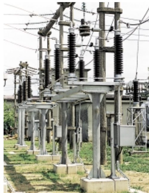
... kojih su u prvoj fazi revitalizacije zamijenjeni stari prekidači 110 kV u tri vodna polja s novim SF 6 prekidačima Siemens
