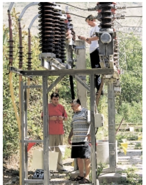
Tihomir Mimica, uklopničar, zaštitnim zastavicama ogradio je mjesto rada
