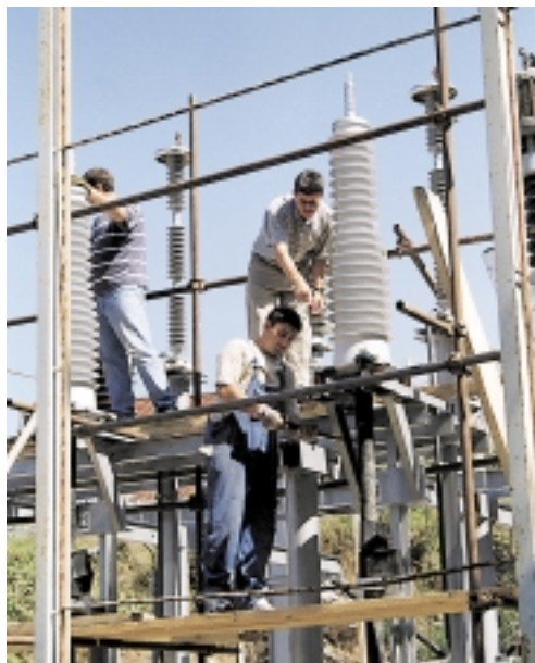
Montaža uzemljenja i odvodnika prenapona
