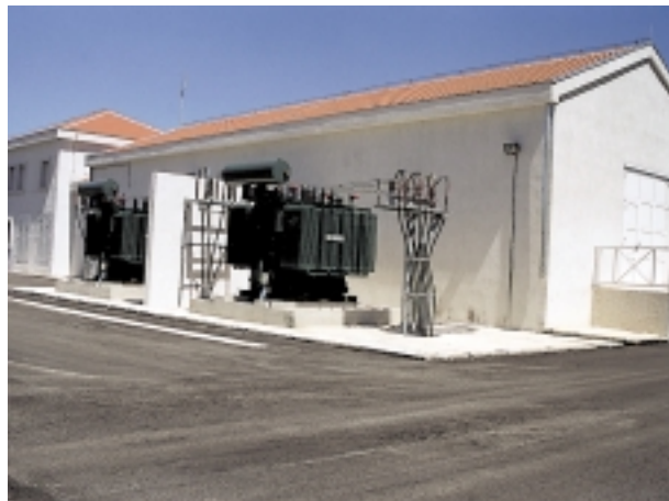
Nova TS 110/35/10 kV Drniš, čije će 35 kV postrojenje biti pušteno u rad sredinom kolovoza
