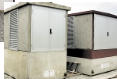
VTS, djelomično ukopana, za vanjsko posluživanje
