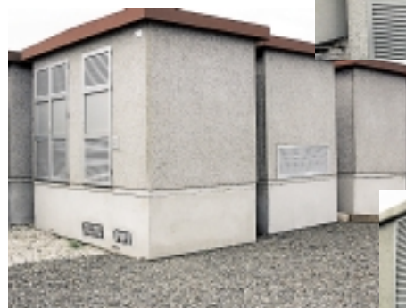
VTS, djelomično ukopana, za vanjsko posluživanje
