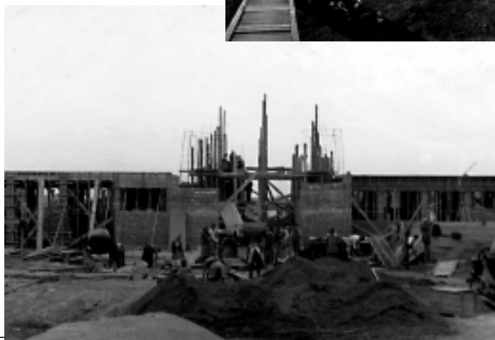
Izgradnja TS 110/35 kV Slavonski Brod 1954. godine
