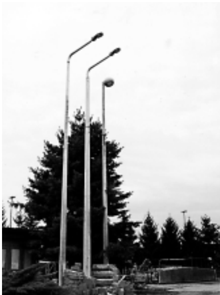
Centrifugalni betonski stupovi za javnu rasvjetu... i
