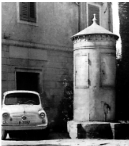
TS limene izvedbe, jedna od prvih trafostanica na Lošinj
