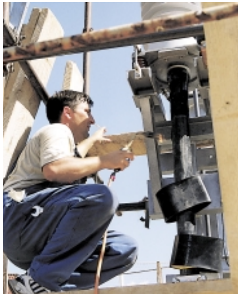
Postavljaju se zaštitne cijevi
