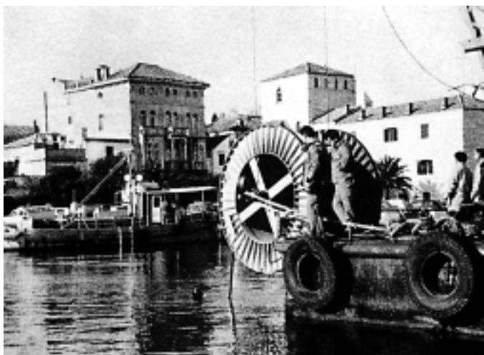
Polaganje podvodnih kabela u Rapskoj luci
