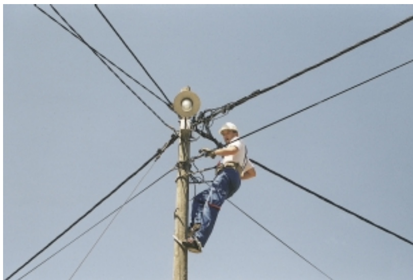
Žarulja je pregorjela, ali zato su tu penjalice i Damir koji će to brzo riješiti, jer tko zna koliko je vruće gore na stupu
