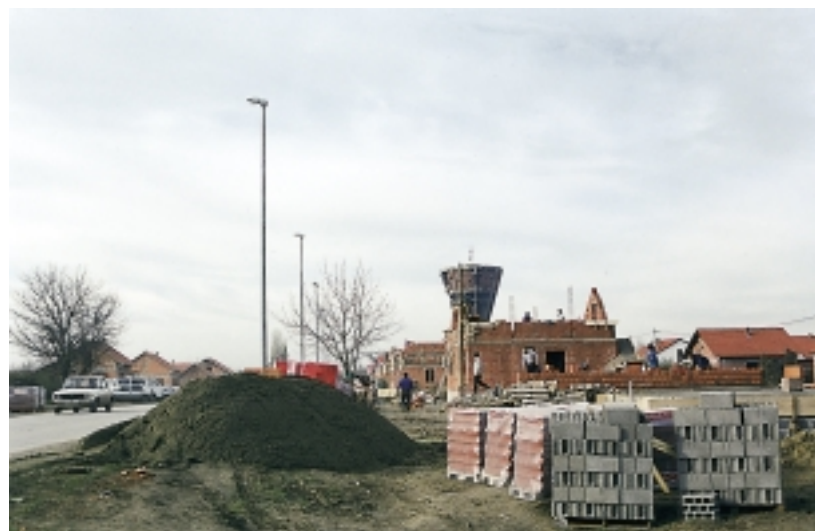
Industrogradnja intenzivno obnavlja kuće pokraj Vodotoranja
