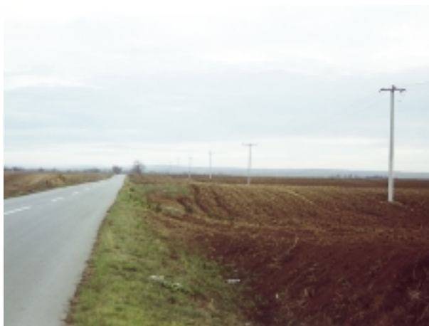
Dalekovod Opatovac-Šarengrad - izgrađen za samo 12 dana
