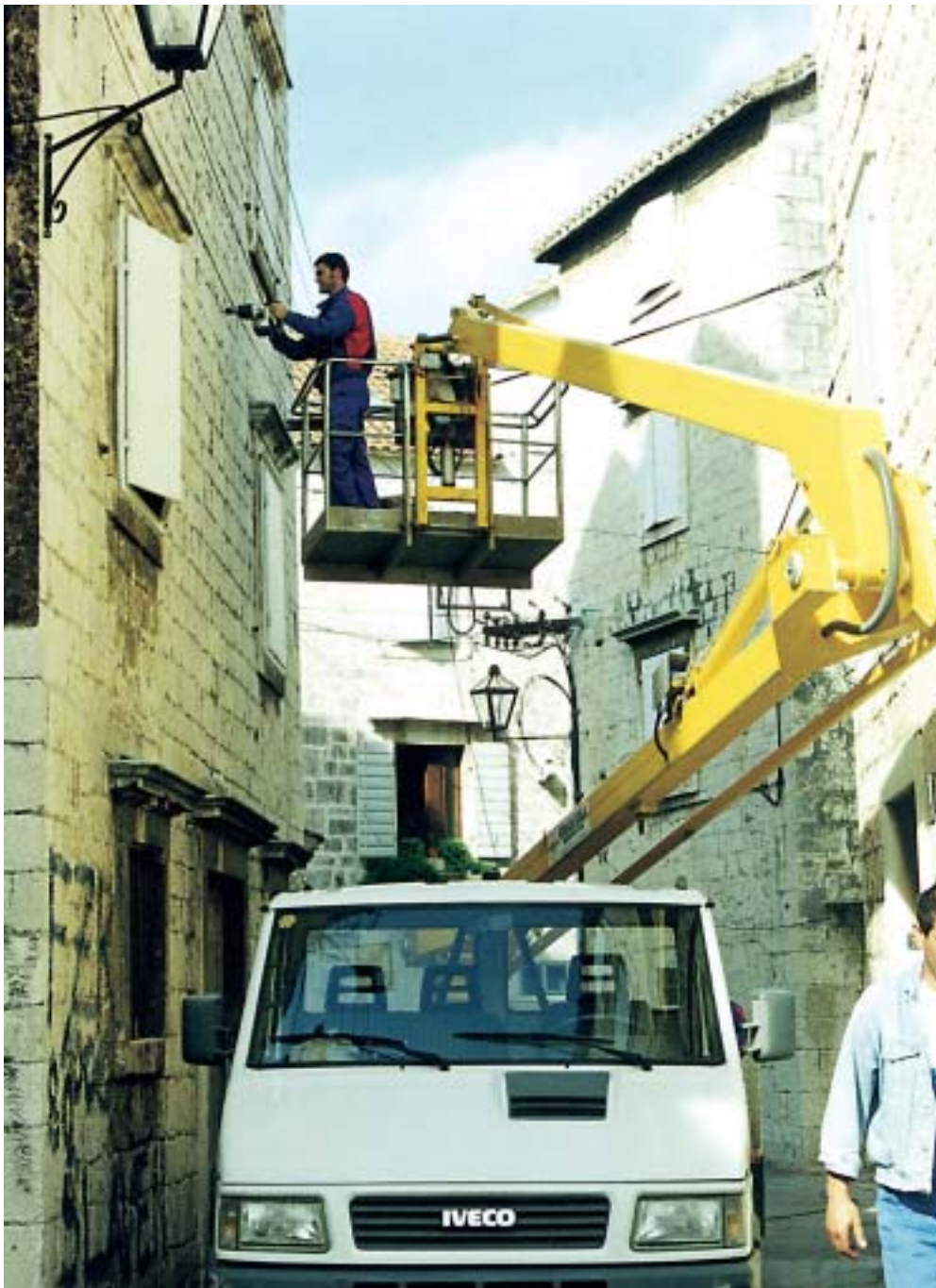
Trogirski elektromonter Mijo Lovrić montira nosače kablskog snopa na fasade
