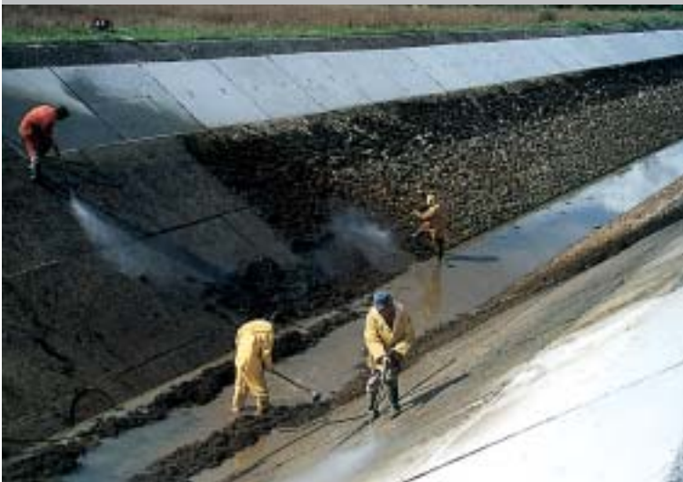
Debele naslage raslinja, trave i mahovine sa zidova kanala Marasi najprije se ispiru mlazovima vode pod jakim pritiskom, a potom se isprano vadi iz korita
