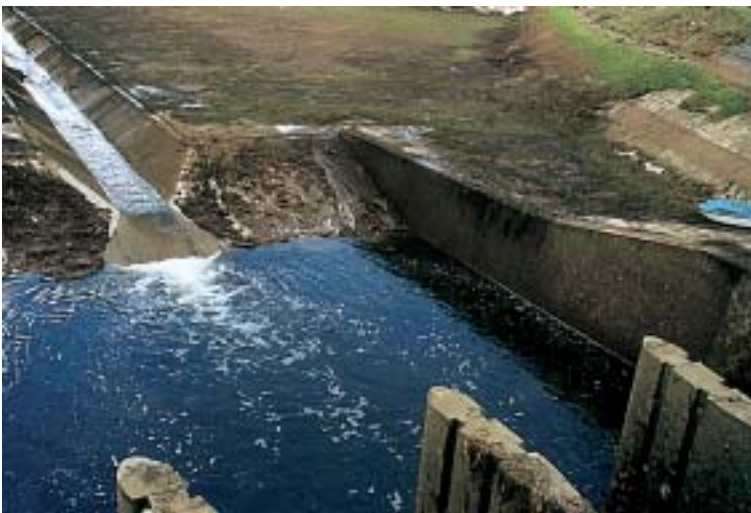
Akumulacija za dnevno izravnavanje HE Senj Gusić polje ispražnjena je, ali se određena količina vode mora očuvati za napajanje vodovoda podvelebitskih naselja
