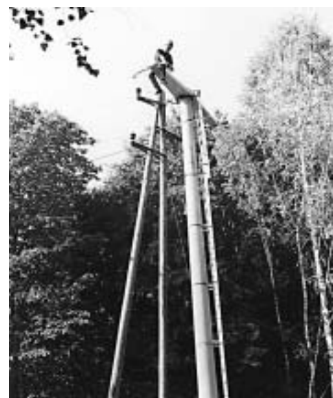
Priprema visinskog dalekovodnog stupa
