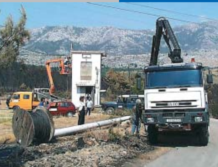
Puno posla bilo je od Omiša do Krilo Jesenica, a ovdje je područje Tugare gdje se za dići u zrak pripremaju novi betonski stupovi
