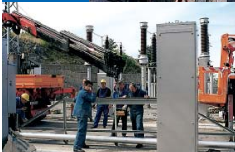
Dizalice Prijenosnog područja Opatija i DP Elektroprimorje Rijeka spremne za podizanje sabirnice
