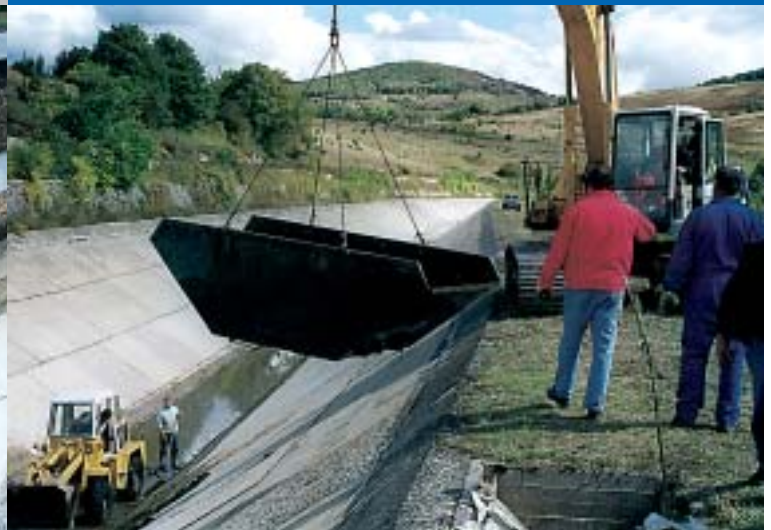
Debele naslage raslinja, trave i mahovine sa zidova kanala Marasi najprije se ispiru mlazovima vode pod jakim pritiskom, a potom se isprano vadi iz korita
