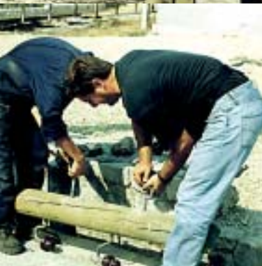
Ivan Dujmić i Denis Podrug pripremaju stup za ugradnju u kućinsku mrežu niskog napona
