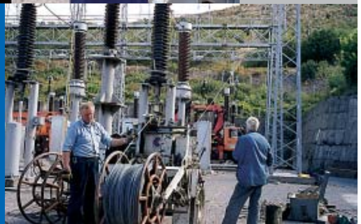
Dizalice Prijenosnog područja Opatija i DP Elektroprimorje Rijeka spremne za podizanje sabirnice
