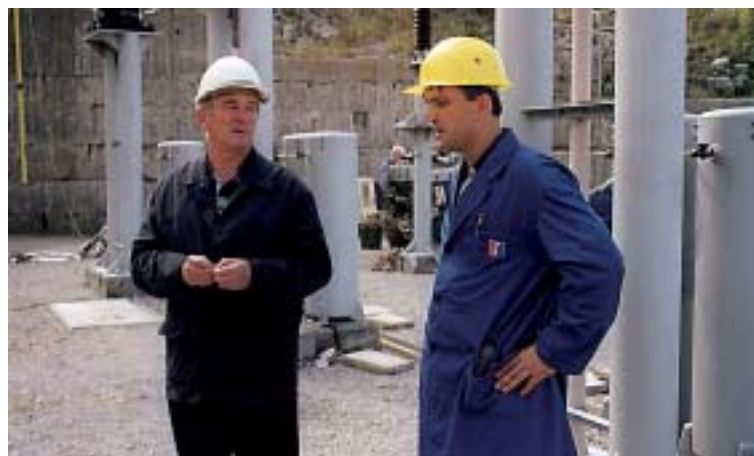
Direktor HE Senj Josip Brkljačić i upravitelj pogona HE Senj Dario Škrkatić, zadovoljni su s onim što su vidjeli na rasklopištu 220 kV na kojemu je u tijeku promjena opreme
