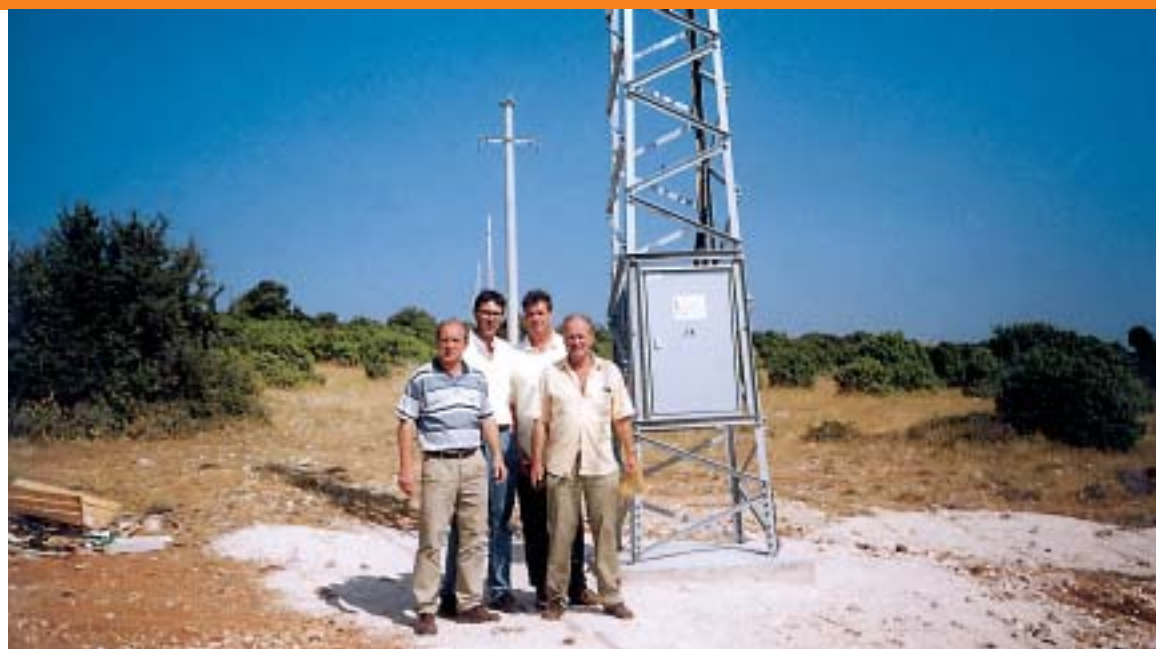
Rukovoditelj Pogona Cres-Lošinj riječkog Elektroprimorja Sergio Grbin sa suradnicima: V. Šainom, Ž. Aleksom i G. Samardžićem ispred novoizgrađene trafostanice Verin u Verinu na otoku Cresu, zahvaljujući kojoj je ovo naselje napokon dobilo električnu energiju
