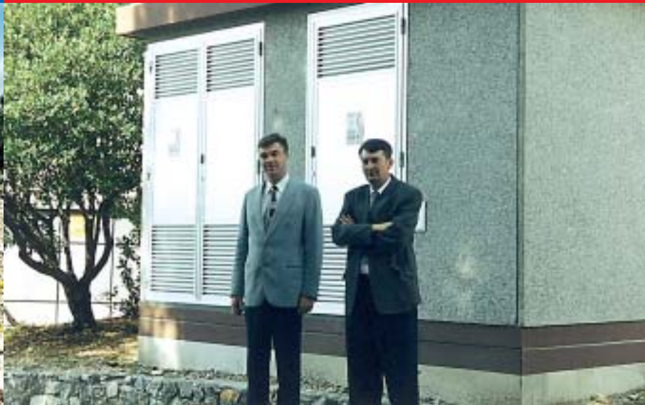
Nenad Tomić, rukovoditelj Pogona Trogir i Domagoj Milun, rukovoditelj Odjela za tehničke poslove, ispred trafostanice u hotelskom naselju, koja je puštena u rad tijekom kolovoza ove godine
