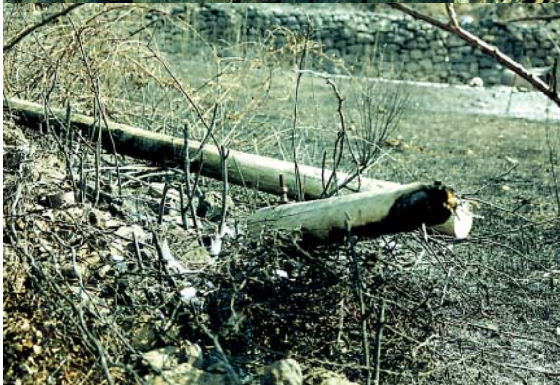
Evo što je ostalo od stupova nakon ovoljetnih požara
