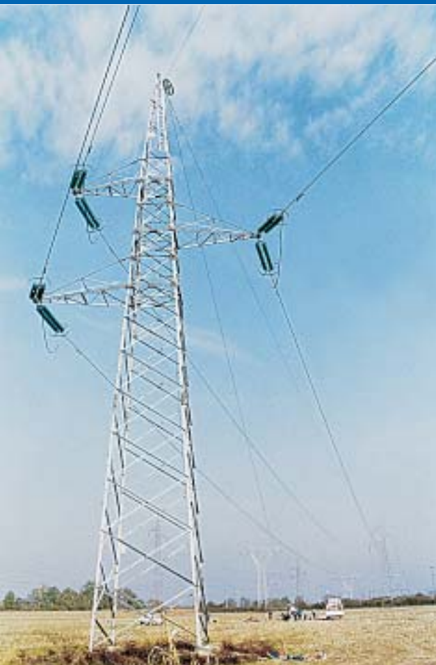
Na DV 220 kV TS Mraclin - TS Brinje optika je montirana još 1997. godine
