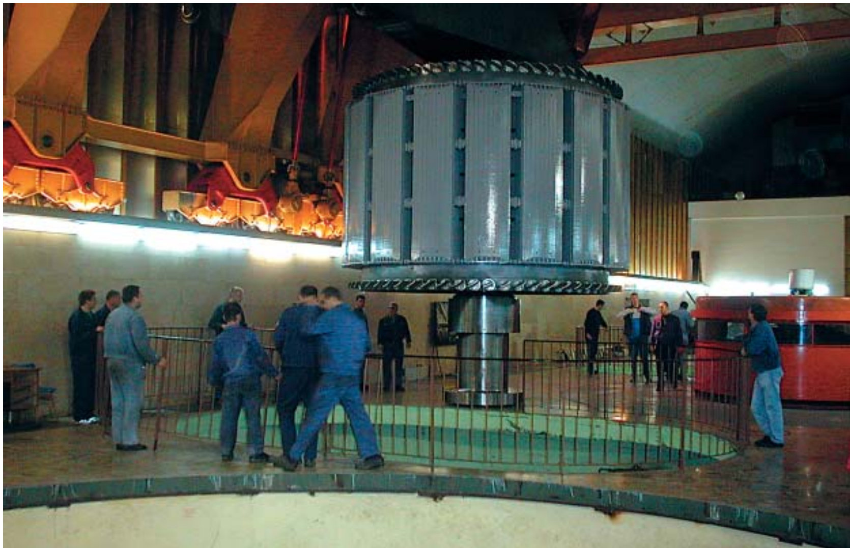
Remont na trećem agregatu započeo je 6. srpnja i trajat će do kraja studenog ove godine: vraćanje rotora u stator
