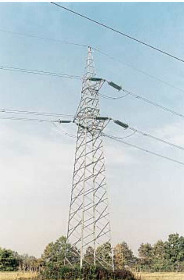
Montaža optičke užadi na DV 220 kV TE Sisak - TS Mraclin
