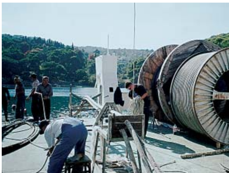
Polaganje tri jednožilna kabela odvija se s trajekta
