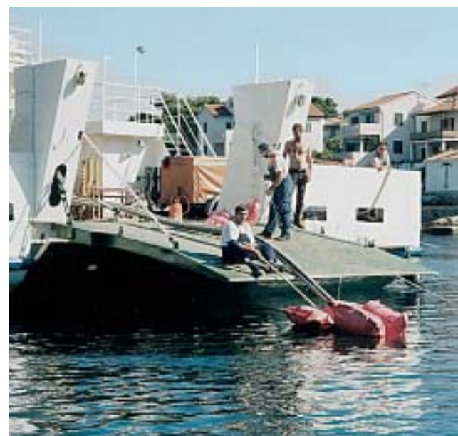
Nakon što je kvar otklonjen, kabel se vraća moru
