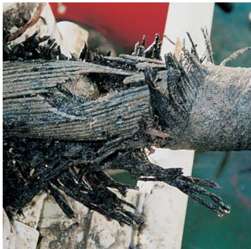
Uzročnik kvara: rupa na olovnom plaštu kabela
