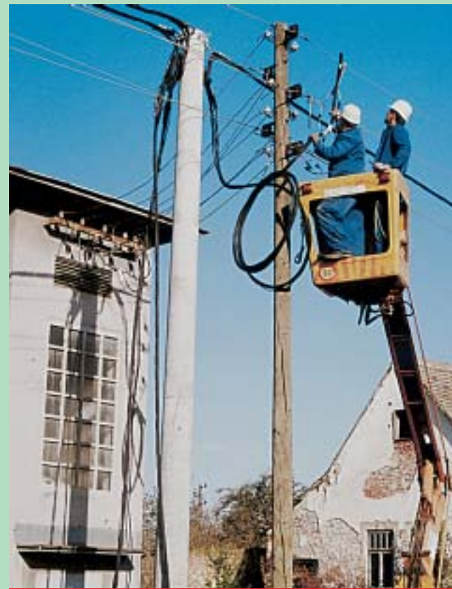
Ekipa Pogona Nova Gradiška na rekonstrukciji niskonaponske mreže
