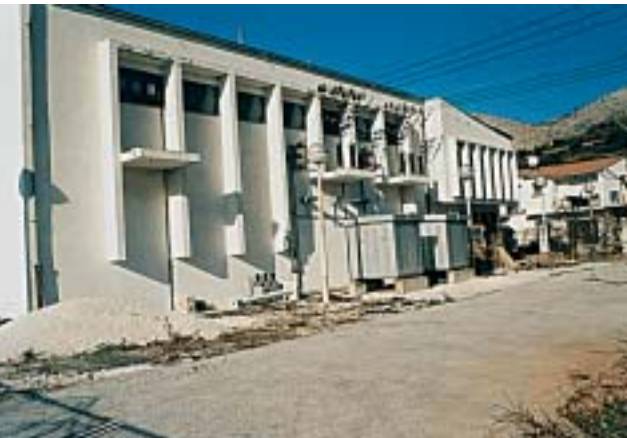
TS 110/35 KV smještena na predjelu Muline u Trogiru
