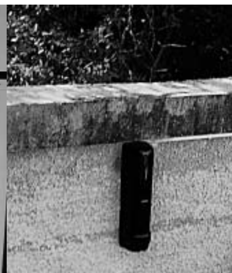
Protuprovalna barijera koja alarmira u slučaju neovlaštenog kretanja u štićenom prostoru
