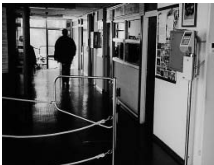
I unutar zgrade Pogona Opatija postoje prepreke koje usmjeravaju kretanje stranaka, a zaposlenici ih otvaraju zaduženim karticama. Na slici je i terminal za registraciju radnoga vremena i nadzor prolaska
