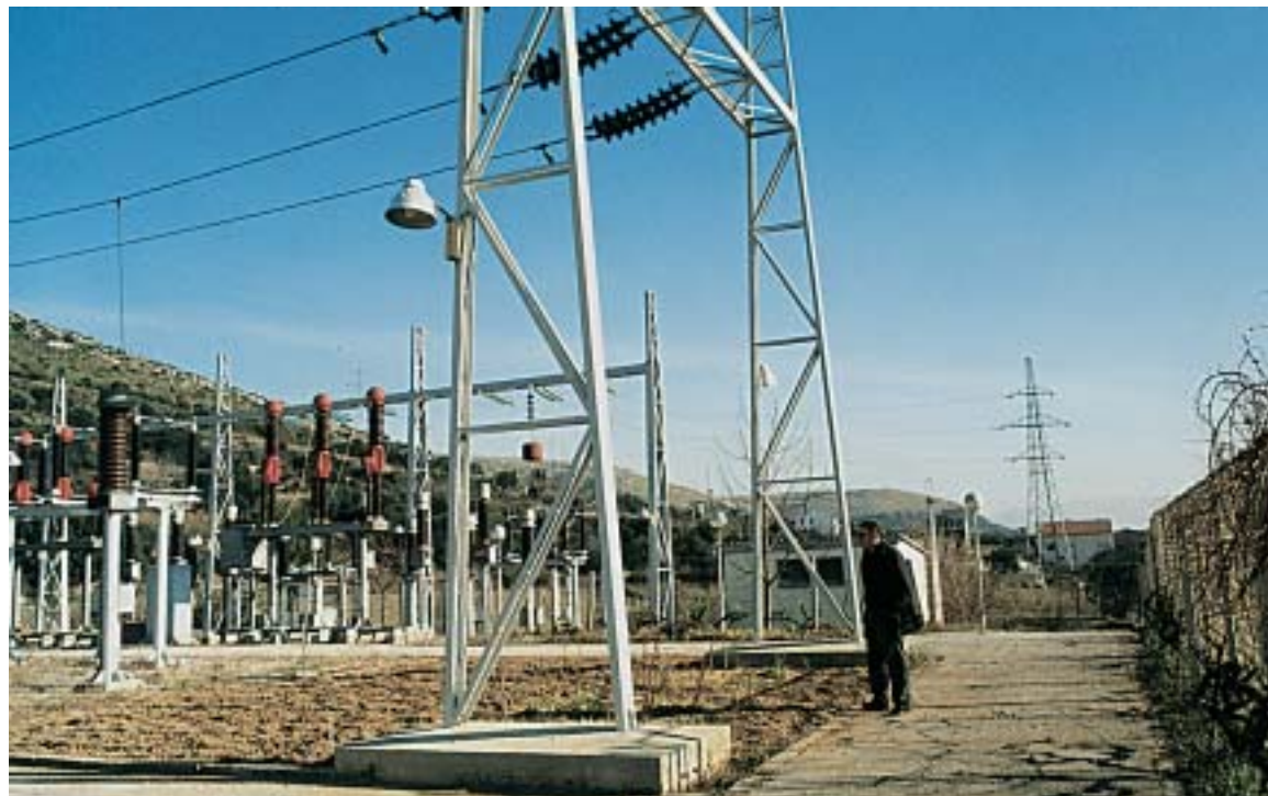
Stipe Guć, rukovoditelj Odjela održavanja razmišlja, na licu mjesta, o probijanju južnog ulaza u objekt
