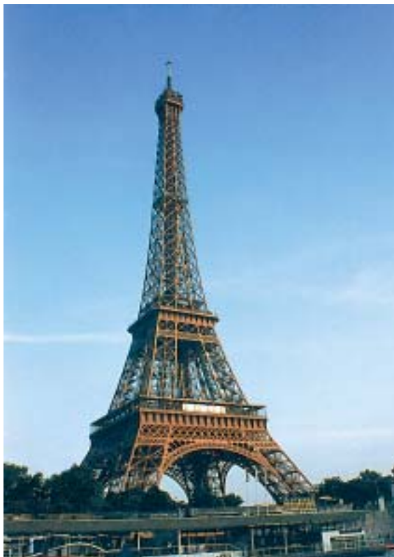
Eiffelov toranj (pogled sa Seine) - podignut je za Svjetsku izložbu održanu 1889. godine prema projektu inženjera Gustava Eiffela. Ova građevina je jedna od glavnih razloga posjeta Parizu što opravdavaju brojke od četiri milijuna posjetitelja godišnje. Ukupne visine od 320 metara spoj je petnaest tisuća metalnih komada zavarenih u cjelini. Toranj teži 7000 tona, a podijeljen je na tri kata. Osim jedinstvenog pogleda, na svakom se dijelu može zastati i odmoriti u restoranu ili baru. Spektakularno blistav noćni prizor Eiffelovog tornja omogućen je uz osvjetljenje od 292 000 wata
