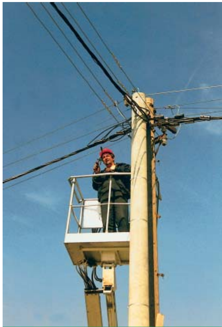
Elektromonter Damir Odrljen pri zamjeni golih vodiča novim SKS-om u Trilju
