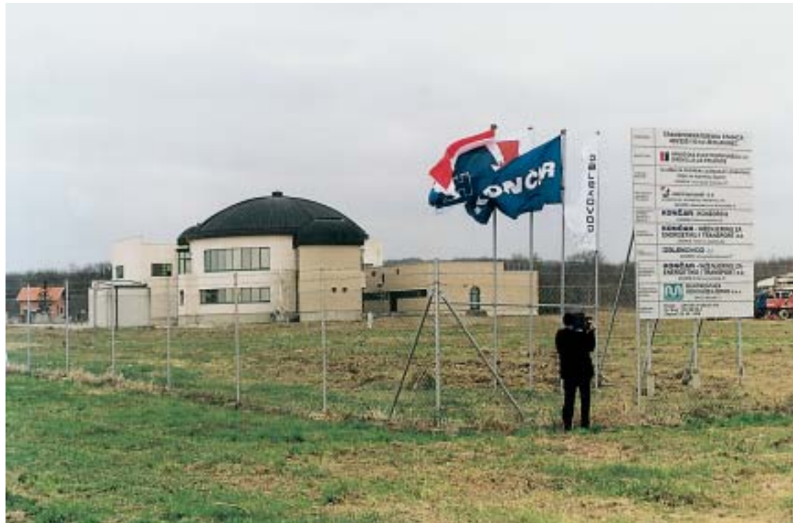
Građevina dijela dispečerskog centra TS Žerjavinec, čija je izgradnja započela 1989. i trajala do 1991. godine, kada su radovi obustavljeni zbog nedostatka financijskih sredstava i rata, sve do ovih dana - 13 godina - čeka svoj sadržaj
