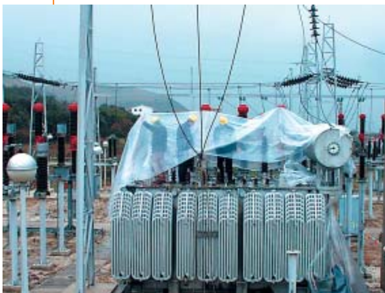
Pada kiša, a raditi se mora?! Ne može se čekati da se nebo zaplavi, nego se treba snaći ovako kako su se snašli u TS 110/35 kV Trogir
