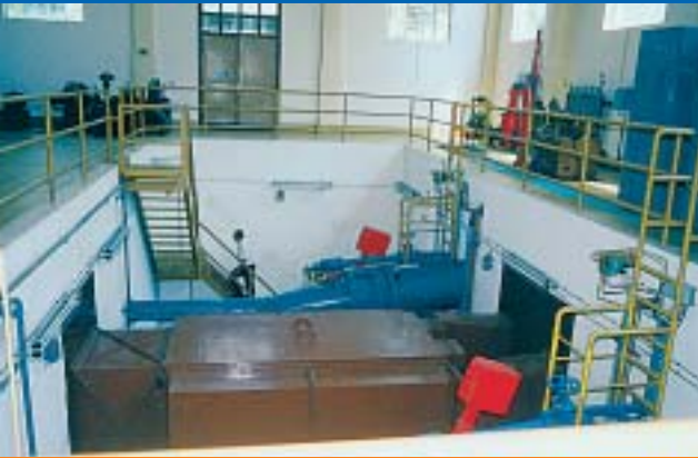
Na mjesto starog četvrtog agregata došao je 1990. g. novi ABM, snage 5 MW
