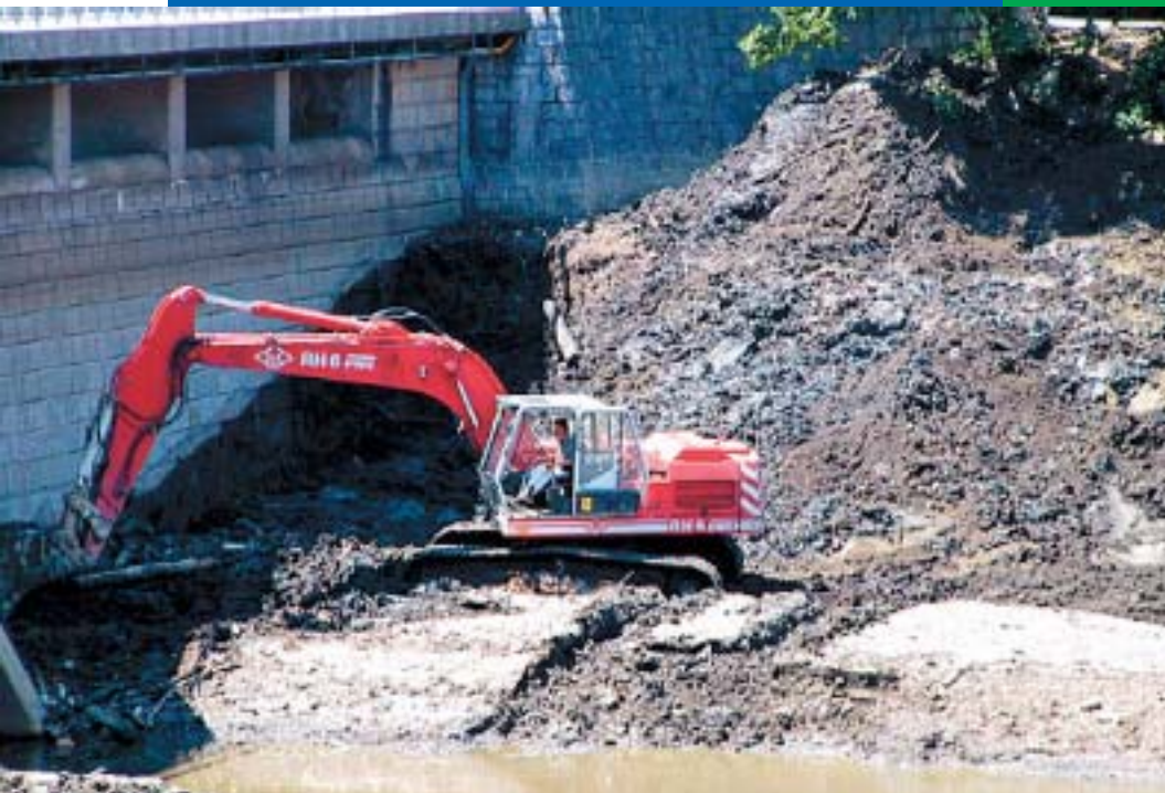
Čim je kroz otvore brane ispuštena voda, mehanizacija je spuštena na dno jezera i započeli su građevinski radovi
