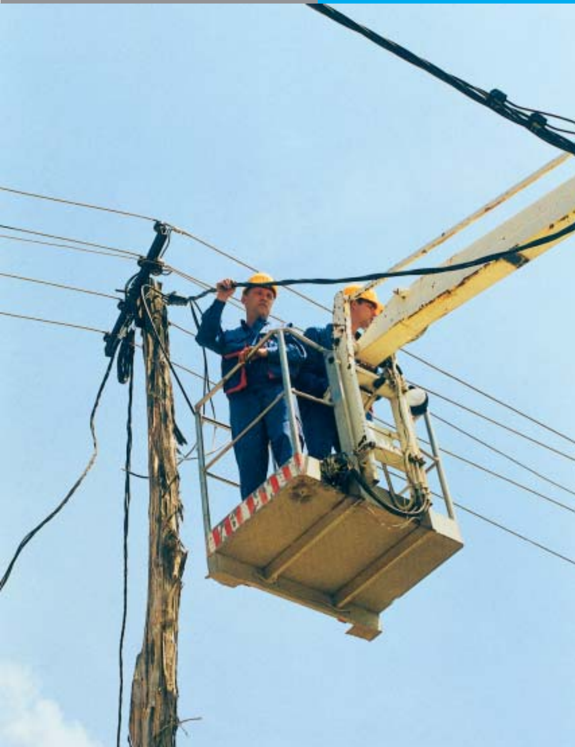
Josip Gregorec, majstor i Igor Babić, monter, upravo su napravili by-pass, kako bi mogli prebacivati potrošače sa stare na novu mrežu
