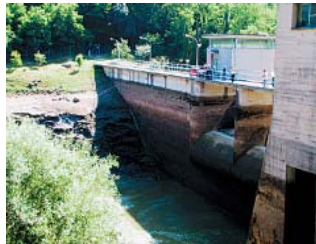
Brana koja omogućuje punjenje i pražnjenje akumulacije Valići
