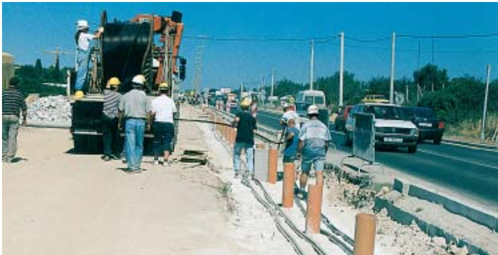
Kabel se odmah polaže po zacrtanoj trasi
