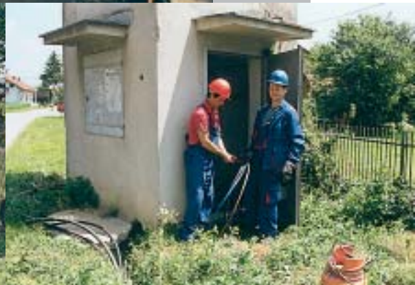
Majstor Božo Odribožić i monter Srećko Barlović na rekonstrukciji trafostanice u naselju Budaševo
