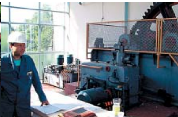
Predradnik Ignjac Vrbić kontrolira reduktor i prigon prelivnih zapornica u prostoriji iz koje se upravlja temeljnim ispuštima
