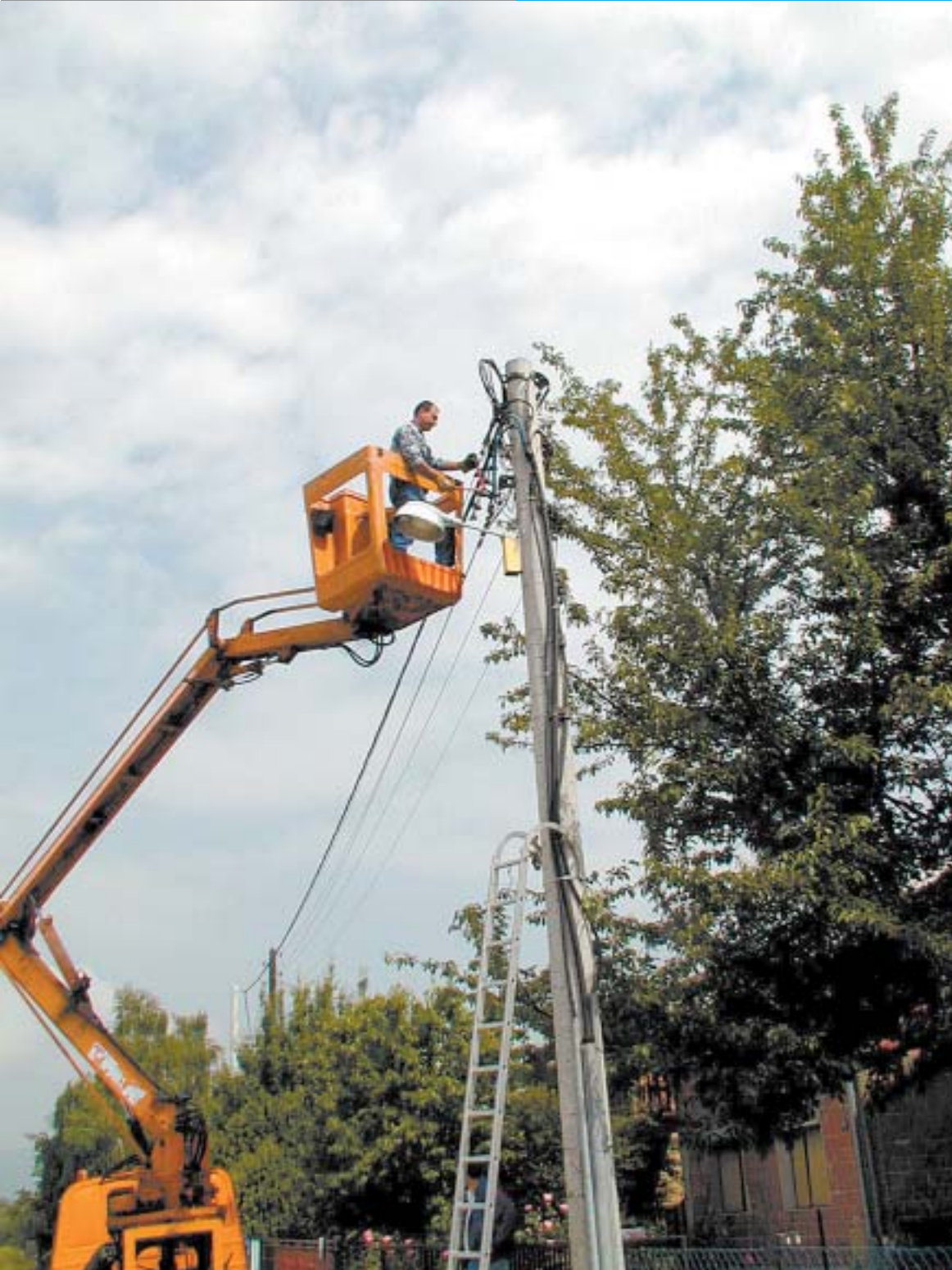
Na izmjeni dotrajalih stupova i kableske zračne mreže okom kamere uhvatili smo VKV montera Željka Jakopovića, dok su KV monter i Ivan Raos i Marijan Pavičić asistirali na zemlji
