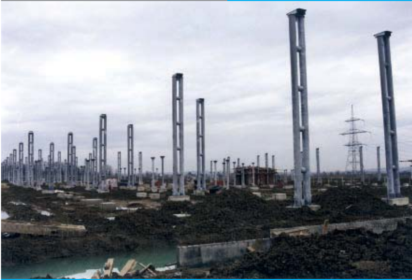
Montirana je čelična konstrukcija 400 kV sabirničkih sustava GS 1 i GS 2, kao i ...
