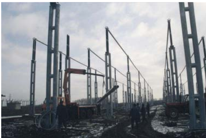
Unatoč niskim temperaturama, montaža glavnih sabirnica u RP 400 kV odvija se bez zastoja
