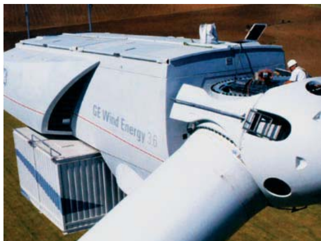
Slika 4.: Priprema montažu treće lopatice rotora GE Windove 3,6 MW turbine
