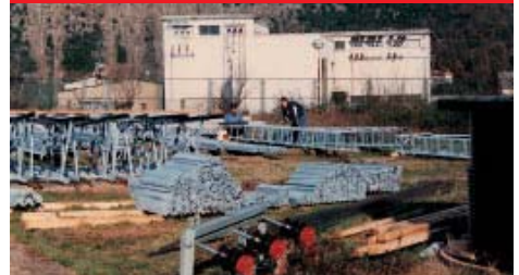
Radnici zagrebačkog Dalekovoda sklappaju čelične konstrukcije stupova za DV u Runovićima
