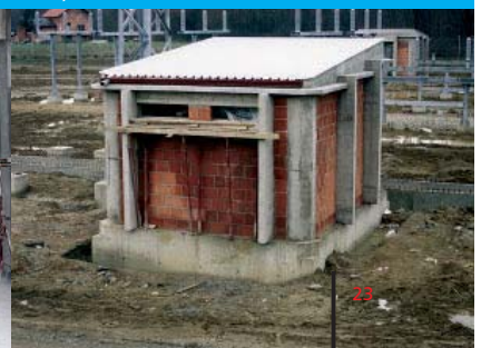
Relejna kućica pokrivena je profiliranim aluminijским limom
