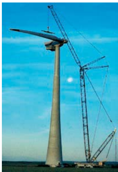
Slika 3.: Montaža prototipa prve 3,6 MW vjetroturbine Barrix-Španjolska
