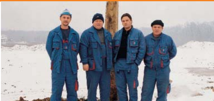
Monteri Zoran Maleković, Dražen Ružić, Saša Krivačić i Vlado Porodec postavili su upravo tri privremena stupa za gradilište novog zaprešićkog stambenog naselja Novi Dvori i privremenu javnu rasvjetu
