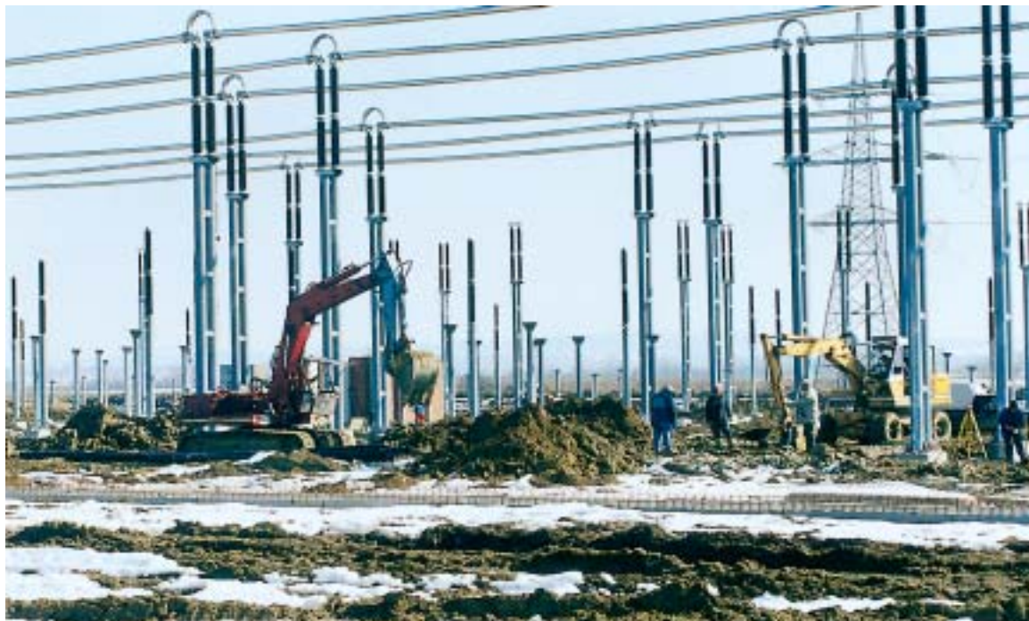
Montirane su sabirnice GS 1 i GS 2 u postrojenju 400 kV, a ovdje su u tijeku radovi na kanalizaciji
