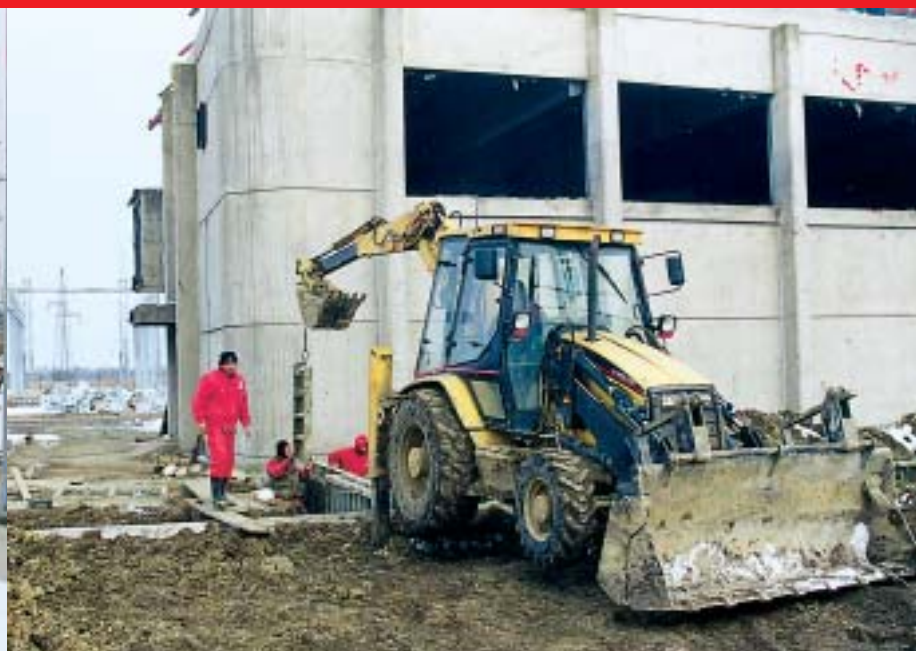
Betoniranje kabelskih kanala
