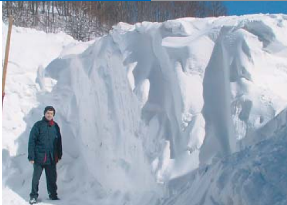
U Begovu Razdolju djeca se sanjkaju po brijegu ne sluteći da prelaze i preko krova trafostanice. Ispod naslaga snijega na ovoj slici - vjerovali ili ne - je trafostanica, koju će radnici Pogona Skrad uskoro otkopati
