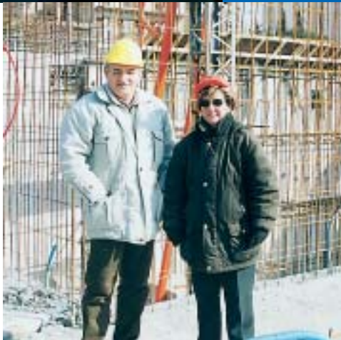
Karlo Malik, nadzorni inženjer za elektroradove i Željka Sunka, voditelj izgradnje iz Konstruktora Rijeka, pri obilasku gradilišta
