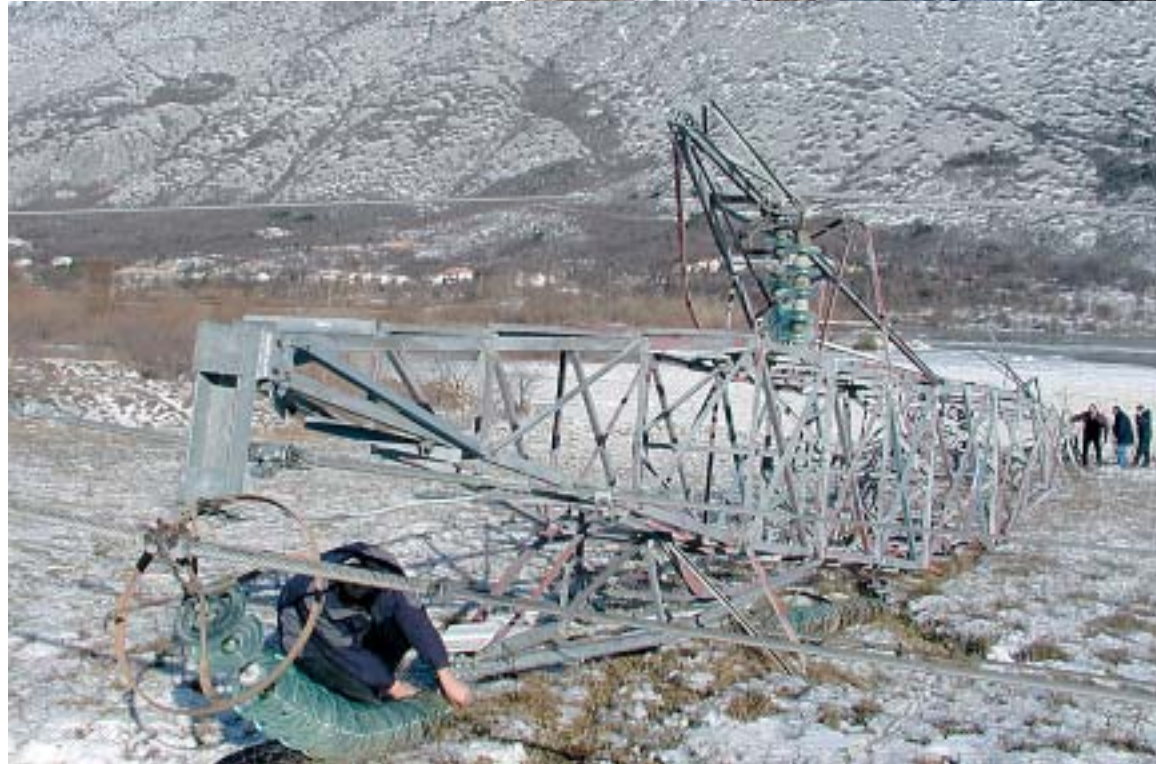
Interventna ekipa Odsjeka za održavanje dalekovoda PrP Opatija pregledava oštećene dalekovodne stupove pokraj Triblja te mjeri naslage leda na vodičima
