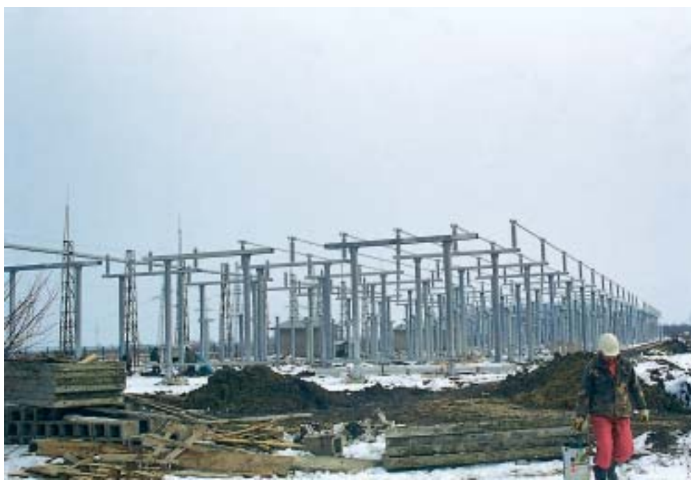
Postavljanje aluminijskih cijevi za sabirnice 110 kV postrojenja je pri završetku
