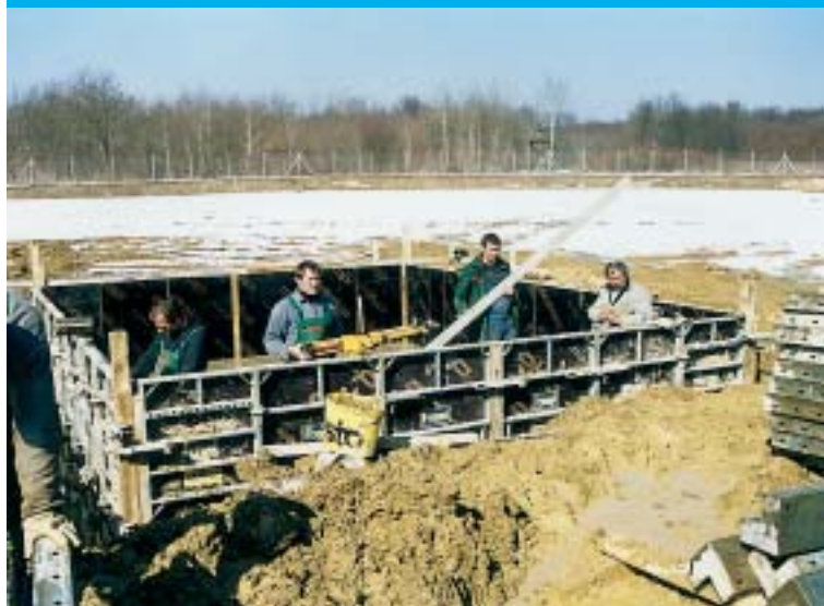
U tijeku je izrada oplata za drugi temelj relejne kućice u 220 kV postrojenju
