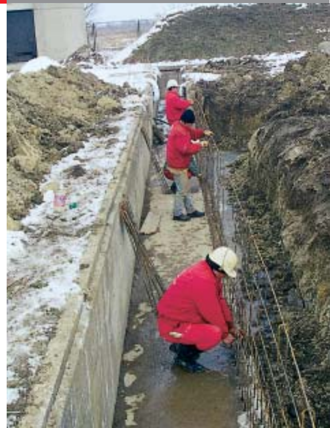
Armiranje dijela kabelskog kanala koji se sanira
