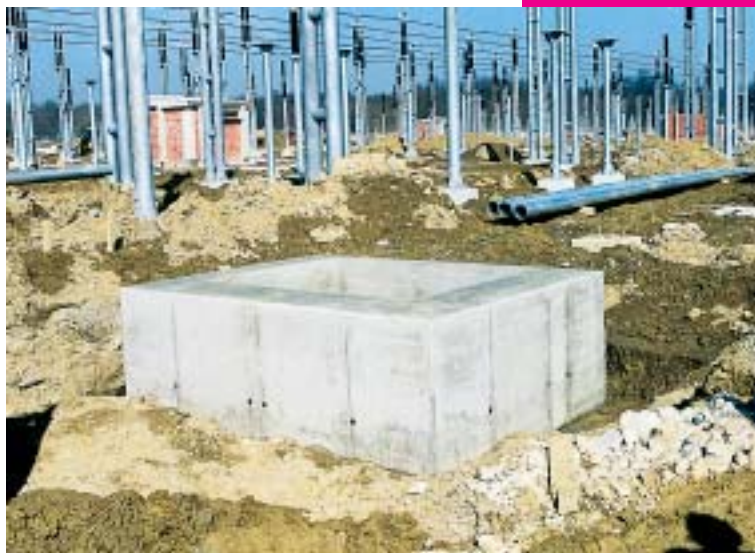
U postrojenju 400 kV izbetonirano je svih osam temelja portala
