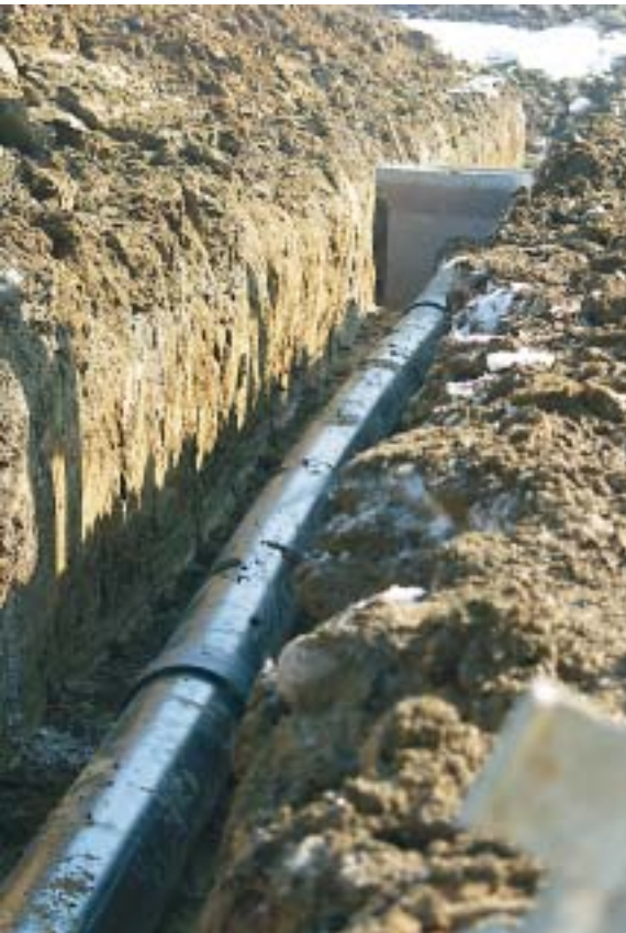
Jedan od do sada 23 montirana okna oborinske kanalizacije s montiranim cjevima
