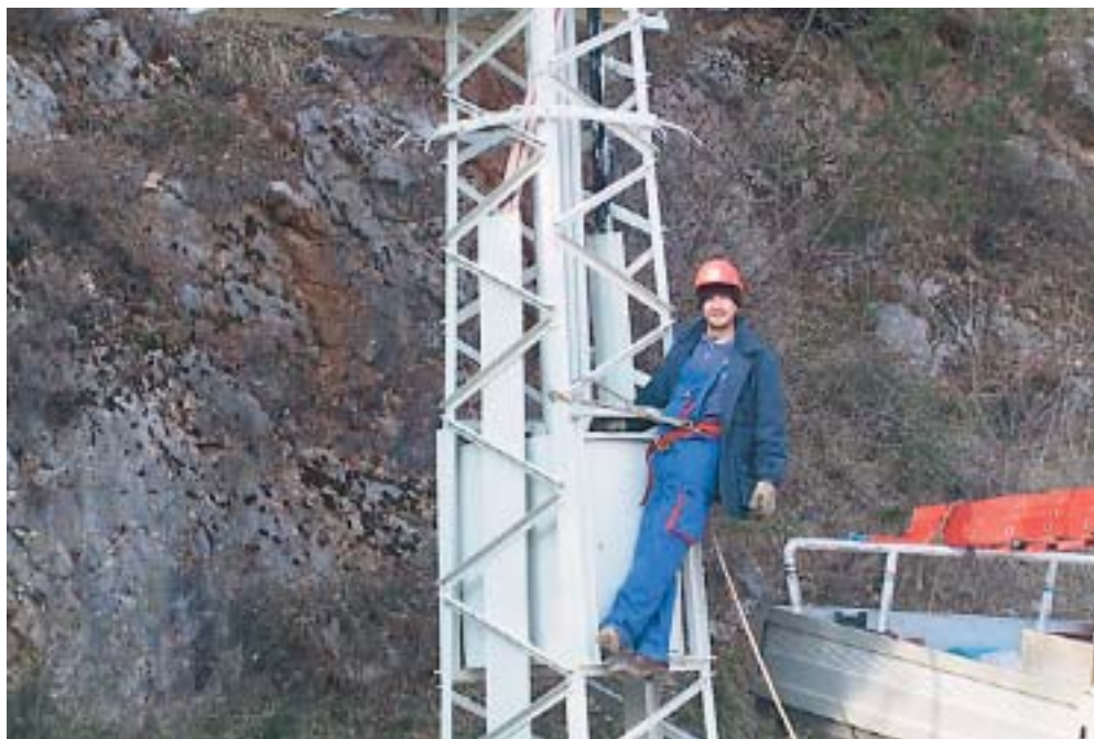
Monter na stupnoj trafostanici
