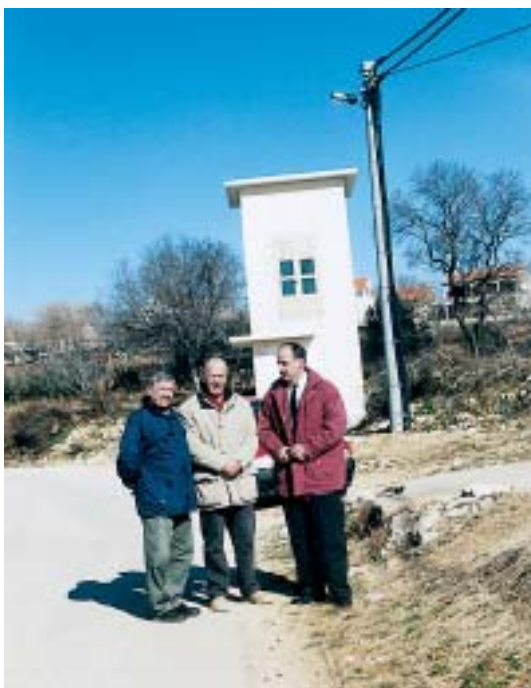
Ispred nove trafostanice i mreže u Rašteviću zatekli smo Miroslava Jurića, Anđelka Rogića i Nedjeljka Torbarinu
