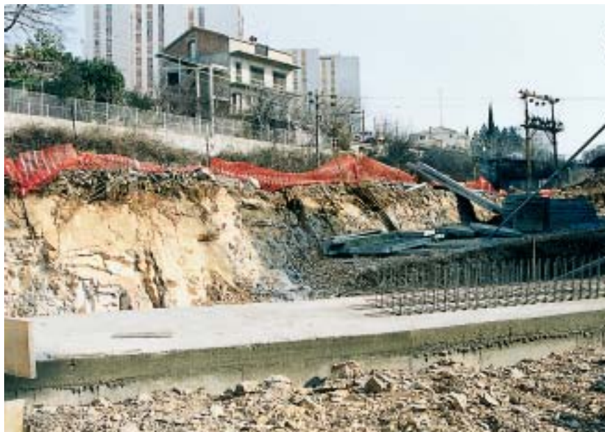
Kabelski tunel za 110 kV kabel odmah je ispod željezničke pruge Rijeka - Zagreb
