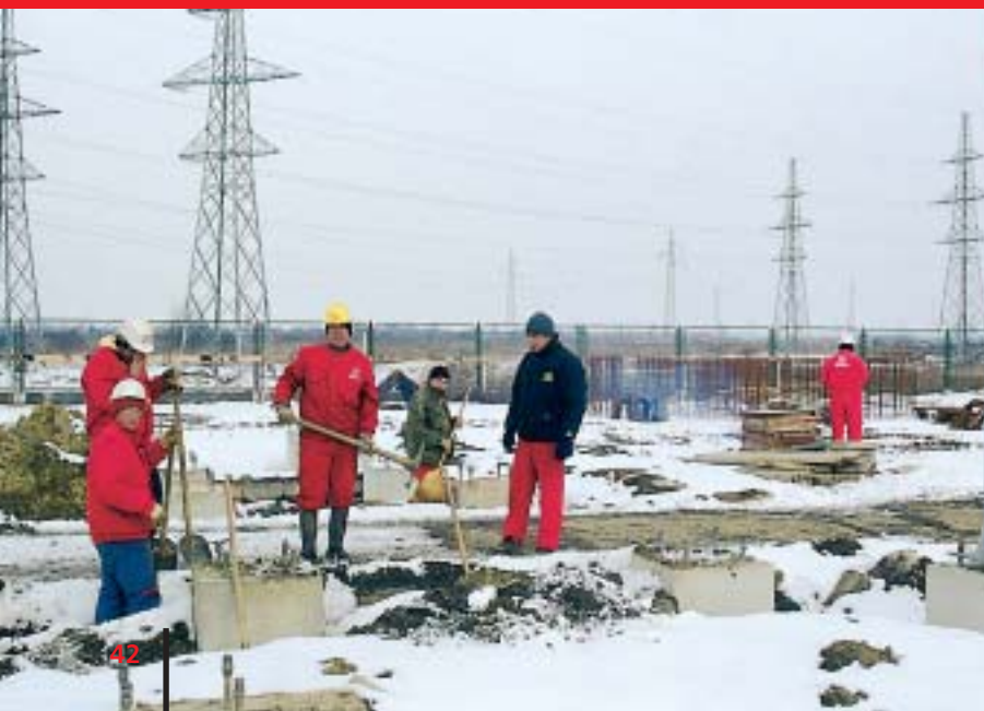
Ugradnja sidrišta u betonske temelje pri studeni lakša je uz vatru
