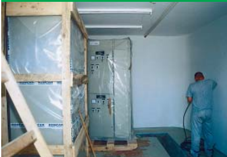
Započela montaža opreme u relejnim kućicama
