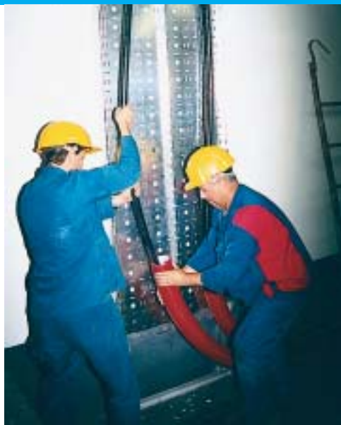
Stjepan Sinković i Marijan Kapusta uvlače dva snopa srednjenaponskih kabela
