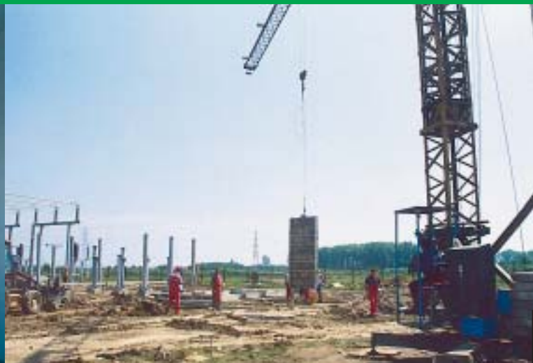
Betonira se temelj prigušnice 110 kV, 100 Mvar
