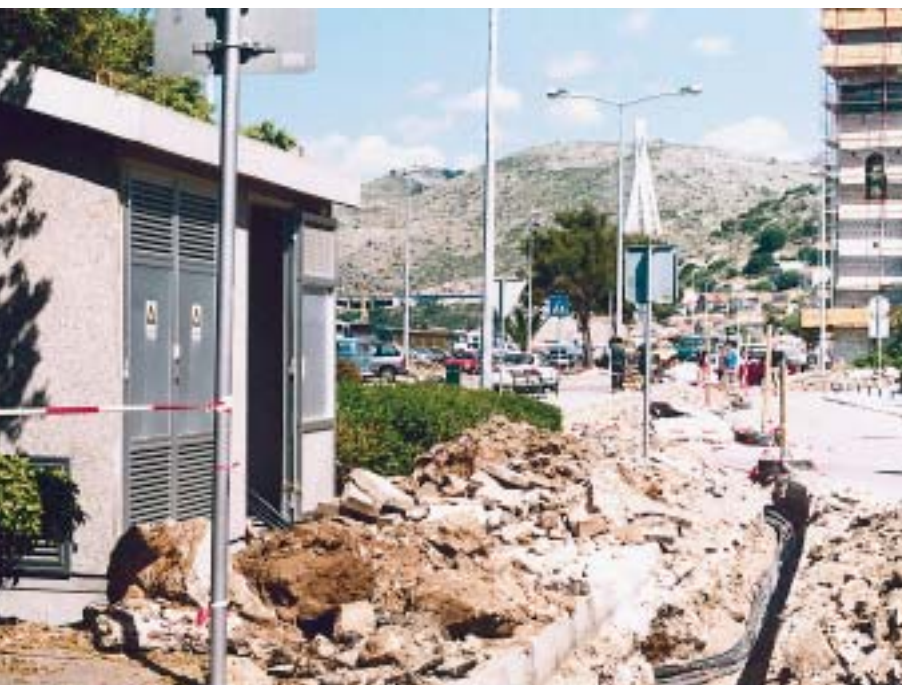
Duž gruške rive, dubrovački su elektraši položili 10(20) kV kabel i izgradili novu trafostanicu za potrebe misnog slavlja
