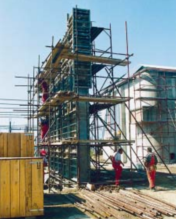
Betoniranje vatroobrambenog zida ispred mjesta energetskog transformatora
