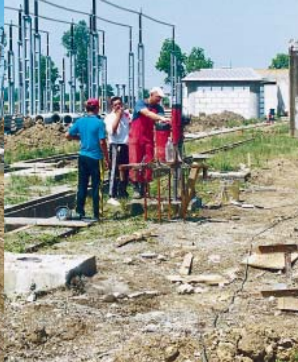
Priprema preostalih postojećih temelja još je u tijeku
