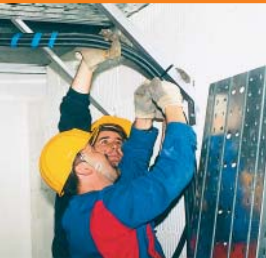
Polaganje kabela po kabelskoj polici (veza transformator-niskonaponski razvod)
