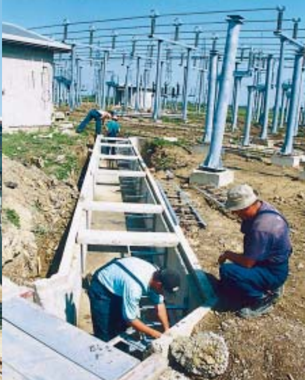
Ugradnja polica u kablске kanale
