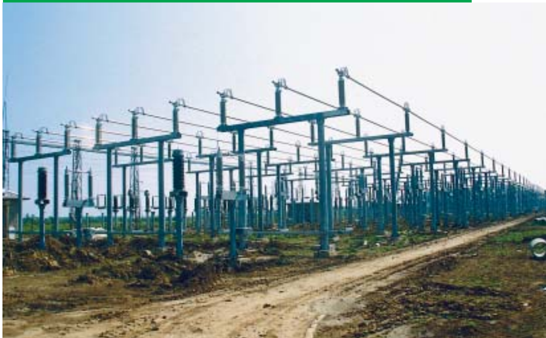
Postrojenje 110 kV je pri dovršetku
