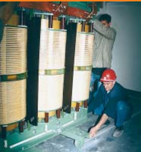
Smještaj transformatora na šine, koje su radi rasterećenja produljene na tri metra
