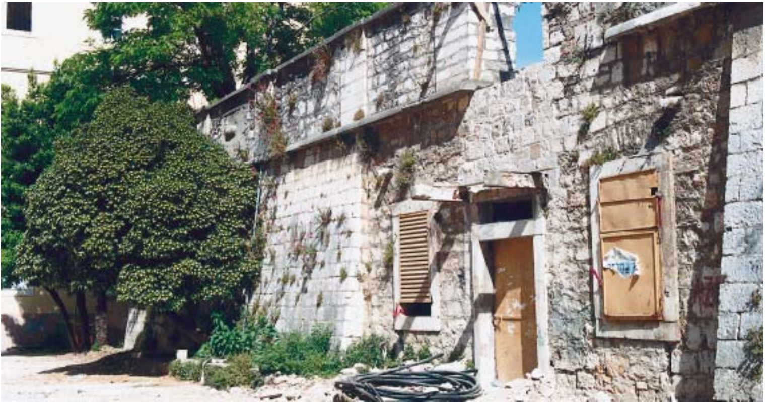
Uskoro, nadamo se, unutar bedema (iza ovih vrata) bit će smještena TS Grad 18
