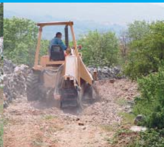
Još malo i voda će stići uzbrdo do gradilišta
