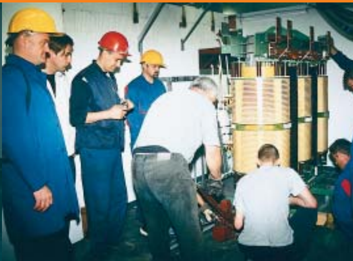
Transformator je napokon na svom mjestu, gdje se postavljaju i antivibracijske podloge
