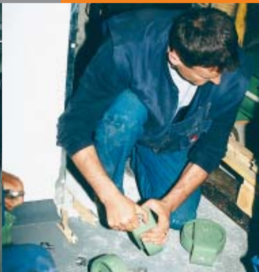
Pripreme za montažu kotača na transformator
