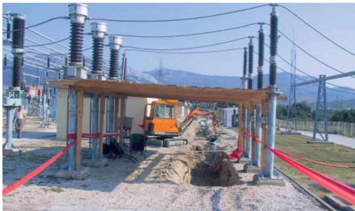
TS Vrboran - proširenje četiri nova polja 110 kV nužnih za priključak kabela 110 kV iz Programa Split
