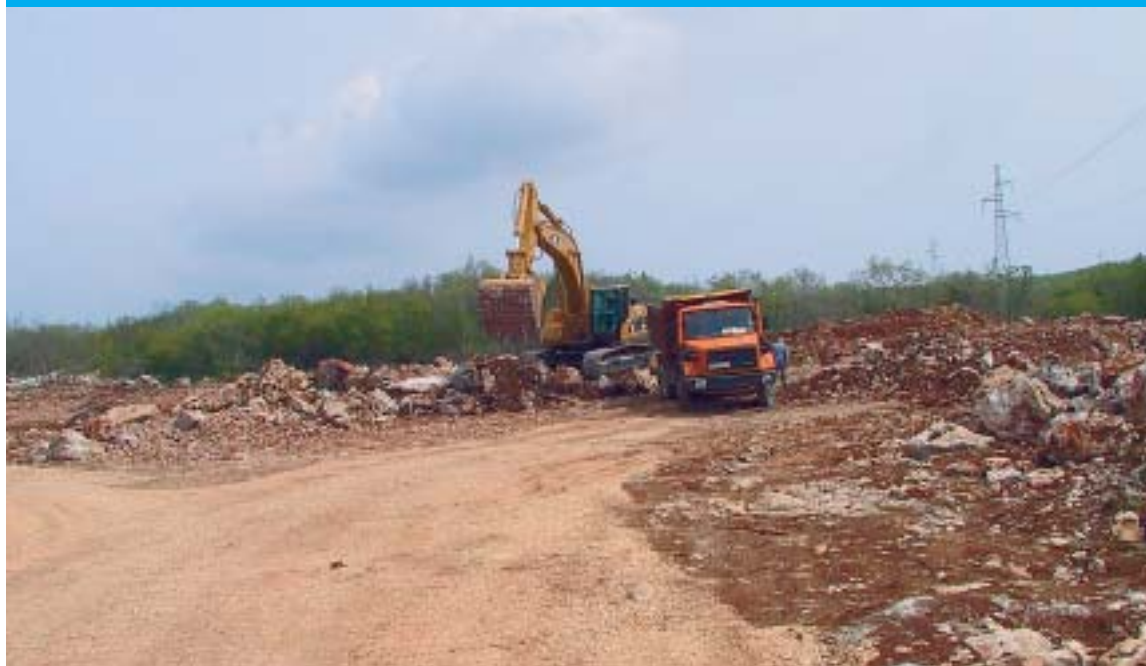
Moćni građevinski strojevi bez poteškoća drobe tvrdi krčki kamen
