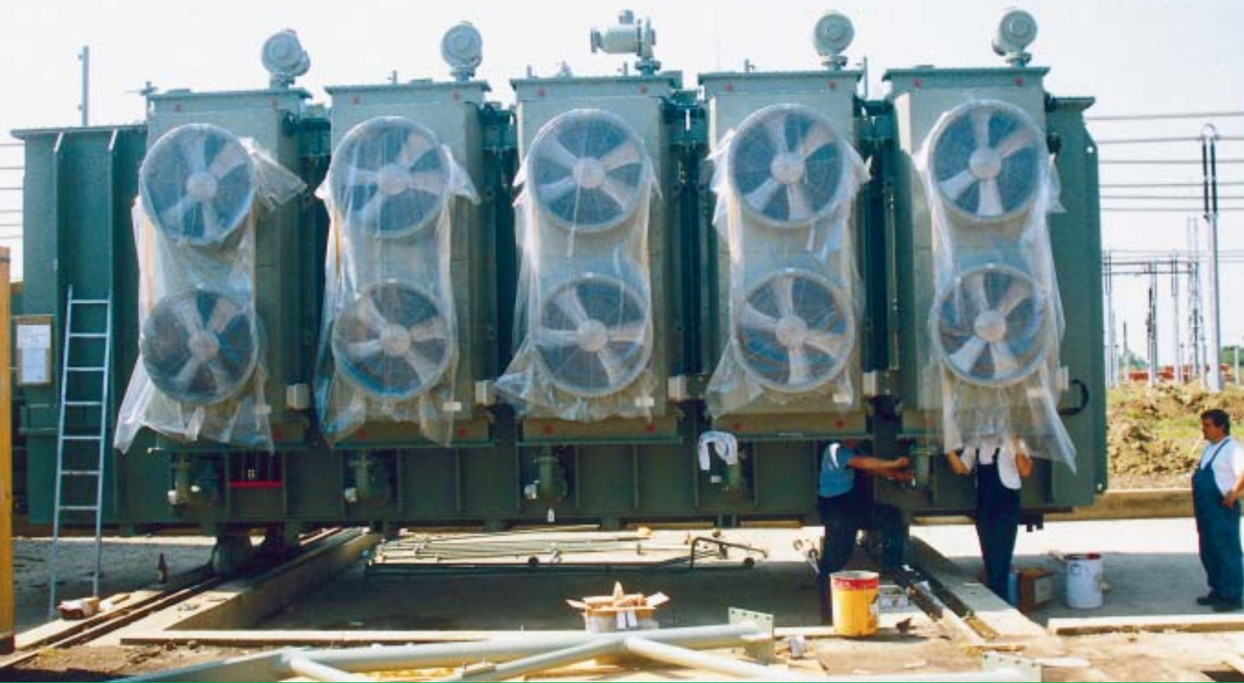
Montira se oprema na energetske transformatore
