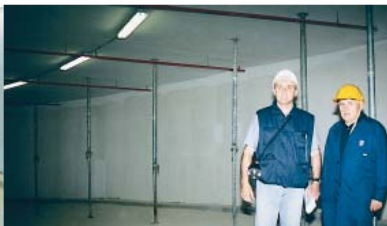
Marijan Koščak, nadzorni inženjer građevinskih radova i Franc Brezovec, stručni predstavnik investitora, na trasi prolaska viličara s transformatorom, koja je cijela poduprta zbog prolaska ovog iznimno teškog tereta
