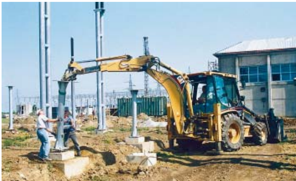
Postavljanje portala za prihvat zemljospojnika
