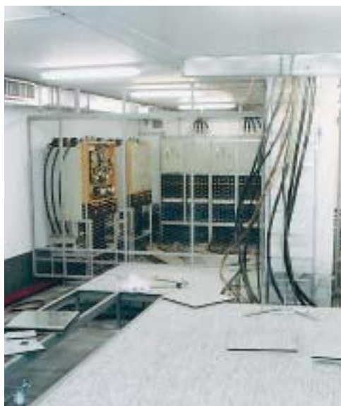
I na kraju polaganje završne podloge, ispod koje se nalaze cjelokupne kablanske instalacije
