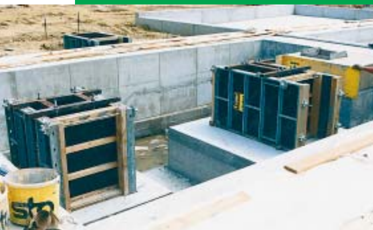
Temelji potpornih izolatora i mjernih transformatora u temeljima transformatora TR 4
