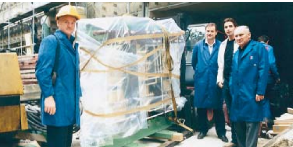
Jedan od transformatora (težak 3,5 tone) spreman je za uvoženje u objekt pod budnim okom elektraša (Glavaš, Modrič, Koščak i Čović)
