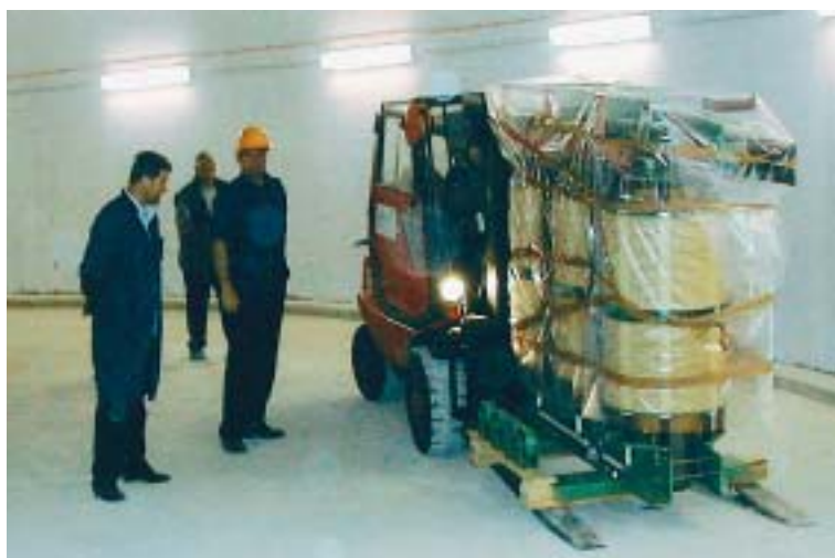
Spuštanje viličara s transformatorom
