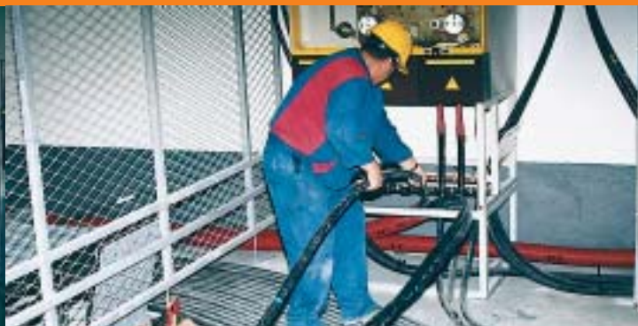
U prostoriji gdje su smješteni srednjenaponski i niskonaponski razvodi trafostaničari spajaju veze između transformatora i niskonaponskog razvoda
