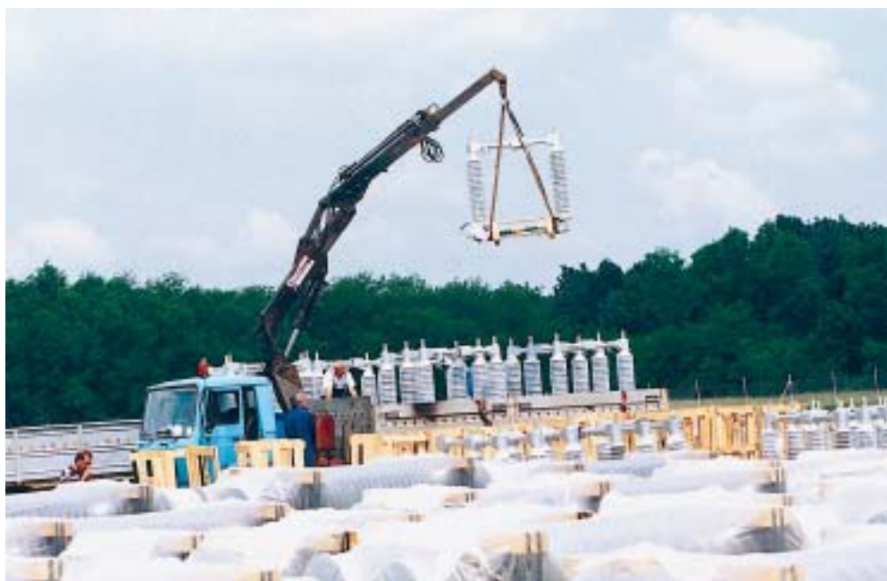
Istovar izlaznih rastavljača 123 kV
