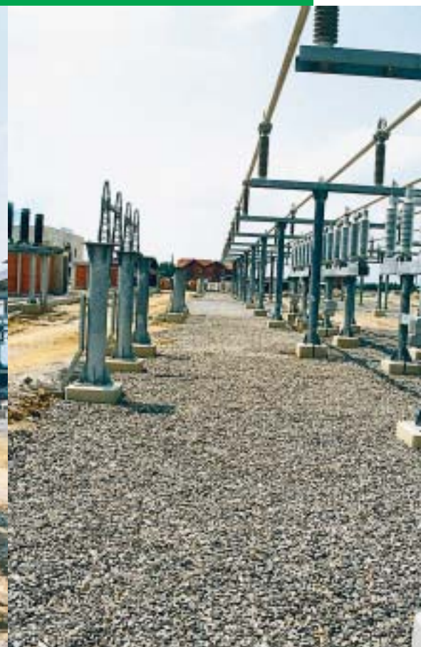
Započela je završna obrada platoa nasipavanjem prvog od dva sloja tucanika
