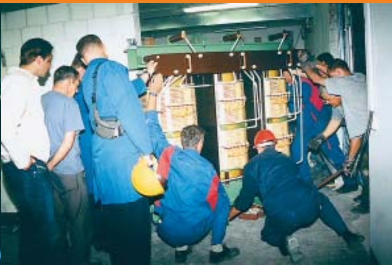
Unošenje transformatora kroz vrata postrojenja bio je posebno težak zadatak
