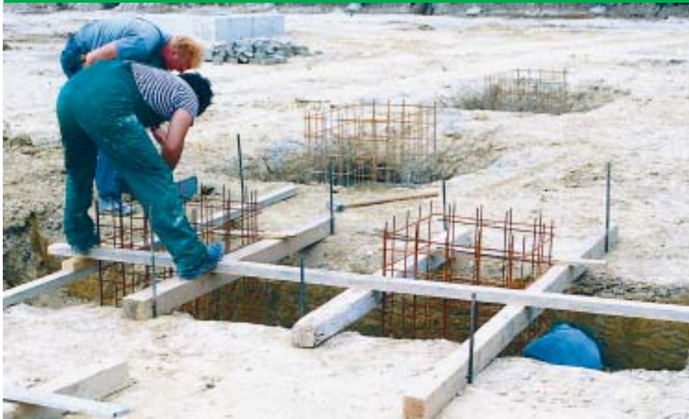
Izrada temelja aparata u RP 220 kV
