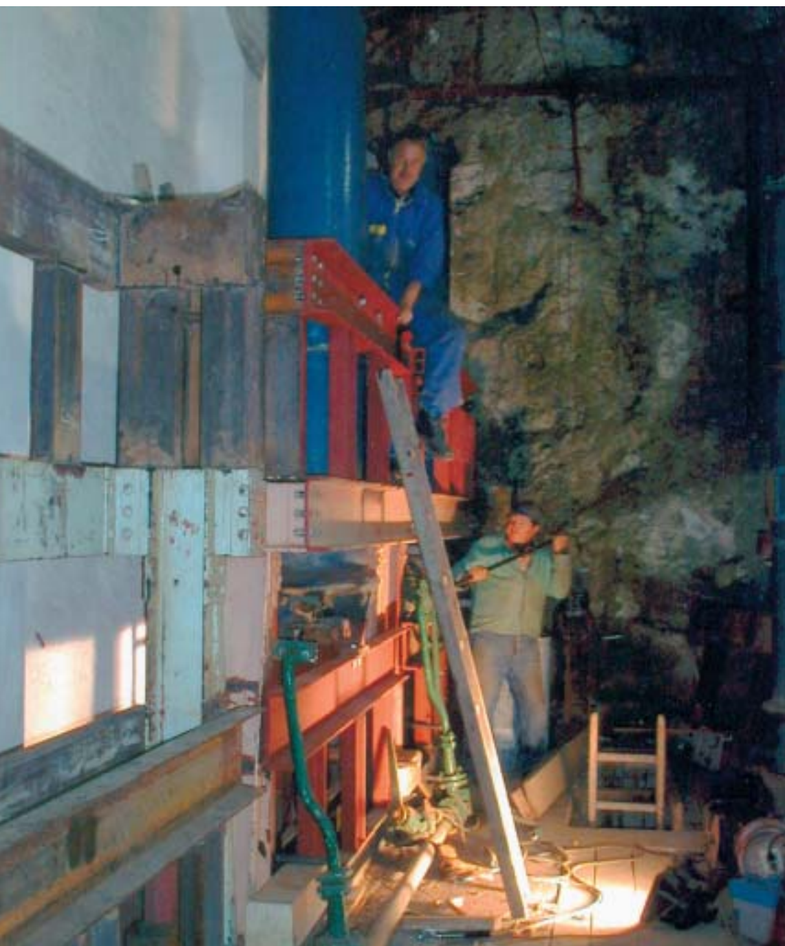
Radovi na tablastim zatvaračima ulazne građevine
