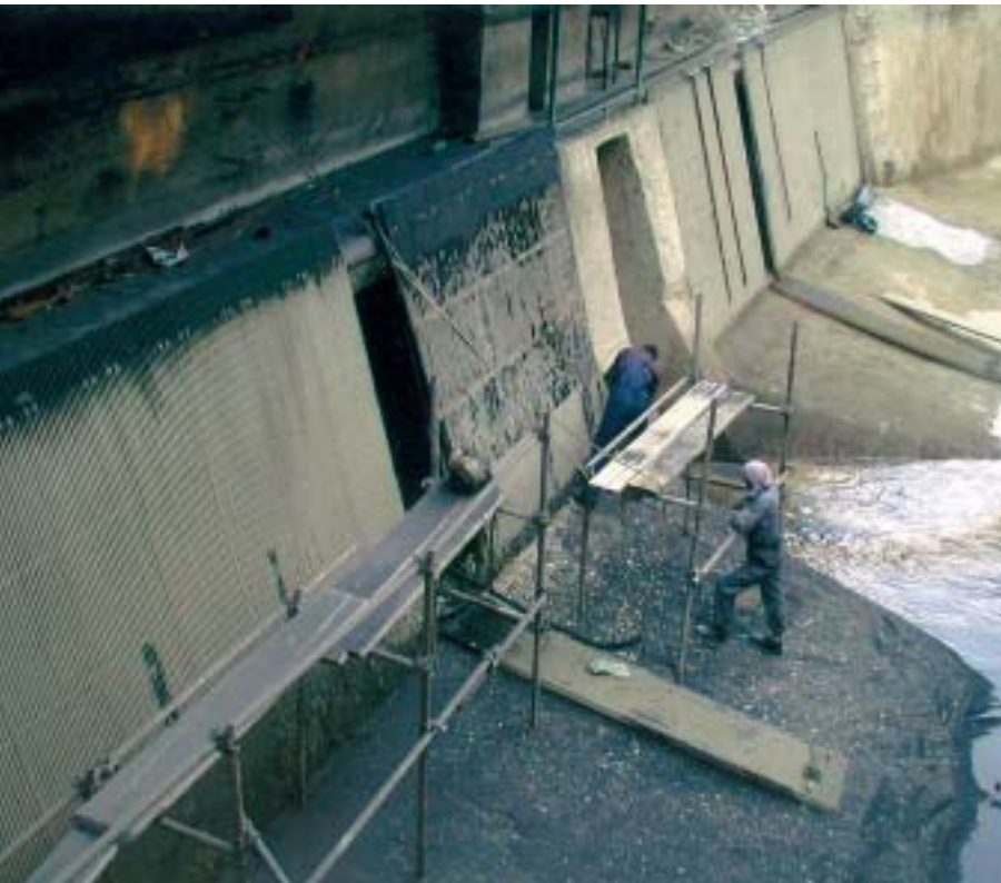
Pjeskarenje fine rešetke na vodnoj komori
