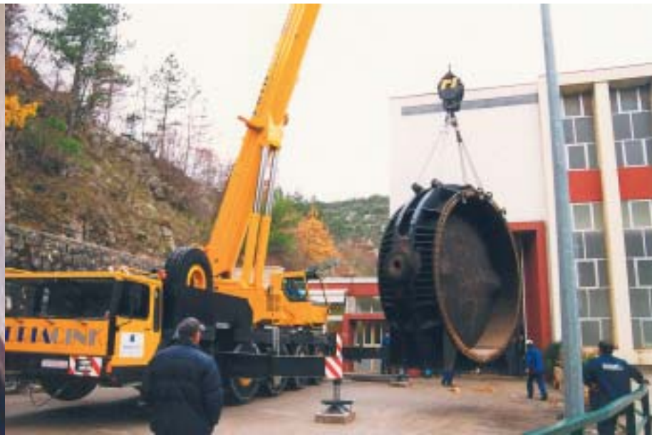
...i otpremanje predturbinskog zatvarača
