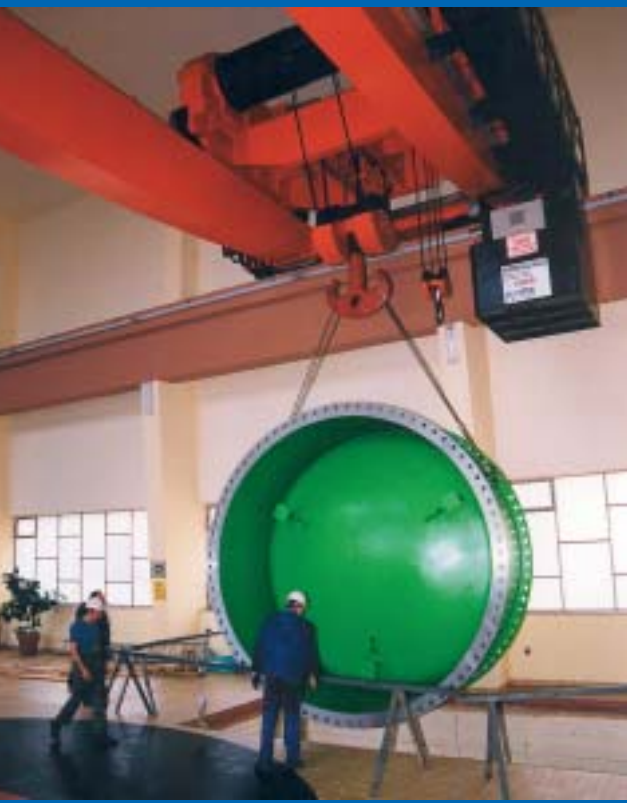
Stiže i montira se tzv. slijepa prirubnica koja će zamijeniti predturbinski zatvarač dok je na obnovi i omogućiti nesmetani rad drugog agregata
