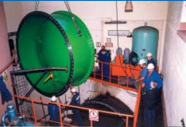
Stiže i montira se tzv. slijepa prirubnica koja će zamijeniti predturbinski zatvarač dok je na obnovi i omogućiti nesmetani rad drugog agregata
