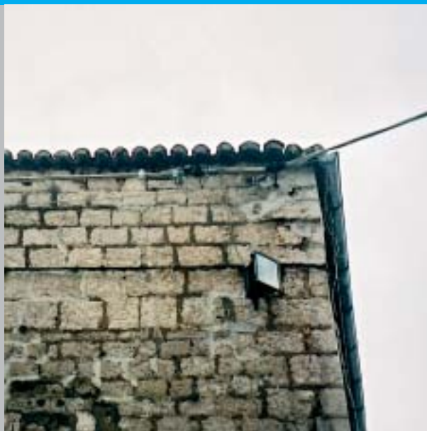
Detalj osorske fasade s dva pristupa
