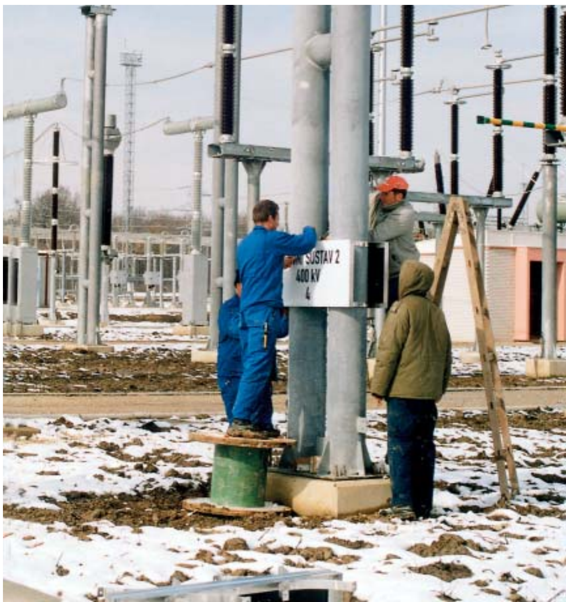
U tijeku je postavljanje oznaka sabirničkih sustava u RP 400 kV
