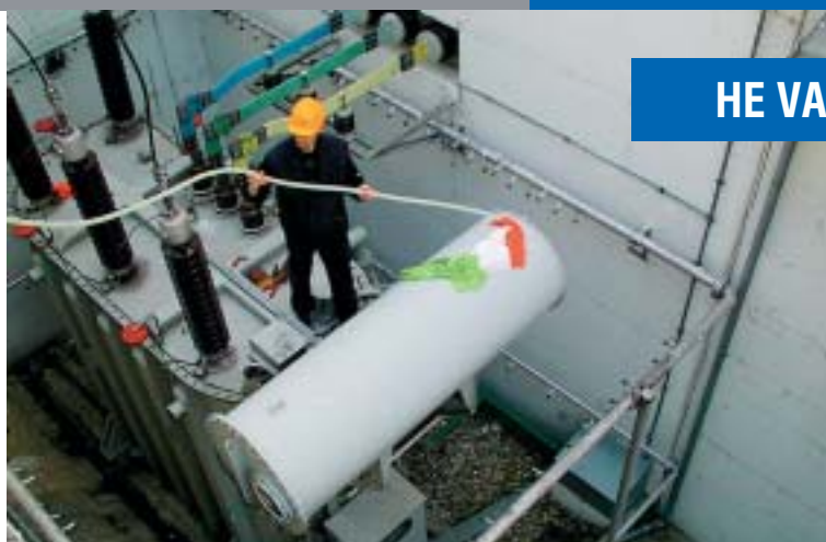
Radovi na blok transformatoru
