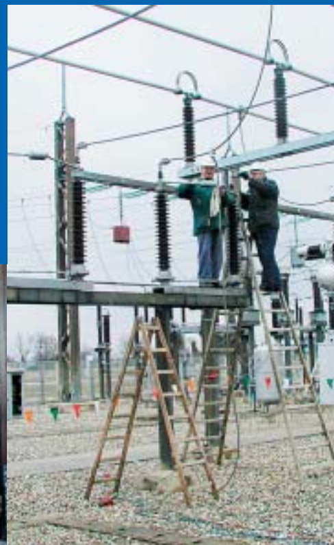
Revizija pogona generatorskih rastavljača 110 kV
