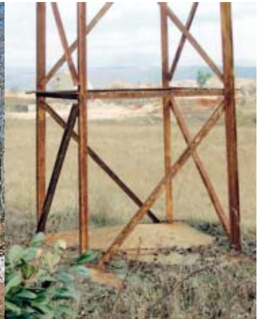
"Zubom" vremena nagrižena čelična konstrukcija stupova
