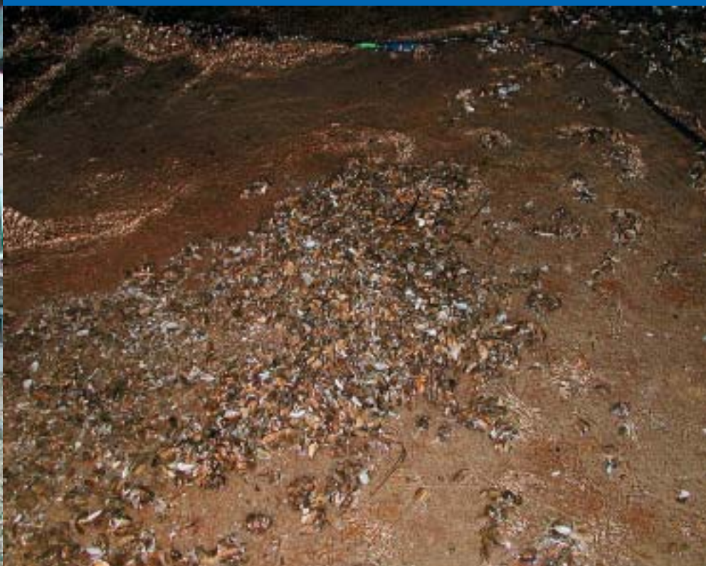
Školjke nagomilane u grozdovima onemogućavaju spuštanje zatvarača, a množe se progresivno
