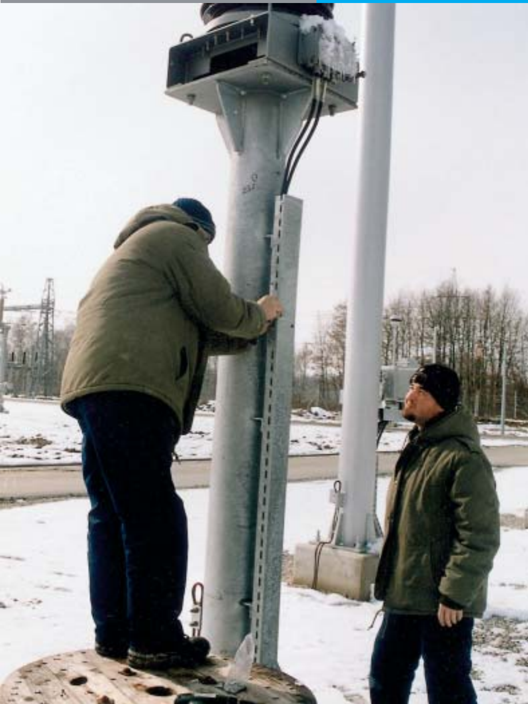
Učvršćuju se poklopci na metalnim policama signalnih kabela u RP 220 kV
