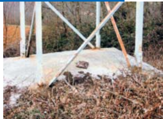
"Zubom" vremena nagrižena čelična konstrukcija stupova
