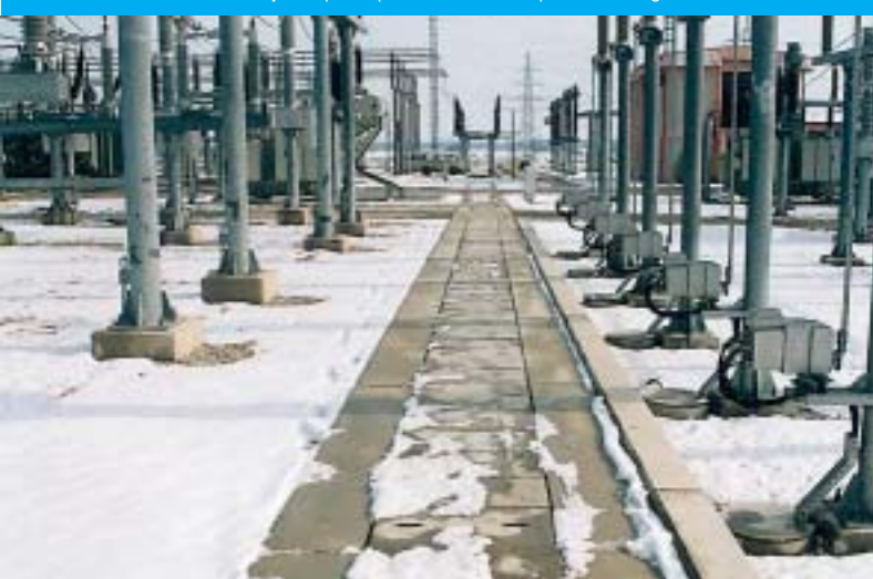
Učvršćuju se poklopci na metalnim policama signalnih kabela u RP 220 kV
