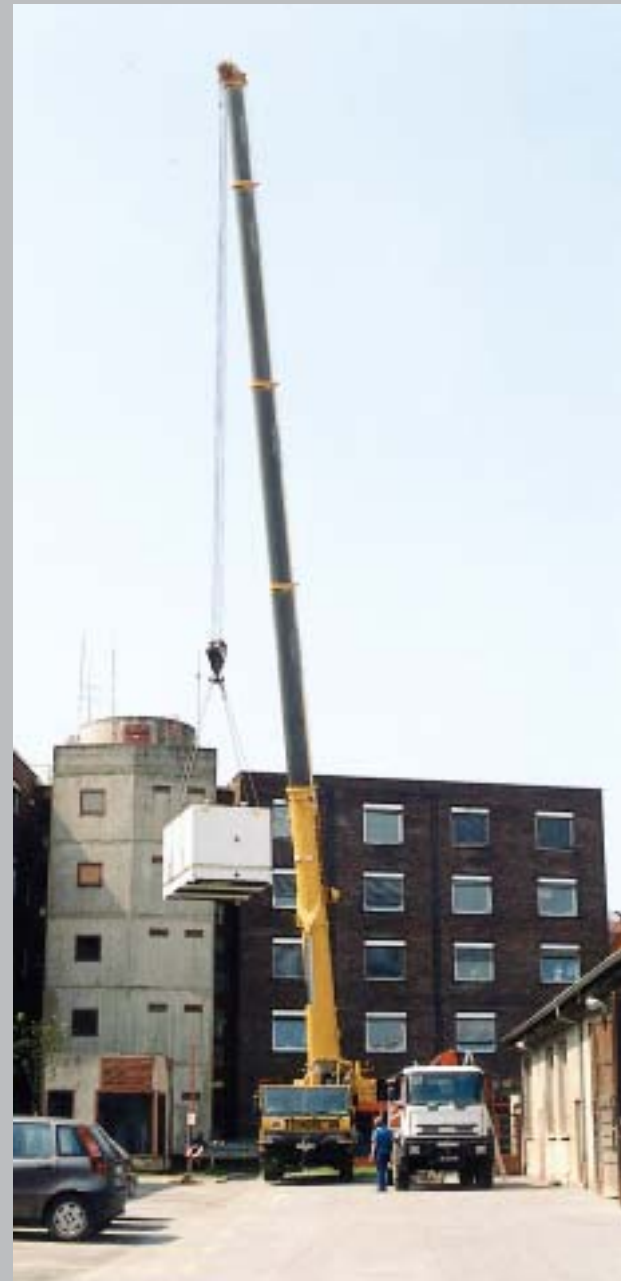
Kompresor se polako penje na vrh poslovne zgrade Elektre Varaždin
