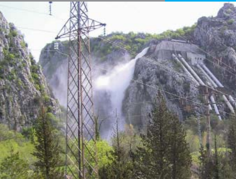
Preljev vode iz bazena na HE Krajevac
