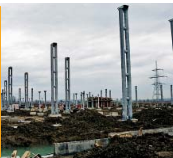
Montaža glavnih sabirnica u rasklopnom postrojenju 400 kV
