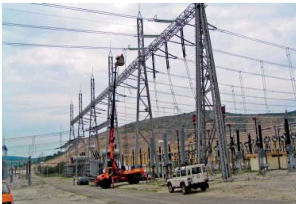
Radovi u TS 400/220/110 kV Konjsko
