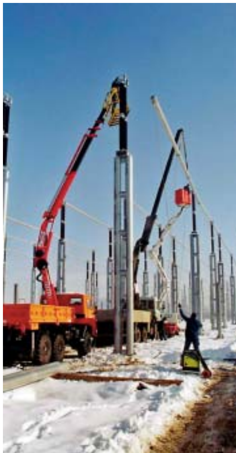
Montaža sabirnica 400 kV
