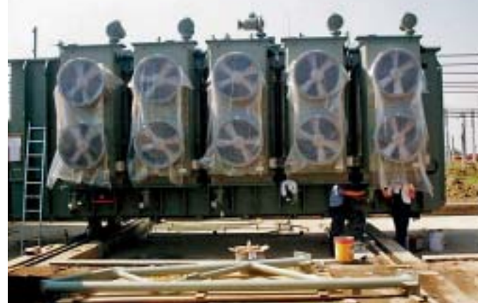
Montaža energetskog transformatora 400/110 kV, 300 MVA
