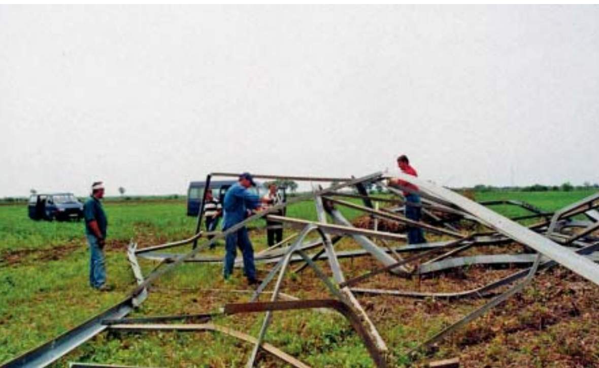
Uklanjanje čelične konstrukcije oštećenog stupa
