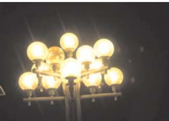
Primjer neodgovarajuće javne rasvjete: kod kugle više od polovice svjetla ide u nebo
