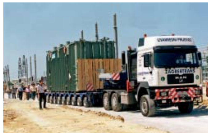
Dopremljeni su energetski transformatori
