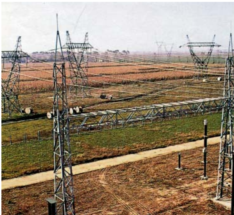
Priključak vodova 400 kV na TS Ernestinovo, 1976. godine
