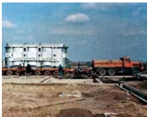
Transport transformatora 400/110 kV, u ožujku 1976. godine
