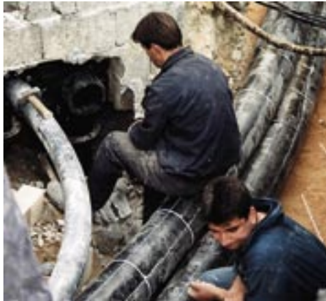
U Ulici kneza Višeslava: poštari, električari i vodoinstalateri u istom kanalu
