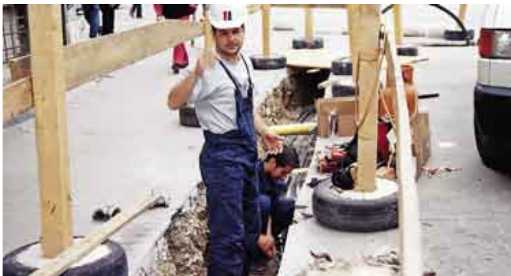
Robert Barić i Romeo Danolić će izraditi kableske spojnice
