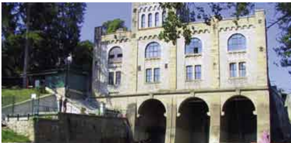
Među ostalim poslovima u HE Ozalj, izdava se sanacija zgrade strojarne Ozalj 1, jer se mora obavljati u suradnji s konzervatorima, budući da je zgrada zaštićeni spomenik kulturne
