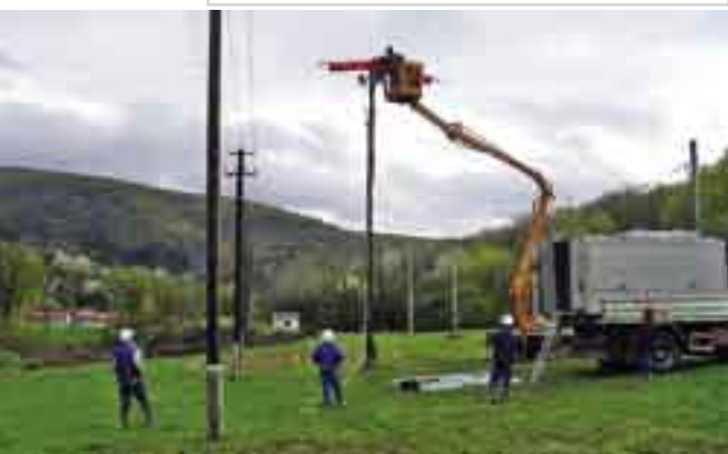
Kontinuirano nadgledanje radnih postupaka instruktora pri postavljanju nove vezne žice
