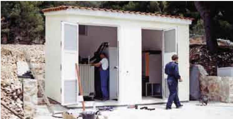
U novo TS Hvar 16 opremu ugrađuju meštri iz Službe za izgradnju : Siniša Brajnov, Emil Nikolić i Antonio Novaković
