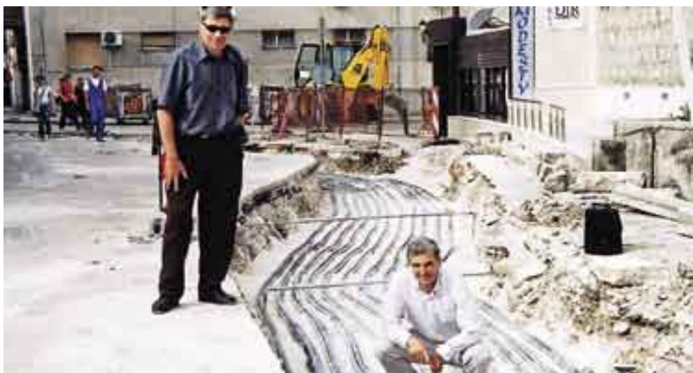
U trafostanicu ulazi 12 kableskih trojki iz zapadnog i južnog dijela grada - nadzorni inženjeri M. Ramljak i J. Tonković danonoćno su na radilištu
