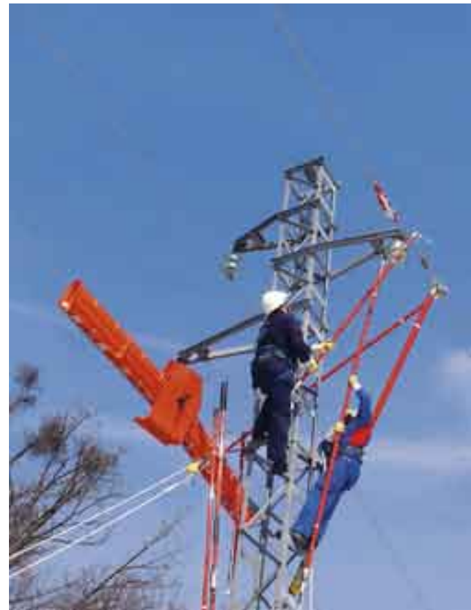
Izmjena ovjesnog izolatora na fazi broj 2 čelično-rešetkastog stupa uz upotrebu klizne triangulacije HEP-a, dinamometra (komparatora), izolacijskih prekrivki i provjeru stanja izolatora ogledalom
