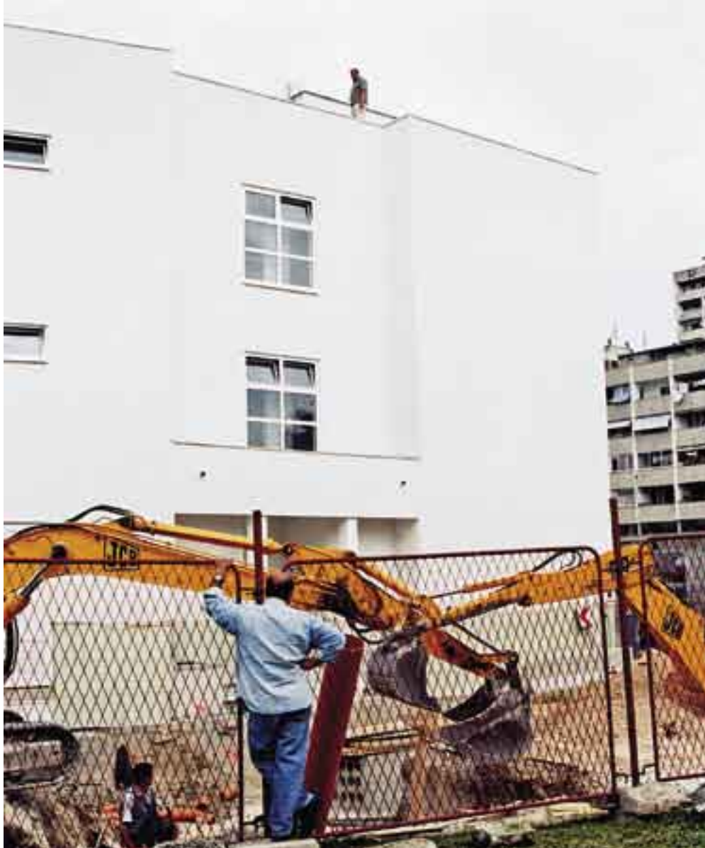
TS Dobri, radovi na krovu
