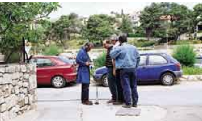
Živan, Vinko, Andro i Zoran prateći trasu osluškivanjem nastoje otkriti nepravilne kableske otkucaje
