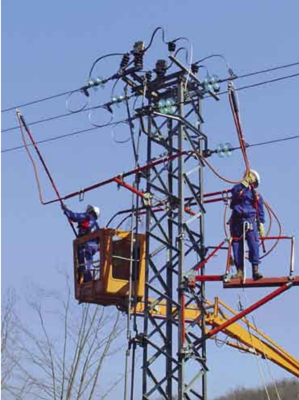
Postavljanje premosnice za potrebe održavanja FLA sklopke iz standardne korpe HEP-a s izolacijske platforme
