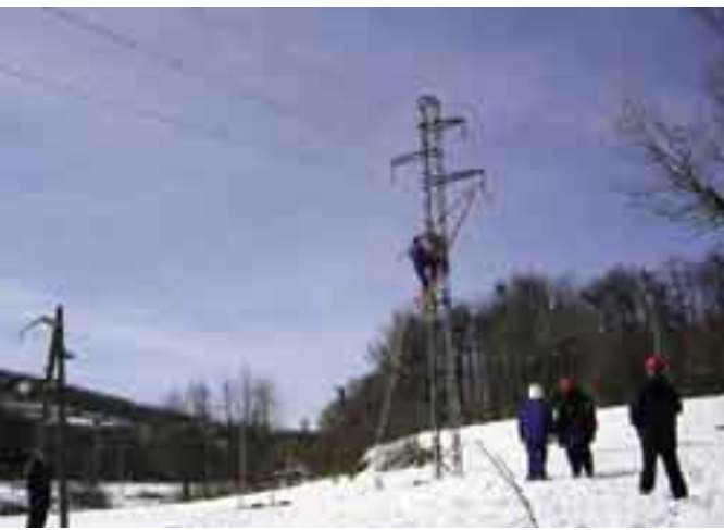
Prva vježba: naučiti postavljati opremu na čelično-rešetkasti stup
