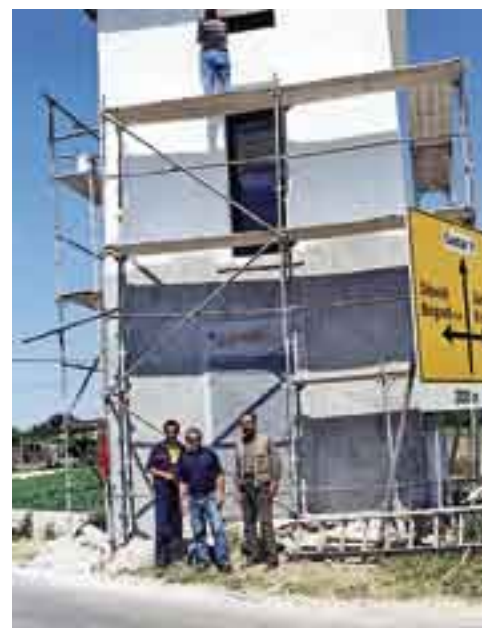
Radove na obnovi RTS Sukošan prate poslovoda Stanko Burčul i elektromonter Nikola Pavić, a ovdje je danas u obilasku i rukovoditelj Zdravko Zubčić
