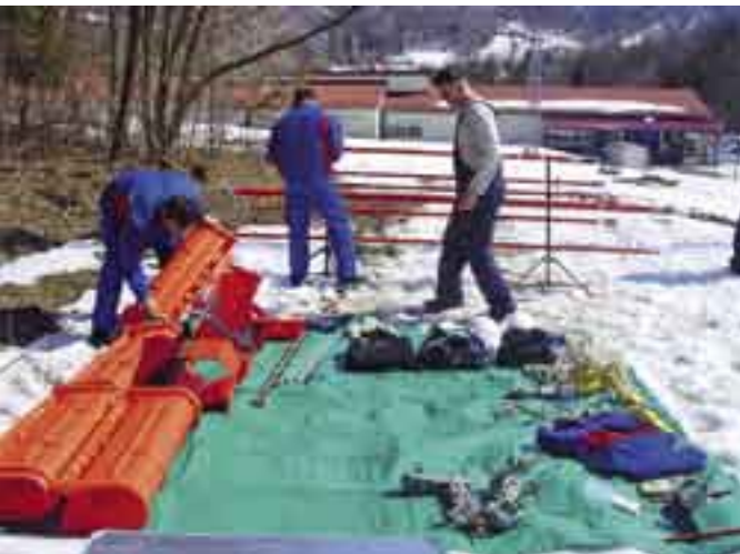
Silikoniziranje izolacijskih motki i priprema opreme na poligonu
