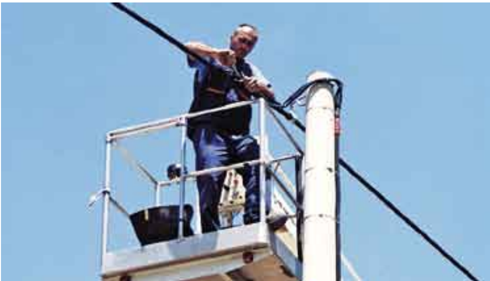
Ante Dijan spaja kabelski priključak na stup
