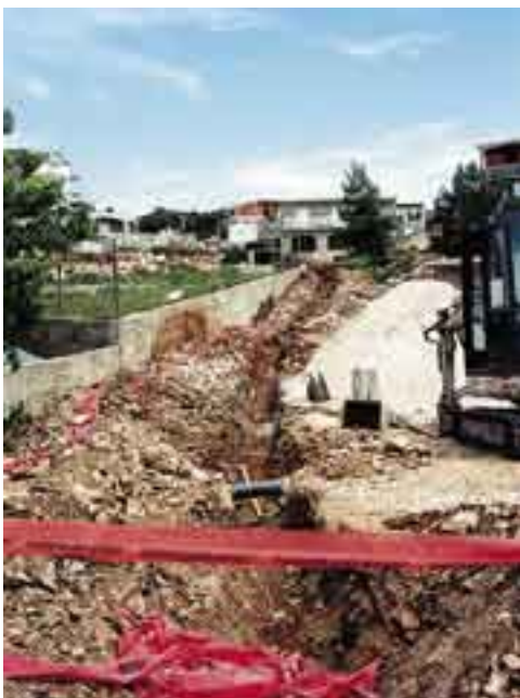
Nova kableska trasa za obnovljenu TS Hvar 18 u Vrisku Gornjem
