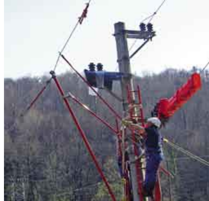
Izmjena dvostrukog zavješnja i izolatora na kutnom stupu upotrebom stabilizirane zglobne triangulacije
