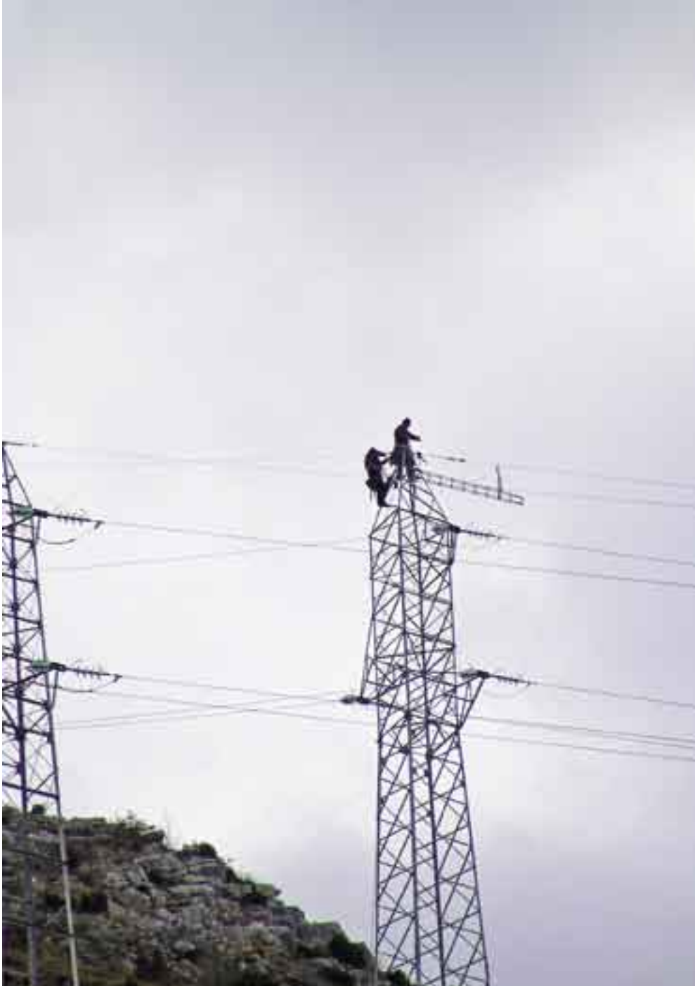
Ekipe Dalekovoda na trasi DV Plat – Cavtat
