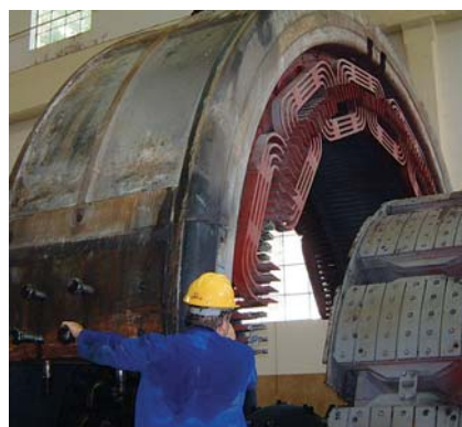
...i demontaža polovice statora
