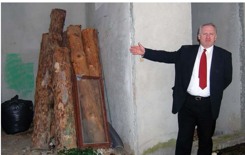
Rukovoditelj I. Udovičić pokazuje građevinski dovršenu TS Gojavu (s malo čudnom opremom)
