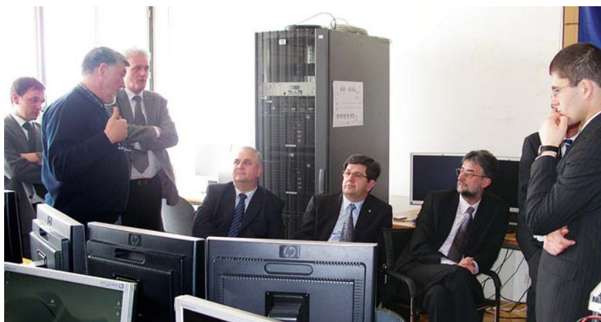
Ovdje je srce cijelog sustava – ormar sa serverima, a tu su i radne stanice s monitorima, koje omogućuju jednostavniji rad dispečera
