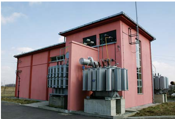
TS Branjin vrh primjer je dobro provedene obnove
