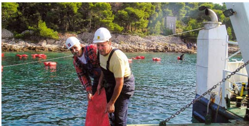
Novi kabel nježno na kušinima ulazi u priobalnu zaštitu bračkog rta Ražanj
