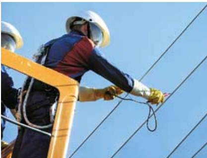
Ispitivanje prisutnosti napona na mjestu rada
