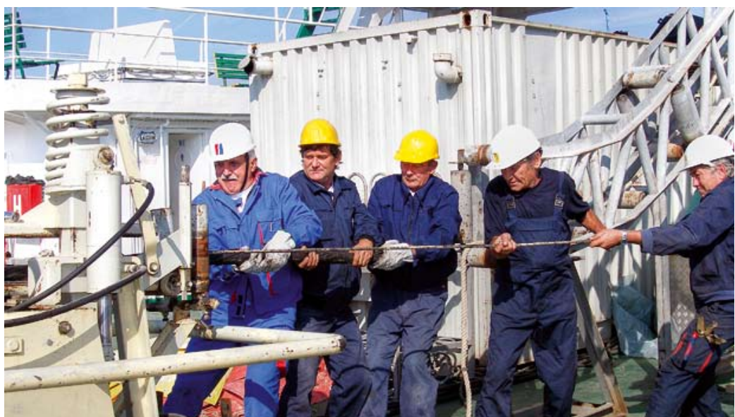
Izvlačenje starog kabela iz mora blizu Ošljaka
