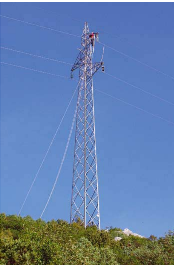
Zamjena izolatora na jednom od deset stupova, na trasi od deset kilometara
