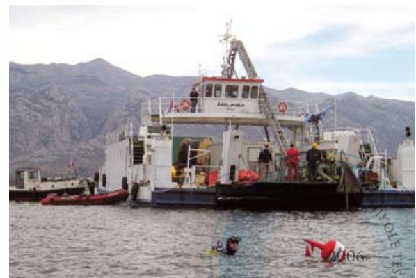
Ronilac prati ulazak kabela u priobalnu zaštitu Vinjerca
