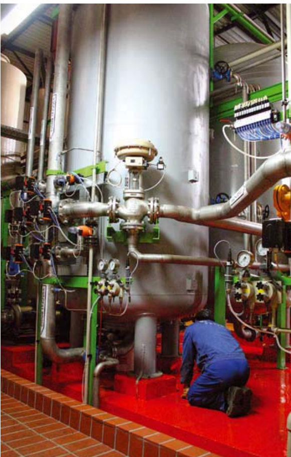
...novo postrojenje (završno ličenje linije za demineralizaciju)
