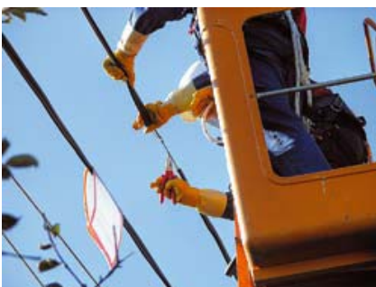
Izvođenje popravka AI-Če vodiča
